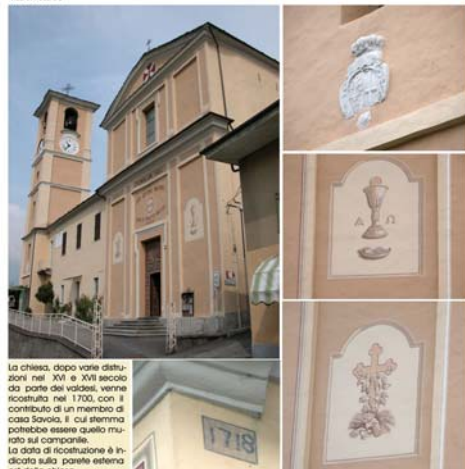
6.26 - CHIESA DI SAN MAURIZIO MARTIRE VILLAR PELLICE
