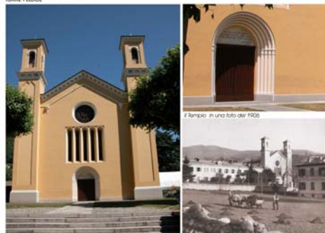
2.2 - TEMPIO VALDESE TORRE PELLICE
