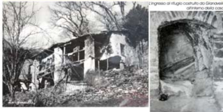
L'ingresso al rifugio costruito da Giavanello all'interno della casa
