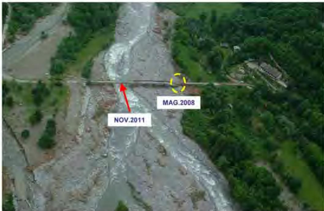
Foto 3: Torre Pellice ponte Bertenga. Immagine del crollo del maggio 2008; la parte crollata venne poi ricostruita come rilevato. La freccia indica la campata crollata il 6 novembre 2011 alle 11.15.
