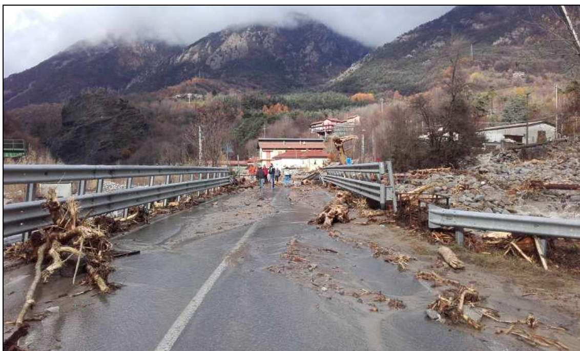
S.P. 23 del Colle del Sestriere - km 56+150 – Comune di Perosa Argentina Rimozione colata detritica in prossimità attraversamento rio Agrevo
