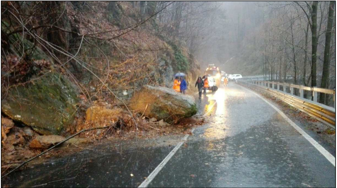
S.P. 32 della Valle di Viù (località Mondrezza) - km 10+600. Caduta massi
