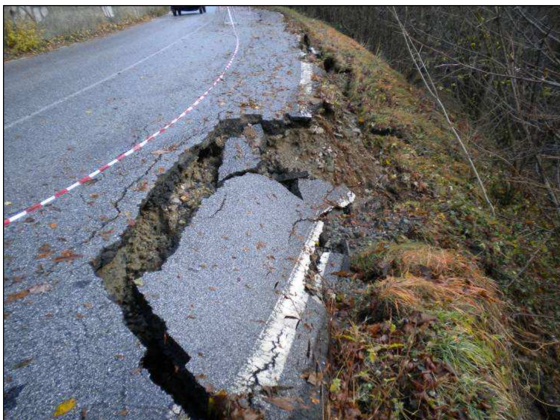
S.P. 162 di Ternavasso - km 5+430 – Comune di Rorà Messa in sicurezza corpo stradale mediante opera di sostegno a valle
