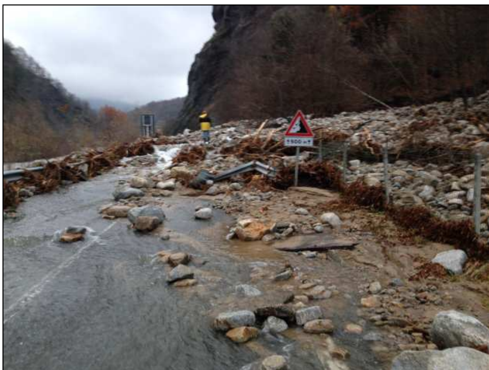
S.P. 23 del Colle del Sestriere - km 56+700-56+850 – Comune di Perosa Argentina Rimozione colata detritica in prossimità attraversamento rio Brandouneugna
