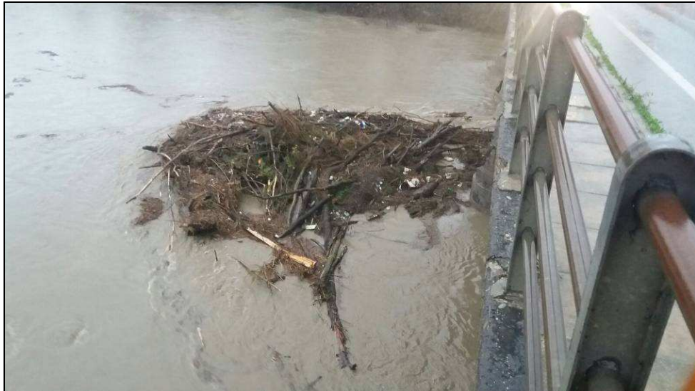
S.P. 20 del Colle di Tenda – (Ponte sul fiume Po al km 14+200) – Deposito di materiale in corrispondenza di spalle e pile (rif. intervento 30)
