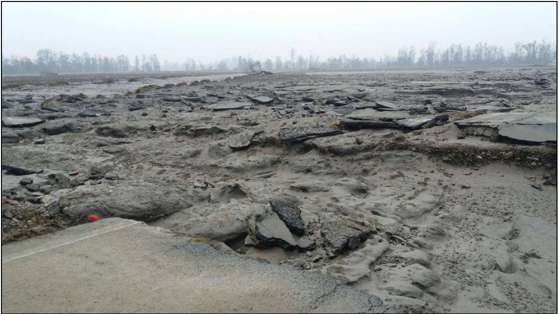
S.P. 149 di Pancalieri – Asportazione del corpo stradale per esondazione del fiume Po in comune di Pancalieri
