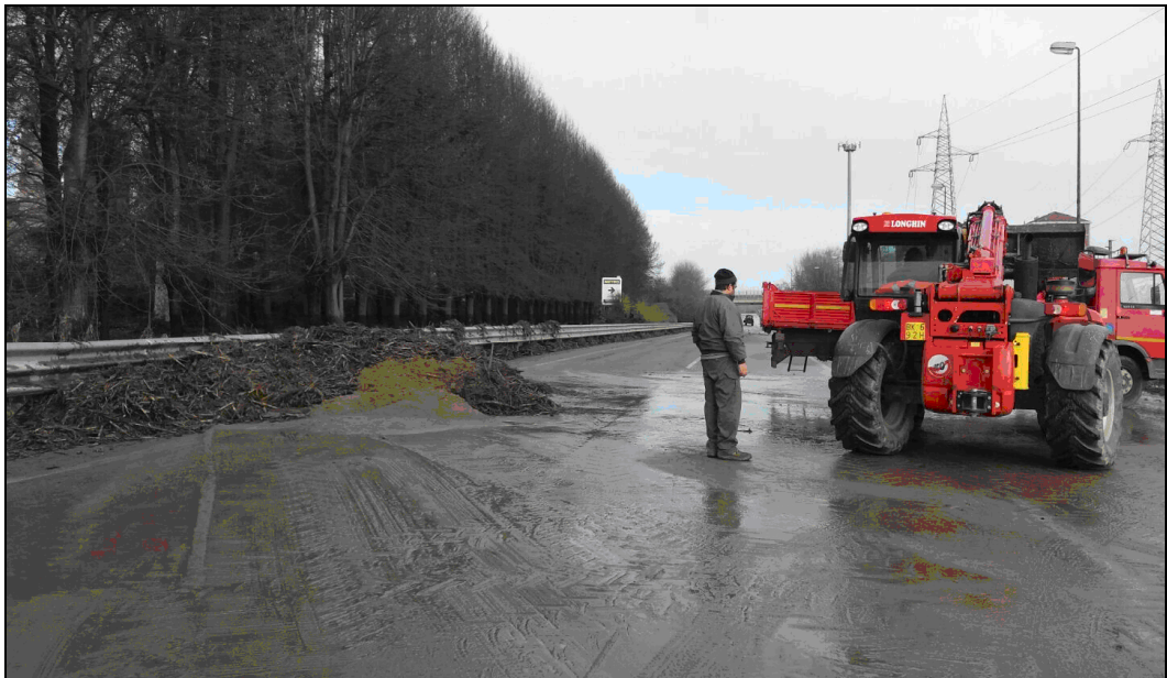
S.P. 20 (VARIANTE di CARIGNANO) – Allagamento con trasporto di materiale sulla sede stradale al km 1+500
