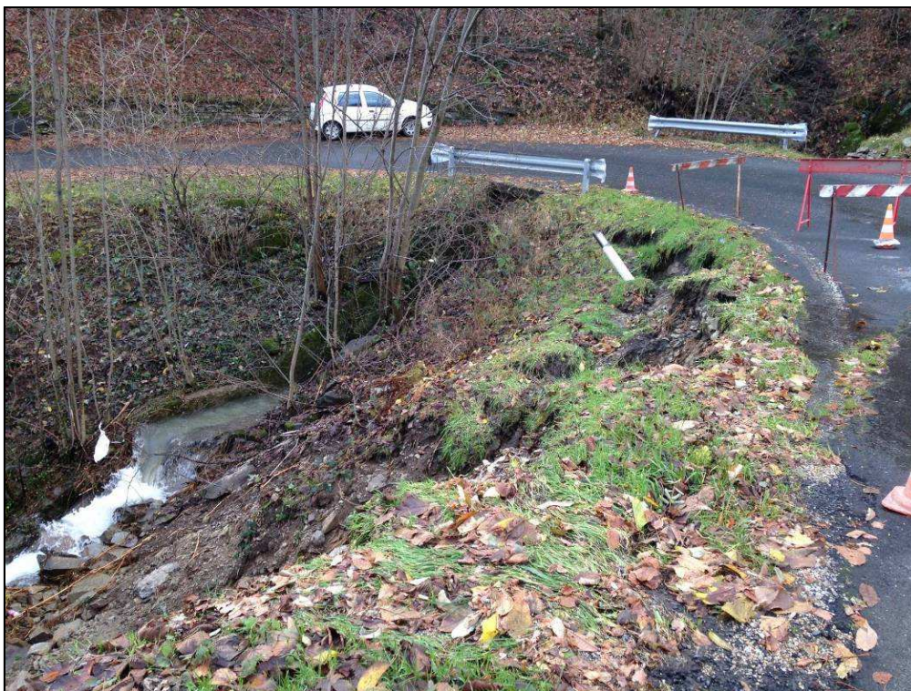
S.P. 162 di Ternavasso - km 7+200 – Comune di Rorà Messa in sicurezza corpo stradale mediante opera di sostegno a valle
