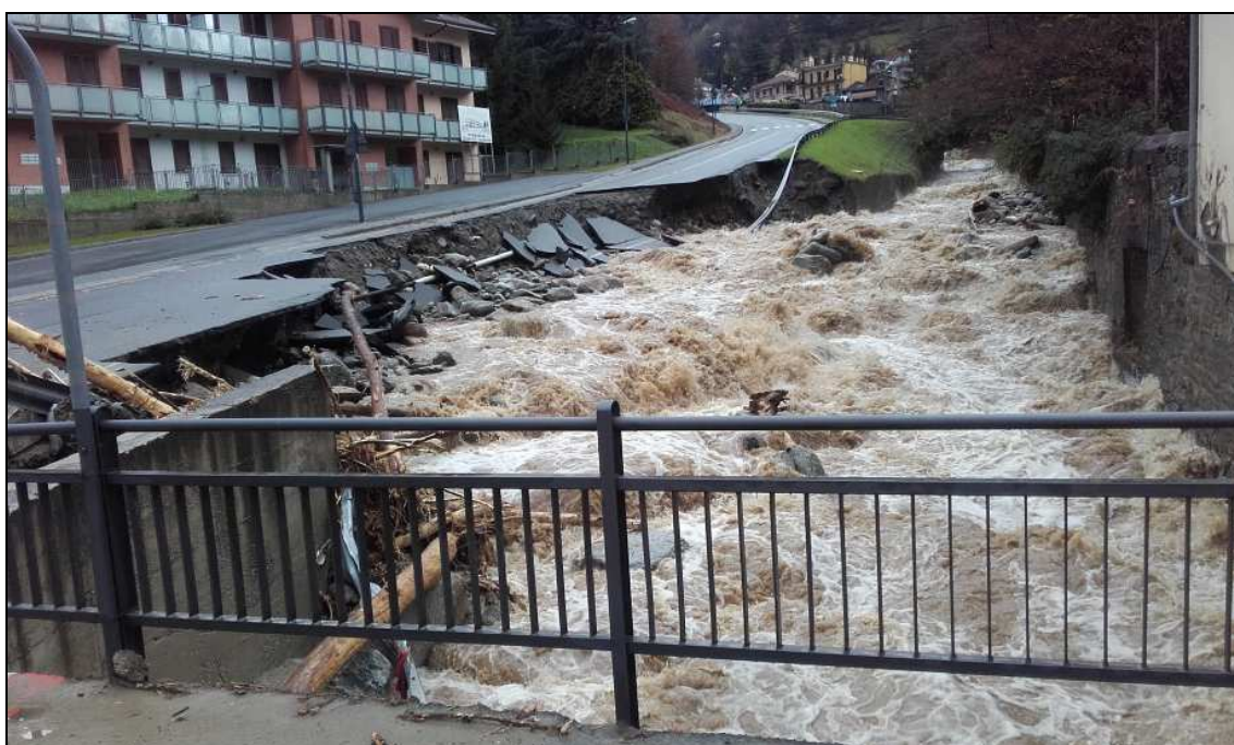
S.P. 169 della Val Germanasca - km 0+150 – Comune di Perosa Argentina Ricostruzione del corpo stradale a seguito del cedimento carreggiata in prossimità rio Albona
