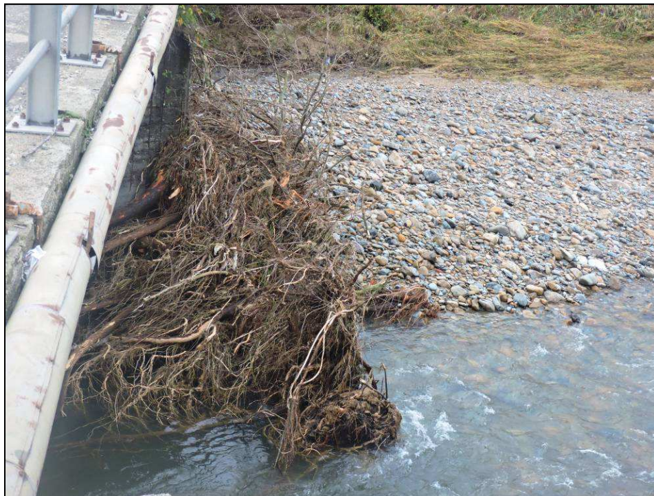
S.P. 8 di Druento – (Ponte sul torrente Casternone al km 17+550) – Deposito di materiale in corrispondenza di spalle e pile
