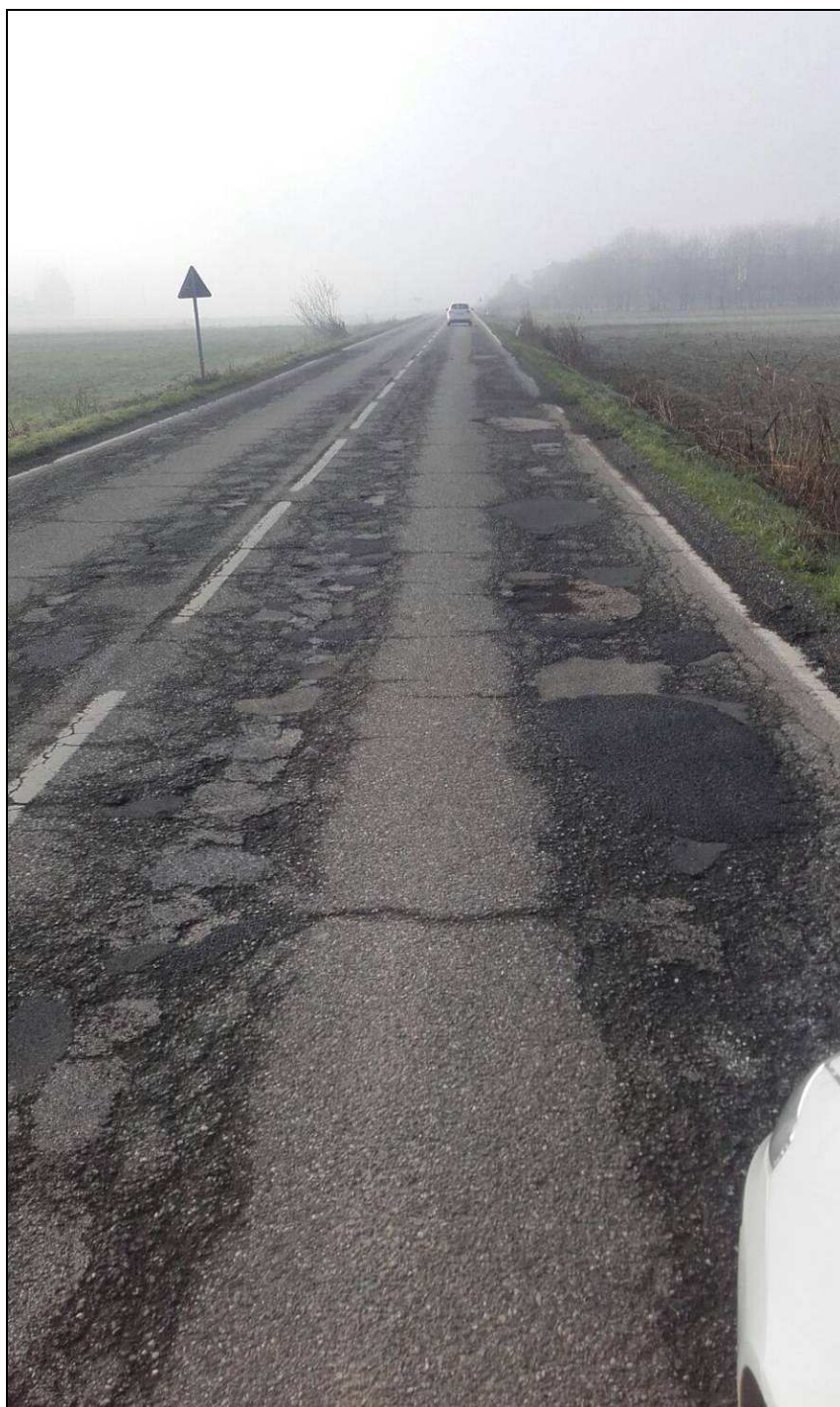
S.P. 140 di None – Danneggiamenti della sede stradale dal km 5+000 al km 11+800 a seguito di allagamenti, nei comuni di None e Candiolo
