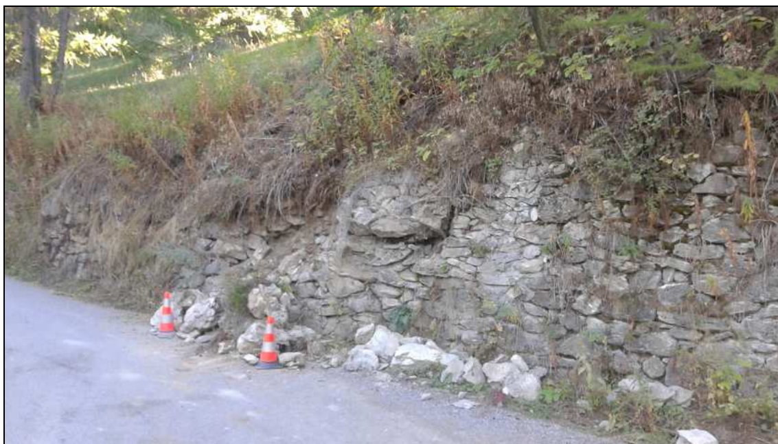
S.P. 236 della Stazione Alpina - km 3+600 – Comune di Sauze d'Oulx Ripristino muro a secco
