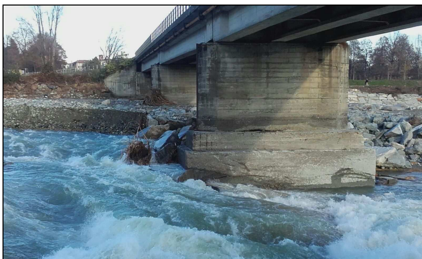
S.P. 724 di Villanova – km 1+400 – Ponte sul Torrente Stura. Scalzamento pile, e danneggiamento soglia.
