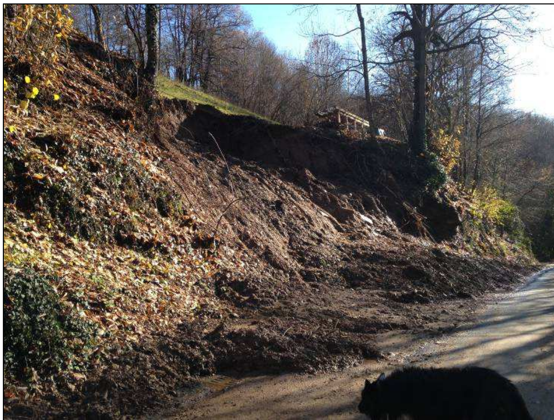
S.P. 163 di Angrogna - km 02+800 – Comune di Angrogna Frana scarpata a monte della strada
