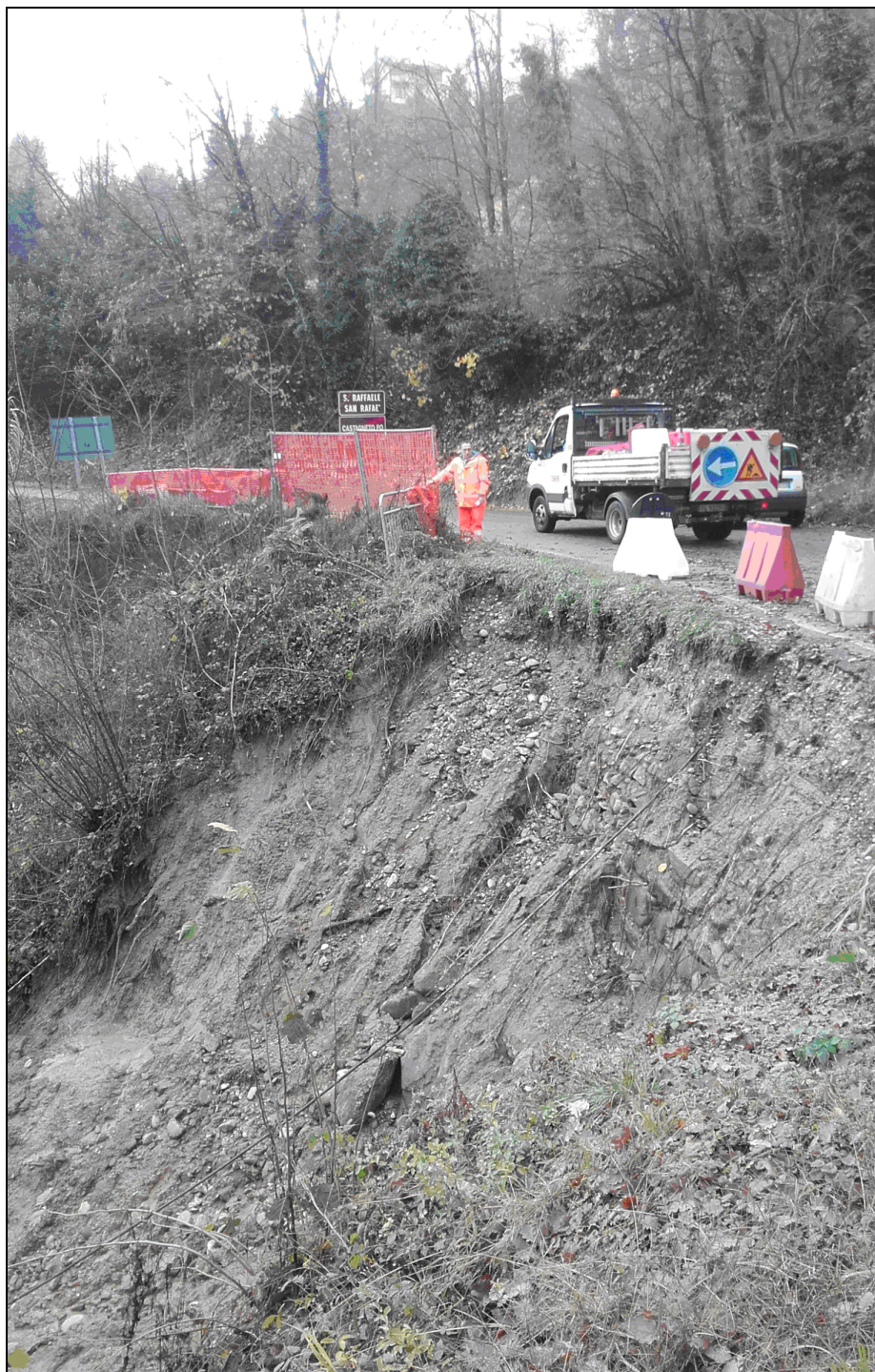
S.P. 99 di San Raffaele Cimena- Frana di valle al km6+250 in comune di San Raffaele Cimena
