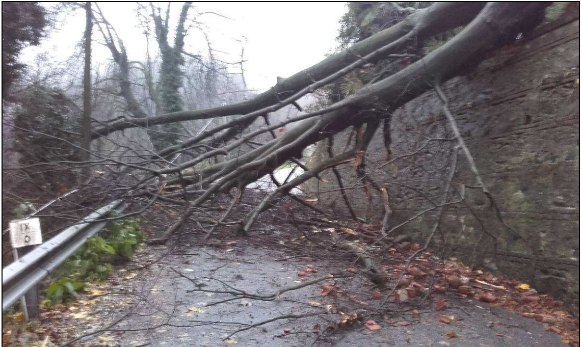
S.P. 99 di San Raffaele Cimena – Ostruzione sede stradale al km0+800 in comune di Castagneto Po
