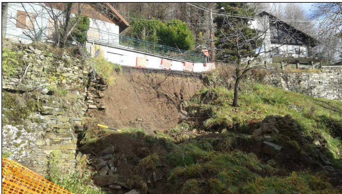
S.P. 197 del Colle del Lys - km 15+600 –Comune di Rubiana Frana versante a valle della strada
