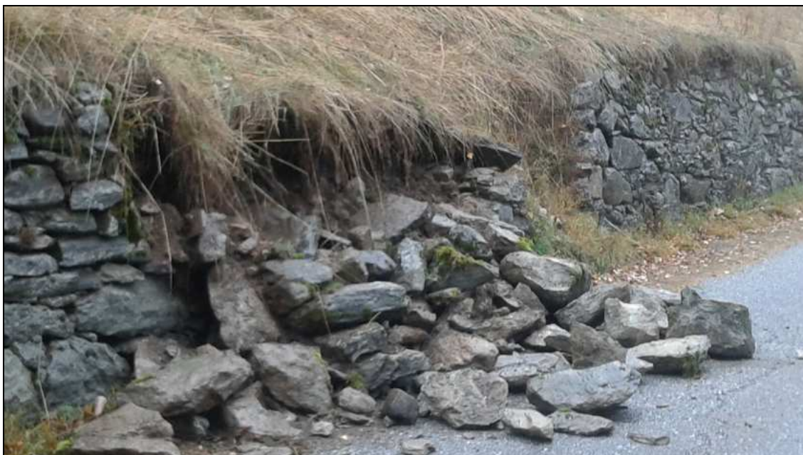
P. 232 di Devejs - km 2+400 – Comune di Exilles Ripristino muro a secco
