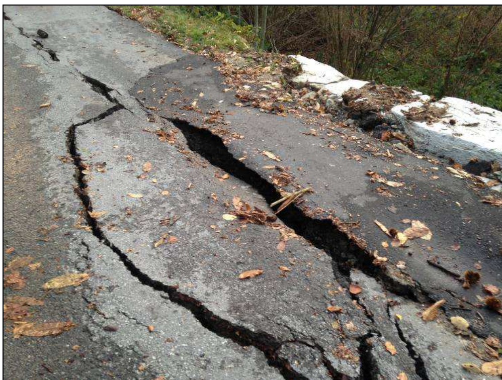
S.P. 167 della Val Lemina - km 06+800 – Comune di Pinerolo Cedimento corpo stradale con isolamento borgata Talucco
