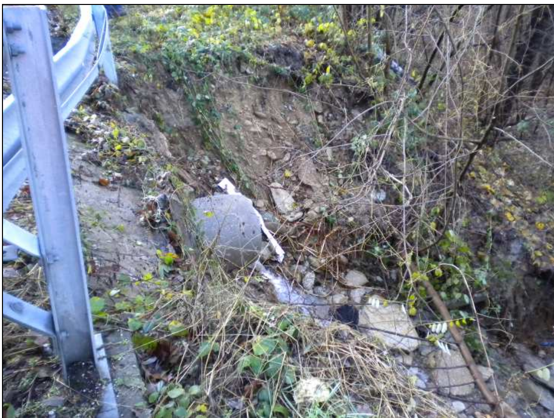
S.P. 156 di Lusernetta - km 01+550 – Comune di Lusernetta Cedimento banchina e attraversamento stradale
