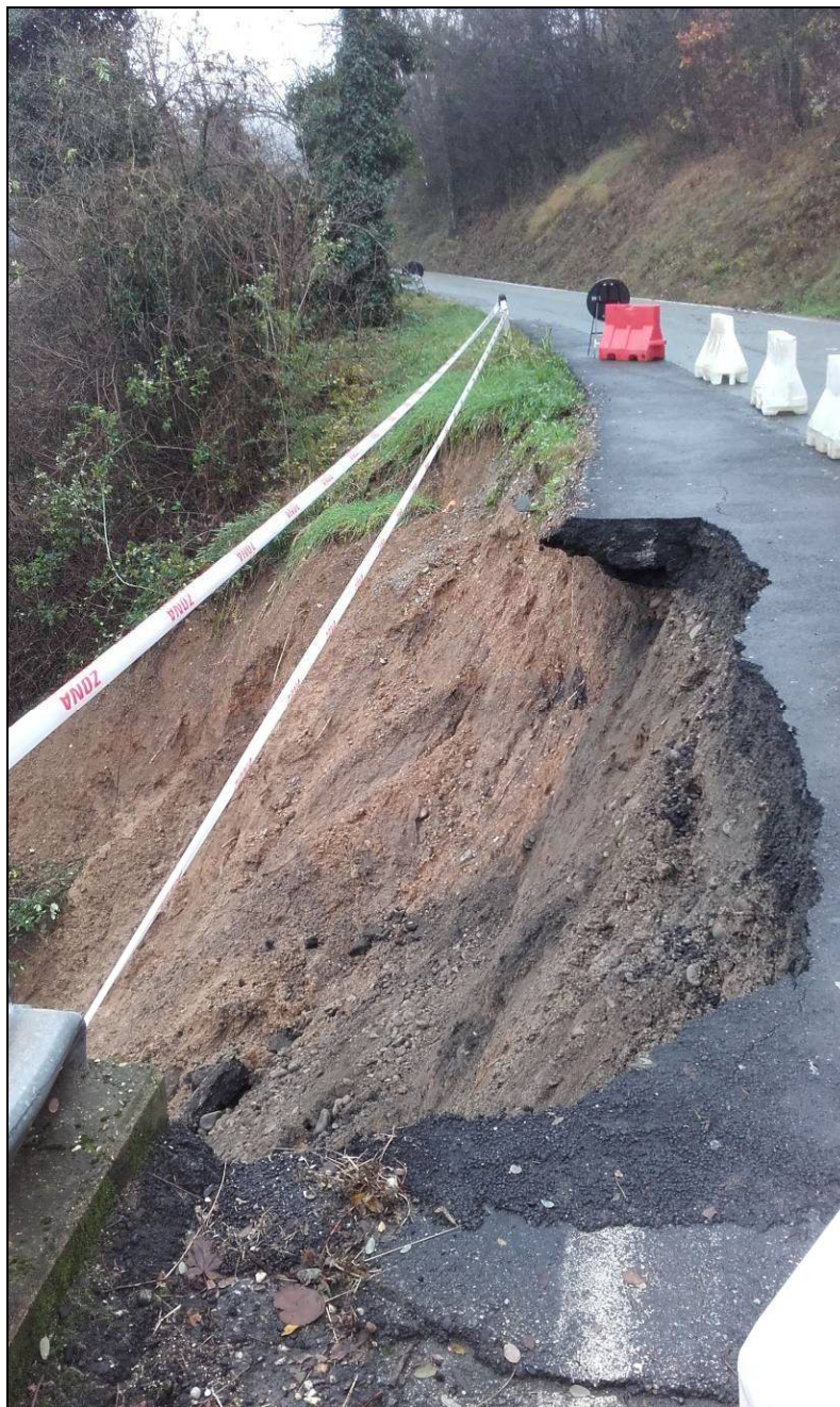
S.P. 117 di Cordova – Frana di valle al km1+450 in comune di Castiglione T.se
