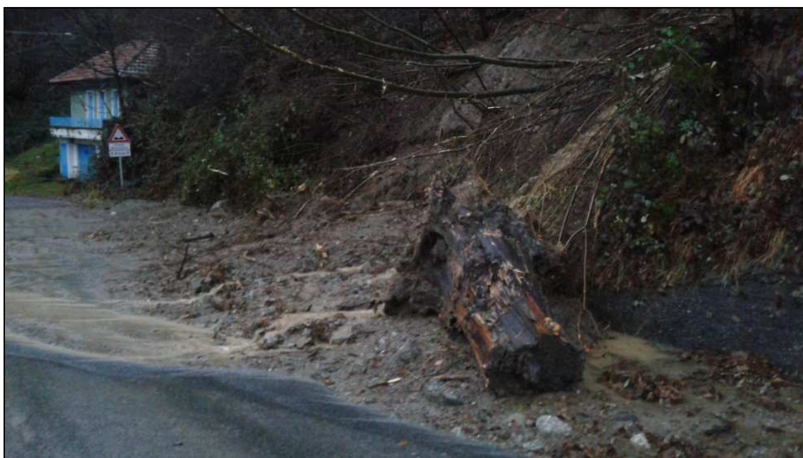
S.P. 197 del Colle del Lys - km 14+600 Comune di Rubiana Frana versante a monte della strada
