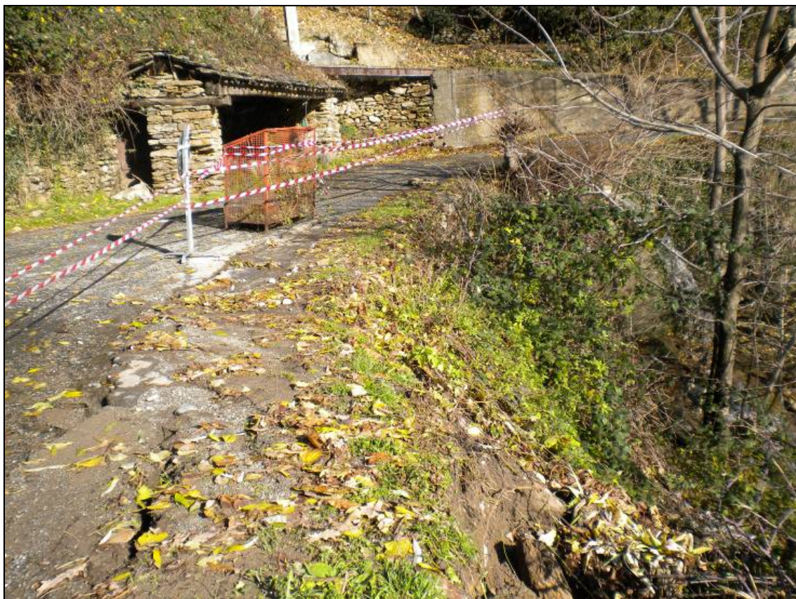
S.P. 258 di Indritto - km 2+100/2+500/3+100 – Comune di Villar Pellice Ripristino di muri sottoscarpa
