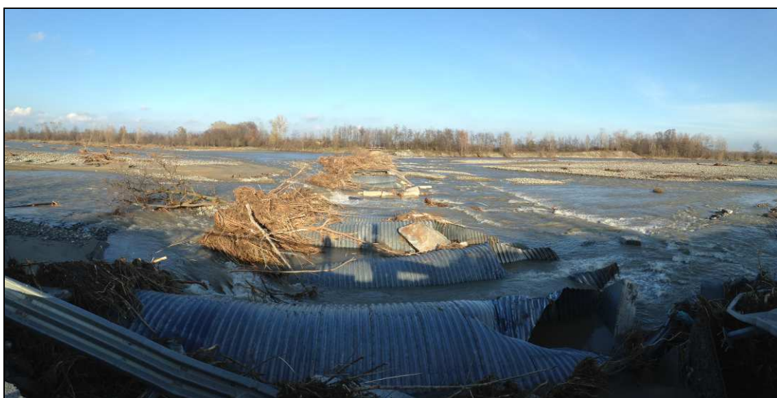
S.P. 152 di Zucchea - km 6+200 – Comune di Cavour Torrente Pellice: ricostruzione guado
