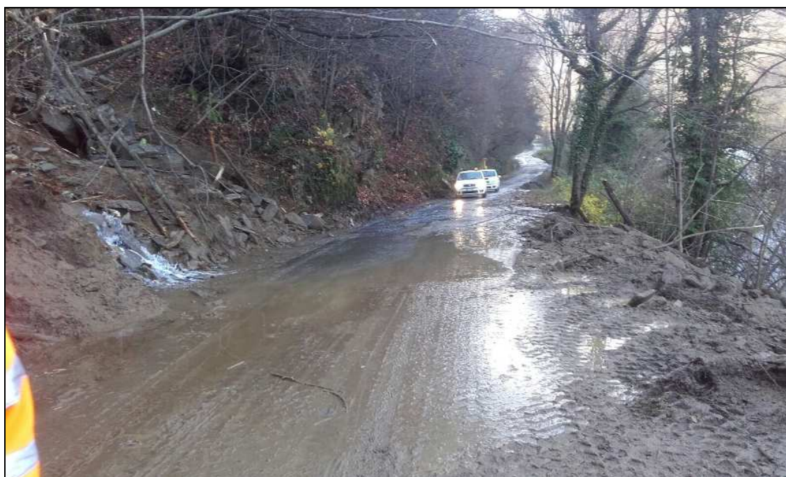
S.P. 166 della Val Chisone - km 03+500 – Comune di San Germano Chisone Ripristino attraversamento idraulico e regimazione acque
