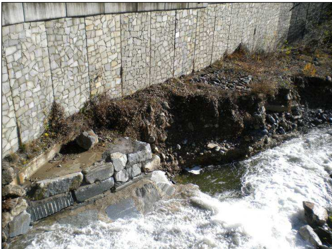
S.P. 161 della Val Pellice - km 18+700 – Comune di Villar Pellice Erosione sponda a valle del ponte sul rio Rospart
