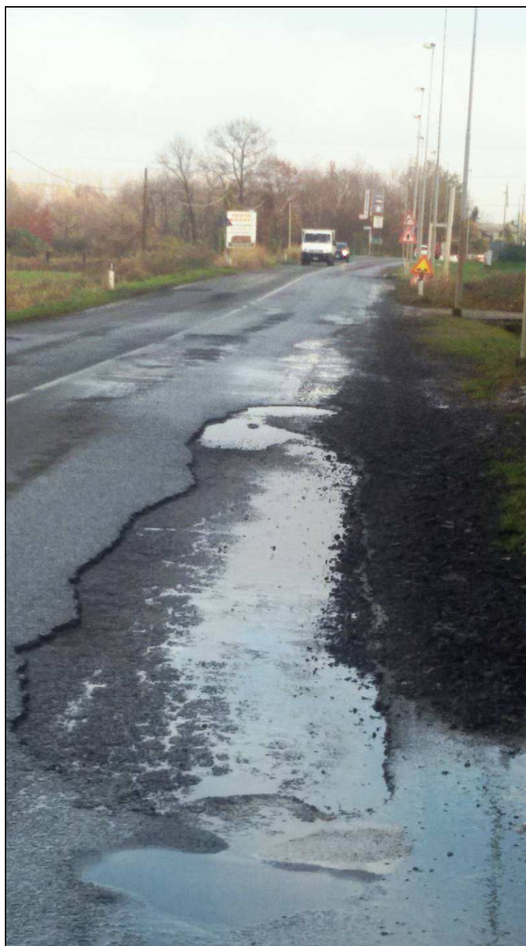
S.P. 177 di Val della Torre – Formazione di buche profonde a seguito di allagamenti, in comune di San Gillio
