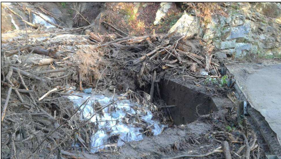
S.P. 227 della Provonda - km varie - Comune di Giaveno Frane e colate sulla sede stradale
