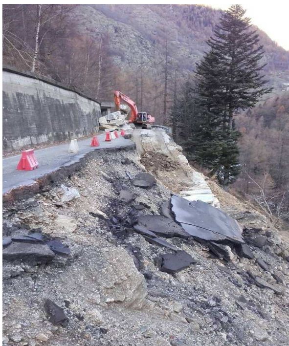
S.P. 169 della Val Germanasca - km 16+700 – Comune di Prali Ricostruzione del corpo stradale a seguito di crollo muro sottoscarpa
