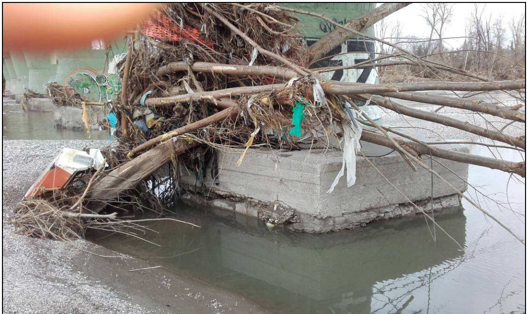
S.P. 92 di Castiglione T.se – (Ponte sul fiume Po al km 1+200) – Deposito di materiale in corrispondenza di spalle e pile
