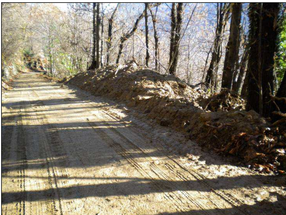
S.P. 258 di Indritto - km 4+500 – Comune di Villar Pellice Consolidamento versante a monte della sede stradale
