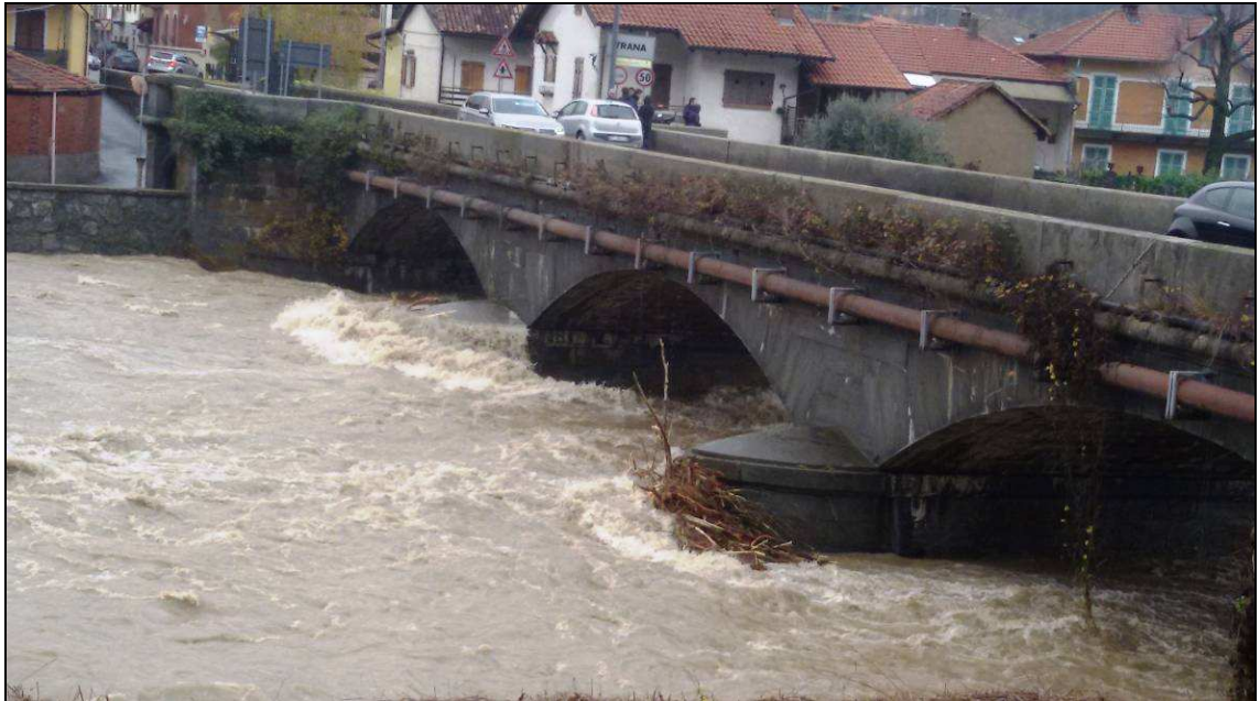
S.P. 589 dei Laghi di Avigliana – (Ponte sul torrente Sangone al km 7+270) – Deposito di materiale in corrispondenza di spalle e pile
