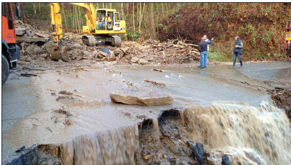
S.P. 167 della Val Lemina - km 06+200 – Comune di S. Pietro Val Lemina Colata detritica e intasamento attraversamento
