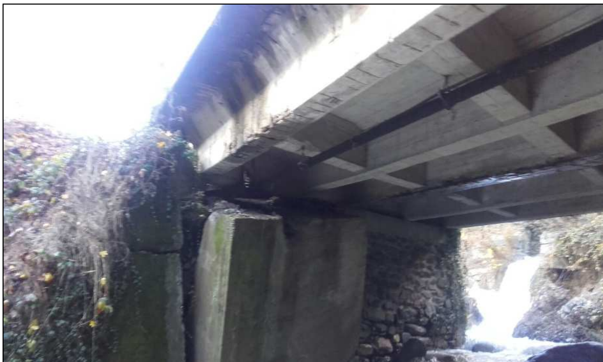
S.P. 168 di San Germano Chisone - km 03+000 – Comune di Pramollo Cedimento parziale spalla ponticello rio dei Bosi
