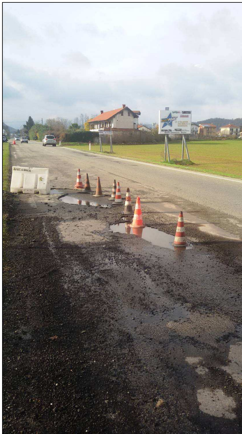
S.P. 183 di Bruino – Formazione di buche profonde a seguito di allagamenti, in comune di Bruino
