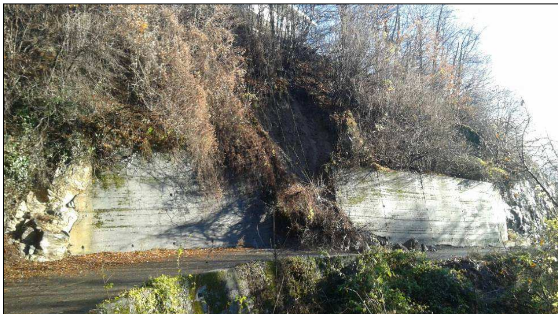
S.P. 197 dir. Celle - km 3+700 - Comune di Caprie Frana versante a monte della strada
