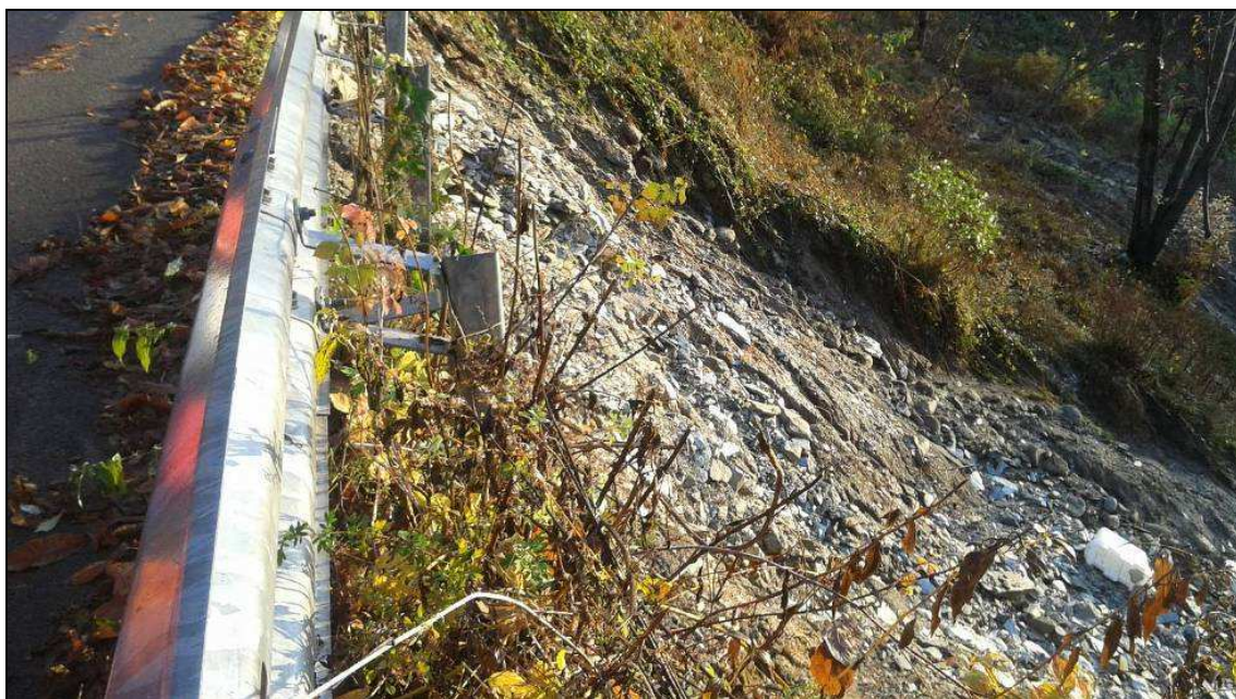
S.P. 227 della Provonda - km 5+600 – Comune di Giaveno Frana versante a valle della strada
