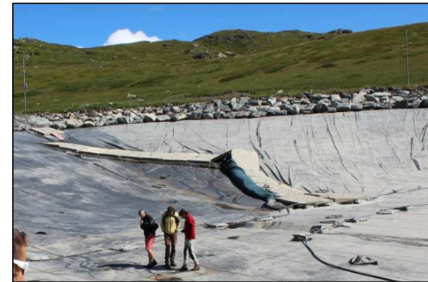
Rupture de la rampe : endommagement de l'ensemble de la rampe et du DEG sous-jacent
