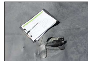
Exemple de dégradation de DEG par poinçonnement sur des retenues d'altitude
