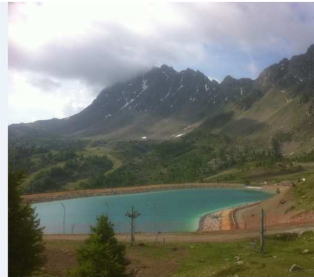
Retenue de Chabrières (Vars)
