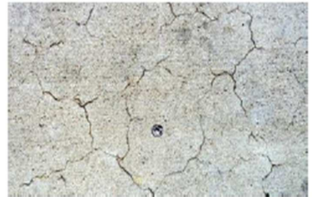
Exemple de fissuration précoce dans le béton
