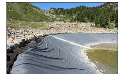
Glissement en parement amont
