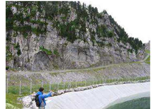
Retenue d'altitude soumise aux chutes de blocs
