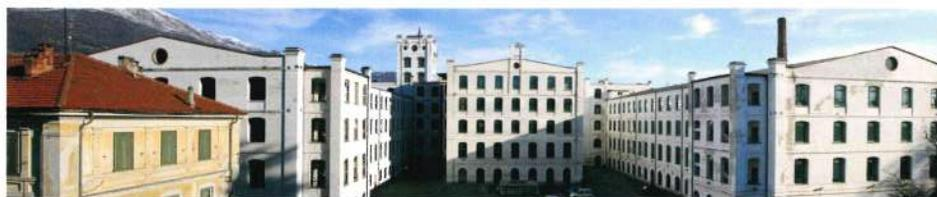
L'originalità del progetto e delle varie soluzioni adottate nel fabbricato industriale, come le colonne in ghisa a sostegno dei piani portanti dei pavimenti in legno a doppia soletta, i serramenti delle finestre, la disposizione delle scale e dei vari ambienti lavorativi e di servizio, riscosse interesse al tal punto che già nel 1890 la Manifattura veniva presa come modello da imitare, visitato e pubblicato dai più prestigiosi testi scientifici dell'epoca.
