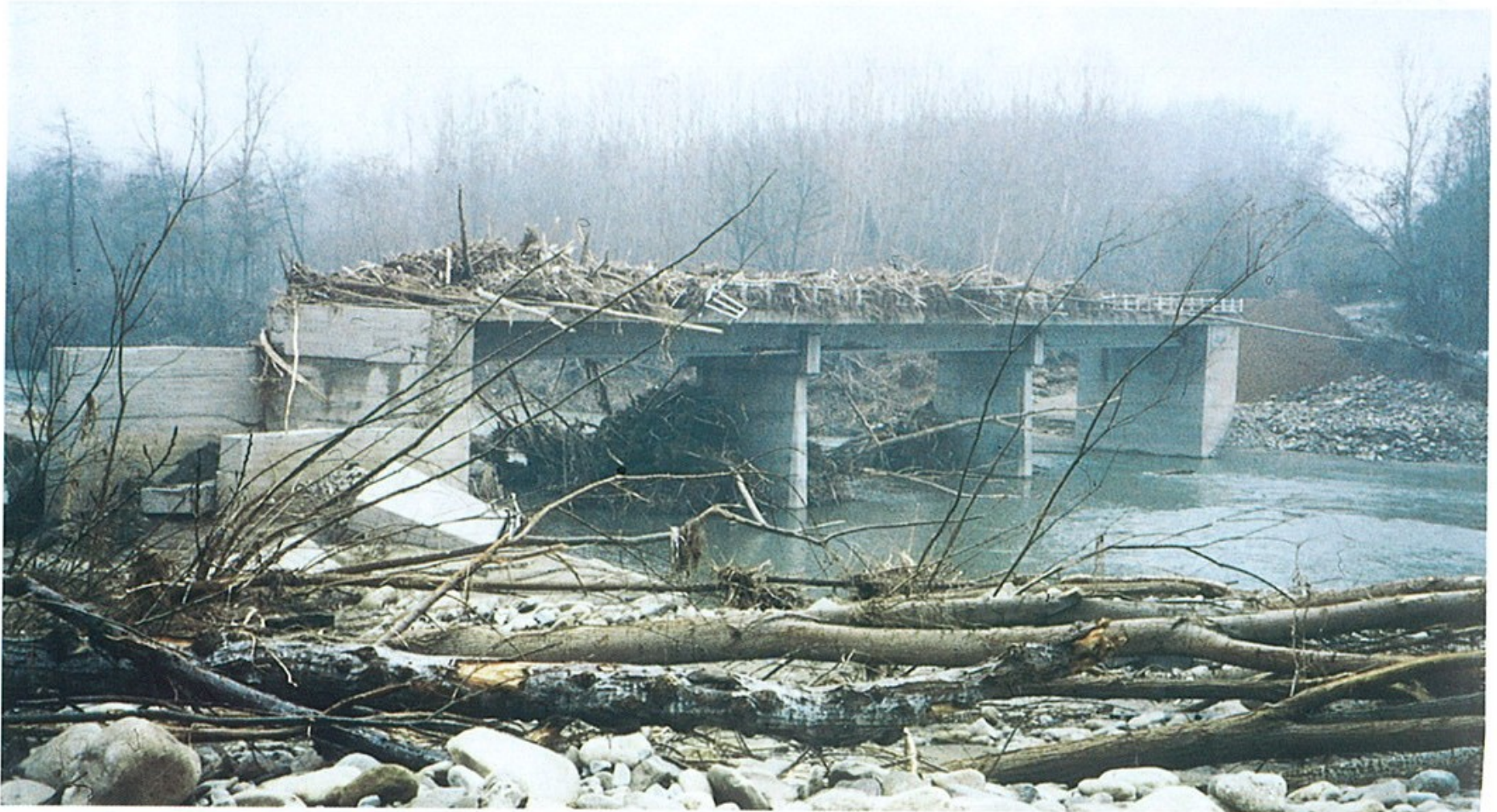
Fig. 13 Immagine del ponte posto a valle di Niella Tanaro; risulta completamente ostruito da una grande quantità di
