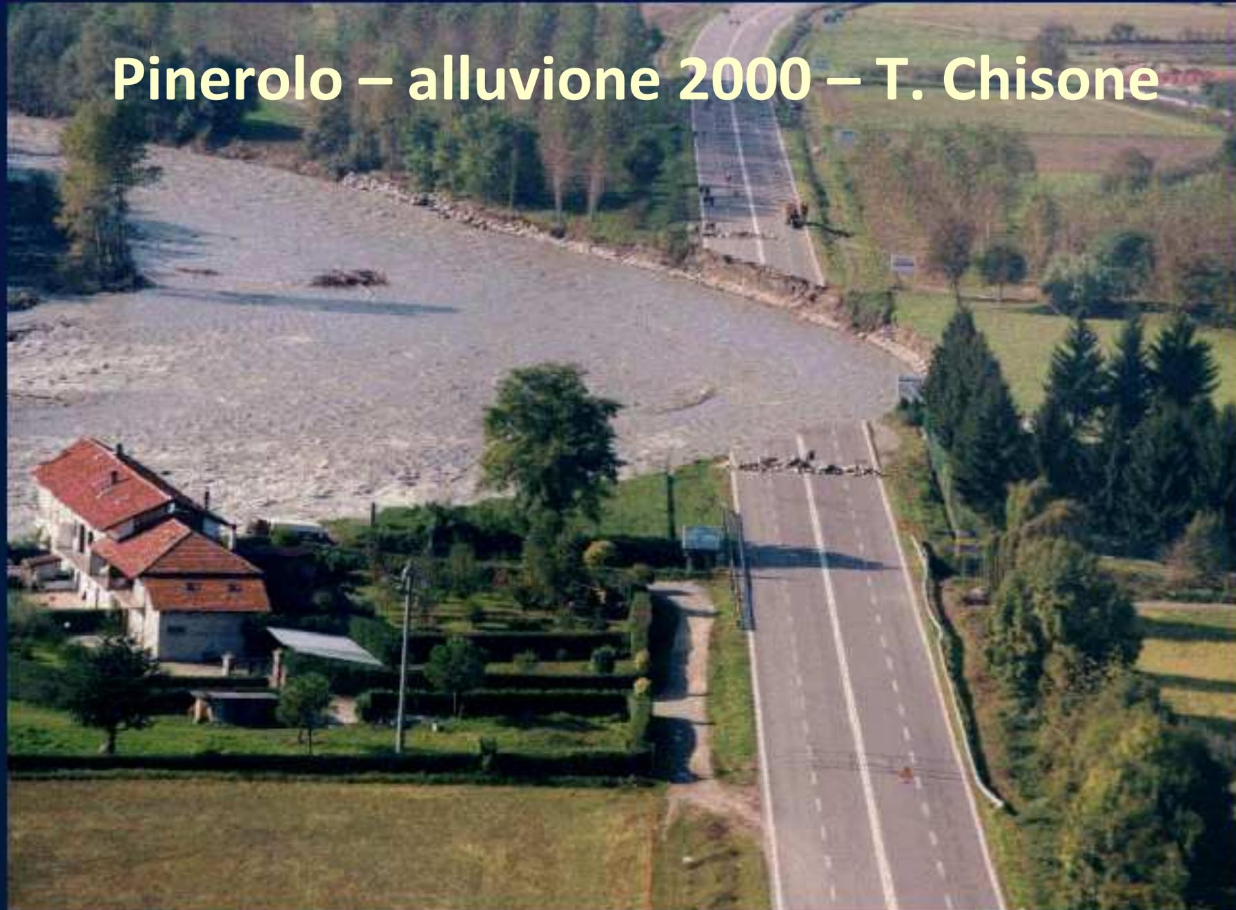
Tangenziale. L'accentuata erosione in sponda sinistra del torrente Chisone ha oltrepassato il limite stradale, asportando il corpo stradale su una lunghezza di circa 150 m.
