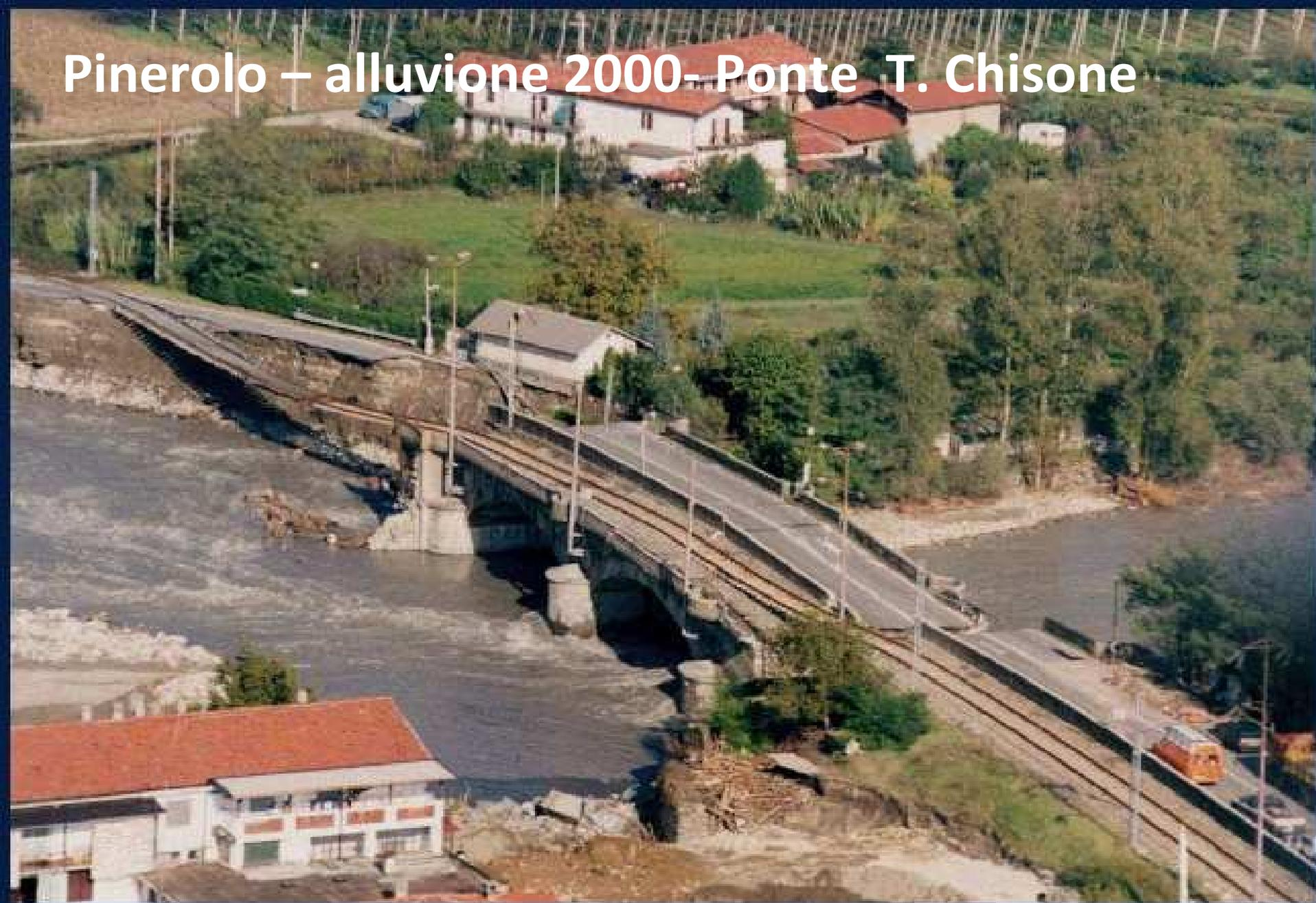
Via Saluzzo. Visibile l'erosione della spalla sinistra dell'attraversamento e il taglio dell'arcata di destra, determinata dal cedimento parziale della pila.
