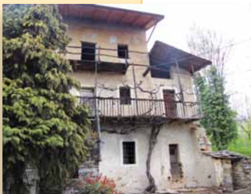
Costruzione rurale nella Frazione Picchi
