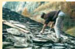
Sistemazione di lose su un tetto
