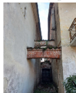
Edificio oggetto di recupero fronte sud verso Cassa Municipale
