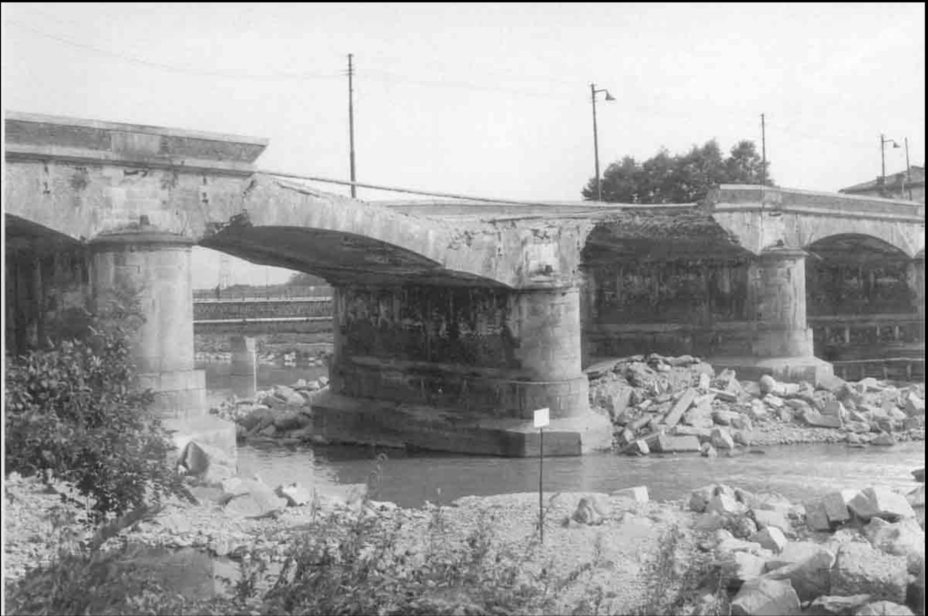
**Stura di Lanzo a Torino - sett 1961, crollo del ponte Vittorio Emanuele per sottoescavazione delle pile dovuta ad escavazioni in alveo**
