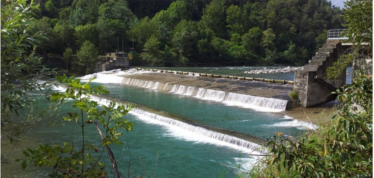
L'OPERA DI PRESA PRINCIPALE E' LA TRAVERSA A LANZO TORINESE, A SERVIZIO DELLE DERIVAZIONI IN SPONDA SINISTRA E DESTRA:
