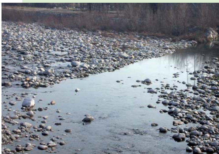
Sbarramento precario a servizio di una derivazione irrigua
