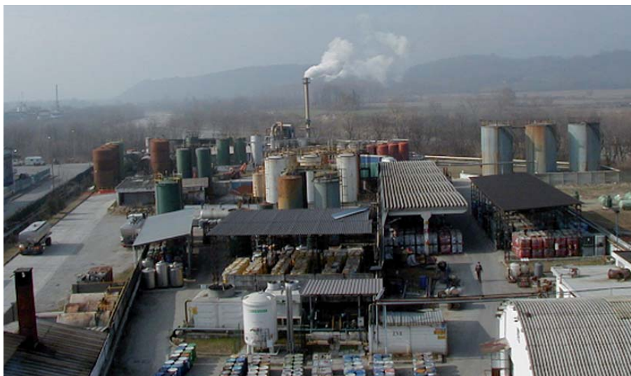
Insedimento ex Chimica Industriale - da Relazione di MWH S.p.A. (Milano) per la Provincia di Torino su "Attività di verifica impiantistica e di operatività di due impianti di smaltimento/recupero rifiuti della provincia di Torino. Rapporto - Rev.1 - Chimica Industriale".
