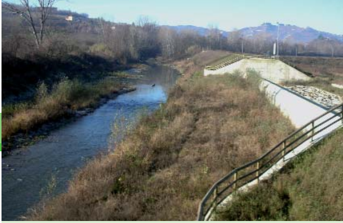
Tratto di torrente Belbo con in evidenza lo sfioratore di ingresso della cassa di espansione di Canelli.
