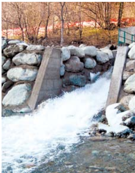
Manufatto di restituzione a cielo aperto
