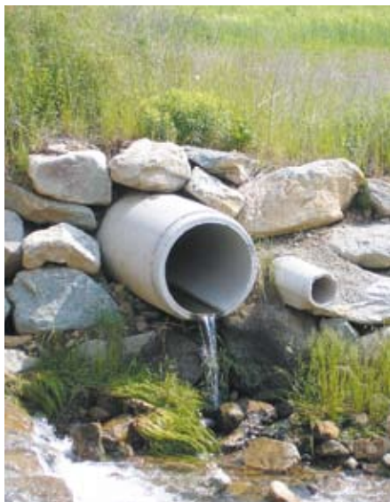
Protezione con pietrame di un manufatto di scarico
