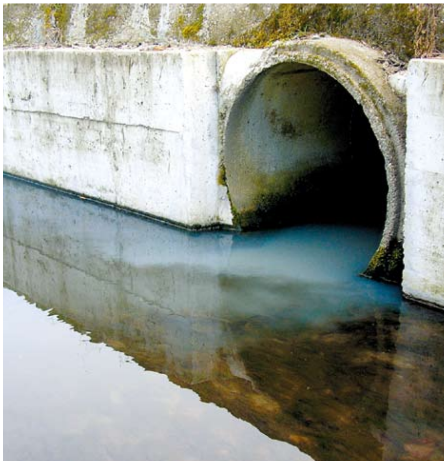
Manufatto di immissione in calcestruzzo
