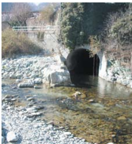
Galleria di restituzione
