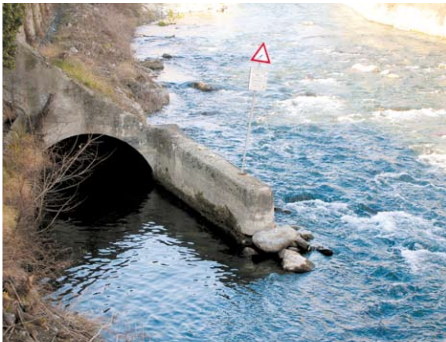
Galleria di restituzione con annesso segnale di pericolo
