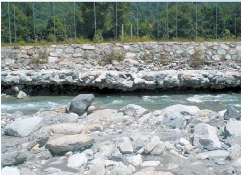
Scogliera con fondazioni sospese a causa dell'erosione. È necessaria una sottofondazione
