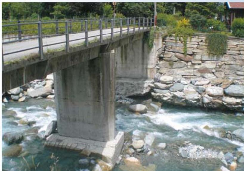
Erosione sotto le fondazioni della spalla sinistra
