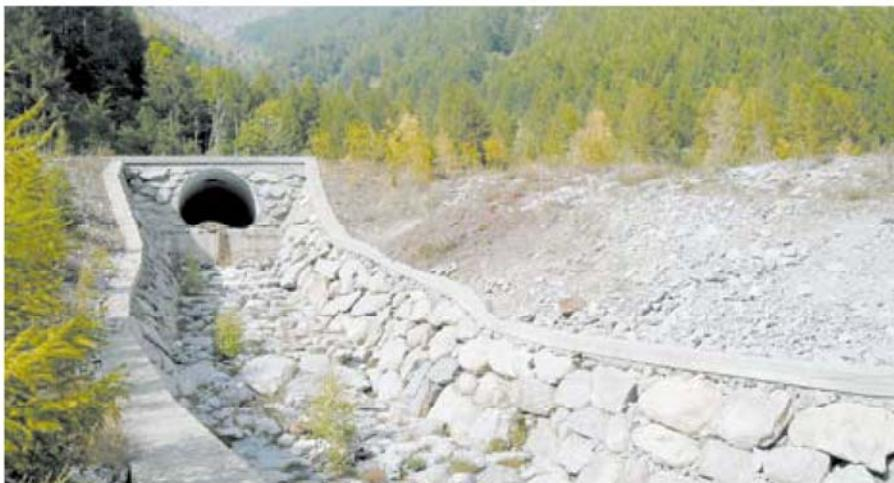
Attraversamento tipologia tubazione e canalizzazione a sezione aperta in massi d'alveo
