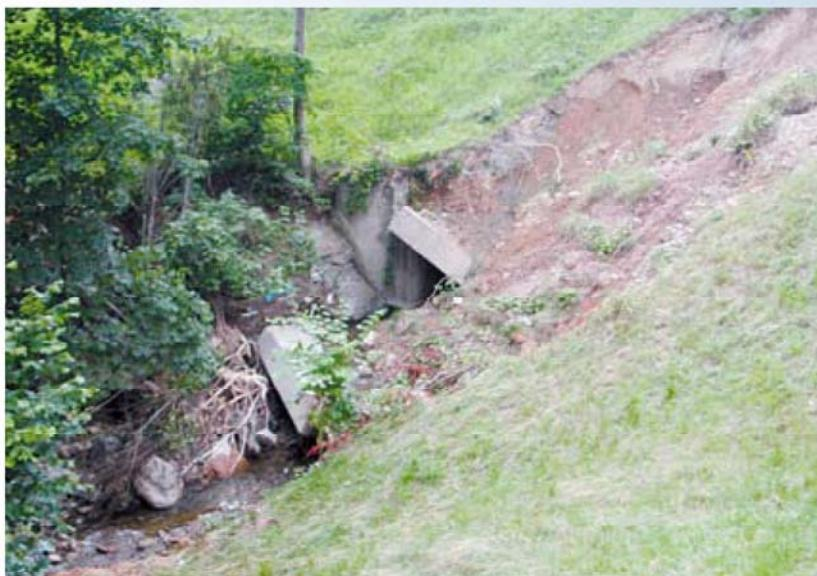
Sbocco di un attraversamento in dissesto strutturale
