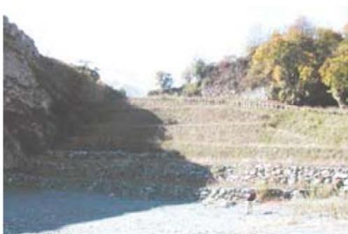
Versante riprofilato con successioni di gradoni realizzati con materiale di riporto
