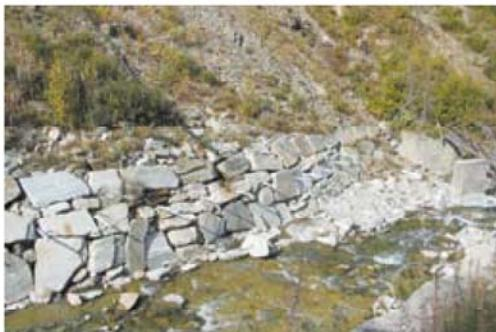
Allontanamento delle acque di infiltrazione con una batteria di dreni suborizzontali a canna drenante
