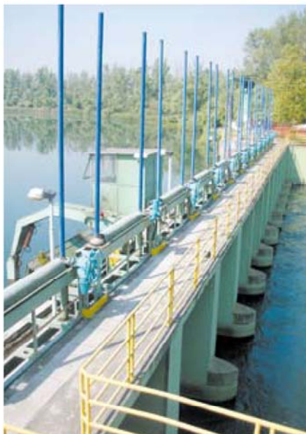
Organi di regolazione delle bocche di presa
