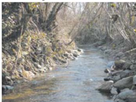
Canale derivatore irriguo realizzato in terra
