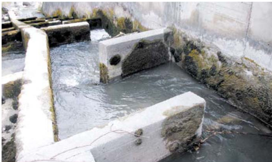
Particolare di passaggio a bacini
