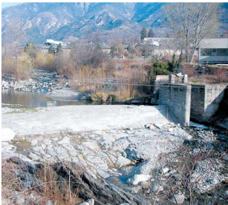
Traversa fissa in muratura con paratoia sghiaiatrice
