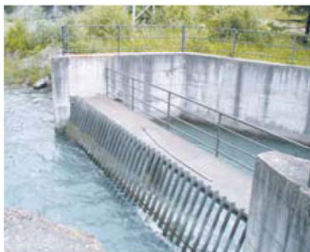
Griglia a protezione di un'opera di presa
