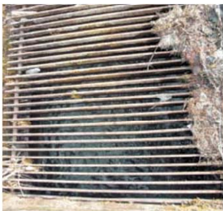
Griglia di presa, particolare
