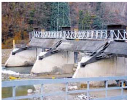
Sbarramento mobile con paratoie a settore in posizione di massima apertura
