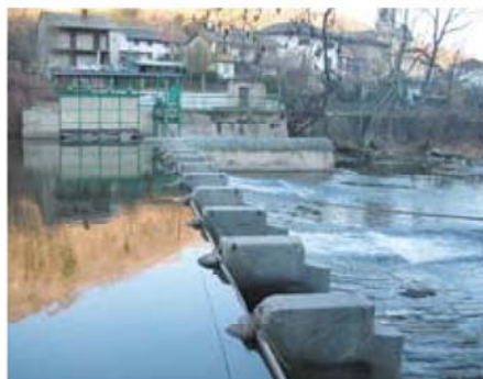
Traversa fissa con rialzo costituito da tavole di legno
