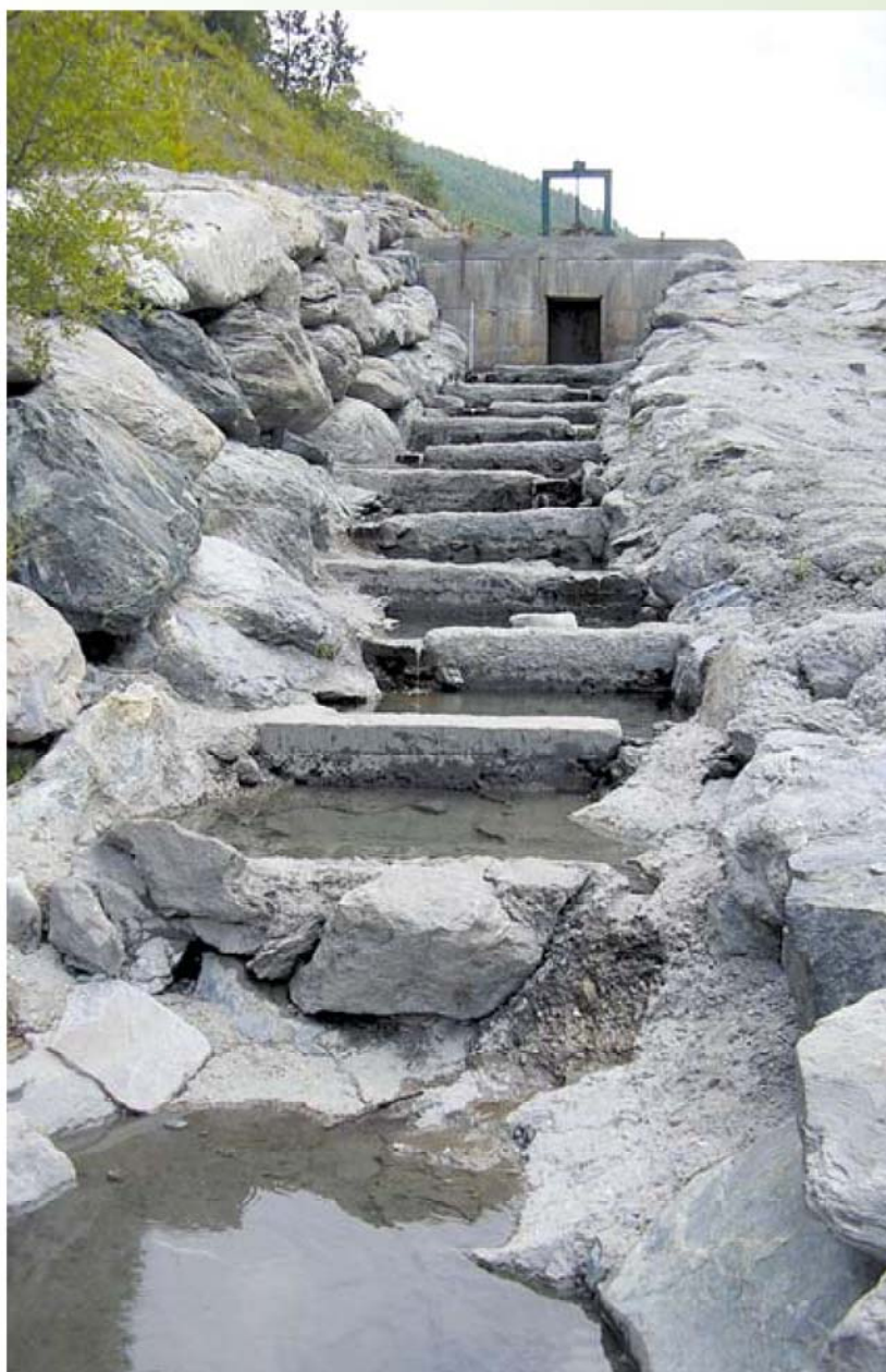
Passaggio a bacini successivi: la poca acqua presente rende la scala del tutto impraticabile ai pesci
