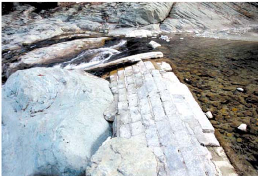
Rilascio da sezione di deflusso su sbarramento
