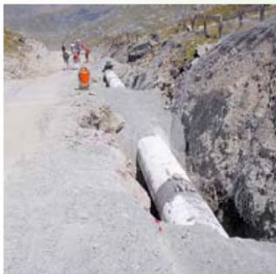
Cantiere di posa di una condotta forzata
