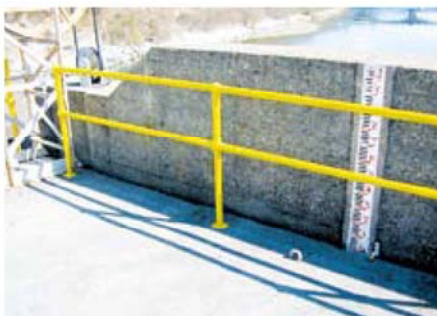
Contrappeso dotato di asta graduata utile alla regolazione dell'apertura della paratoia
