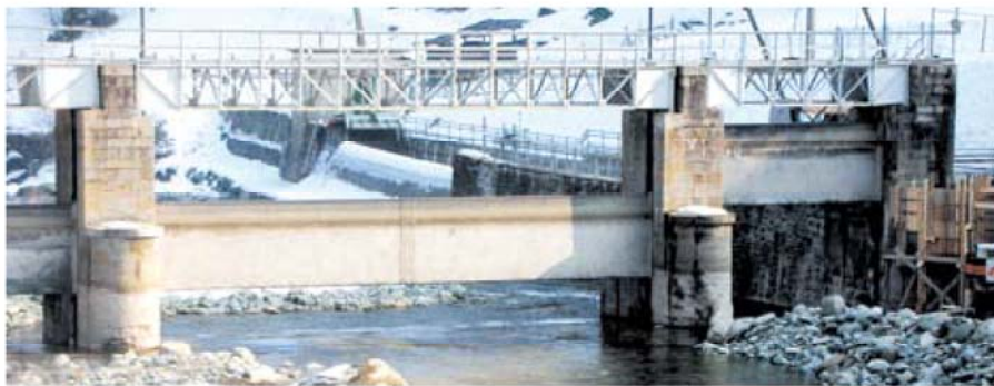
Paratoie piane in posizione aperta viste da monte
