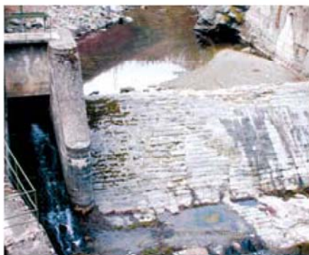
Esempio di traversa fissa
