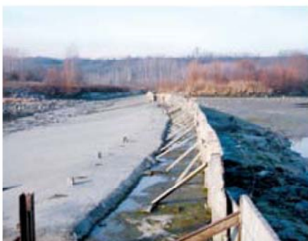
Traversa fissa con rialzo in legno
