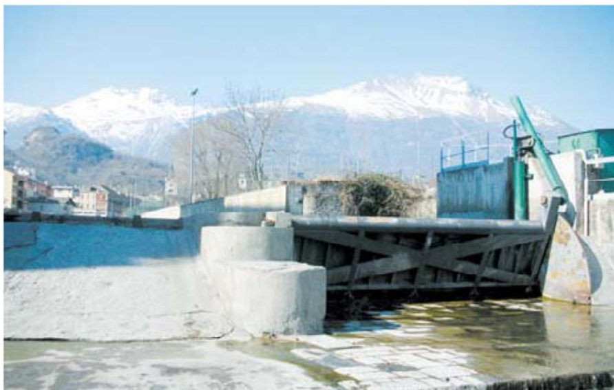
Traversa mobile, in parte costituita da soglia fissa in calcestruzzo
