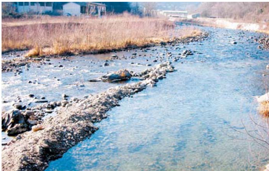
Sbarramento precario costituito da semplice accumulo di ciottoli d'alveo
