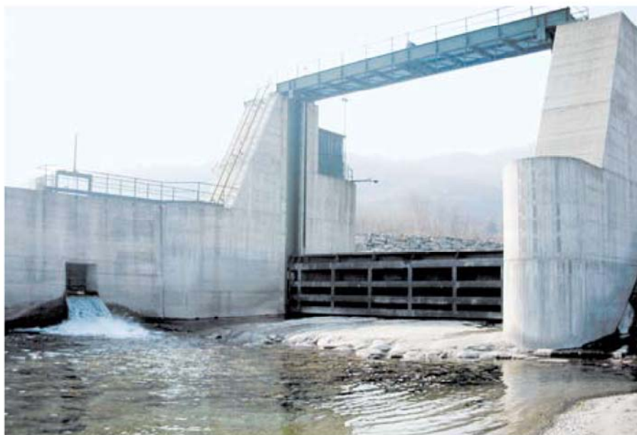
Scarico del canale sghiaiatore a valle di una traversa mobile
