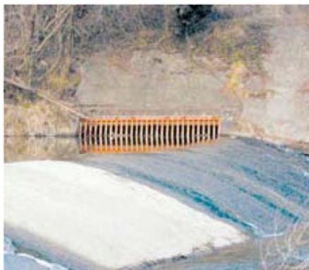
Derivazione irrigua con traversa di tipo fisso
