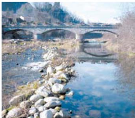
Derivazione irrigua con sbarramento precario
