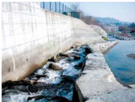
Rampa in pietrame vista da monte
