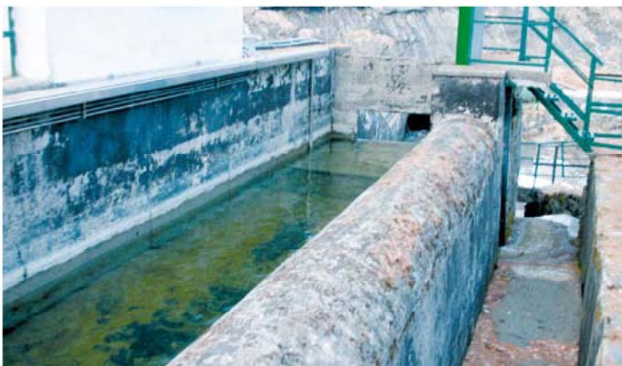
Canale dissabbiatore con canale di spurgo parallelo
