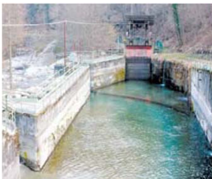
Canale sghiaiatore dotato di doppio scarico di fondo
