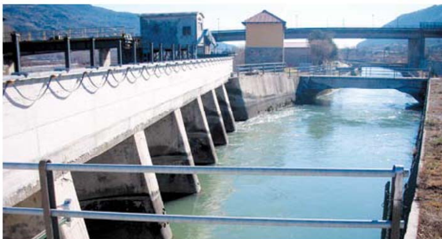
Canale derivatore a valle di una bocca di presa multipla
