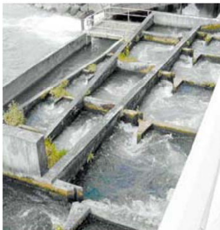
Passaggio a fenditure verticali
