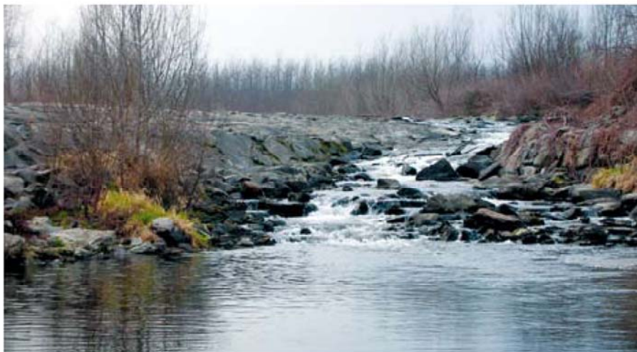
Rampa in pietrame
