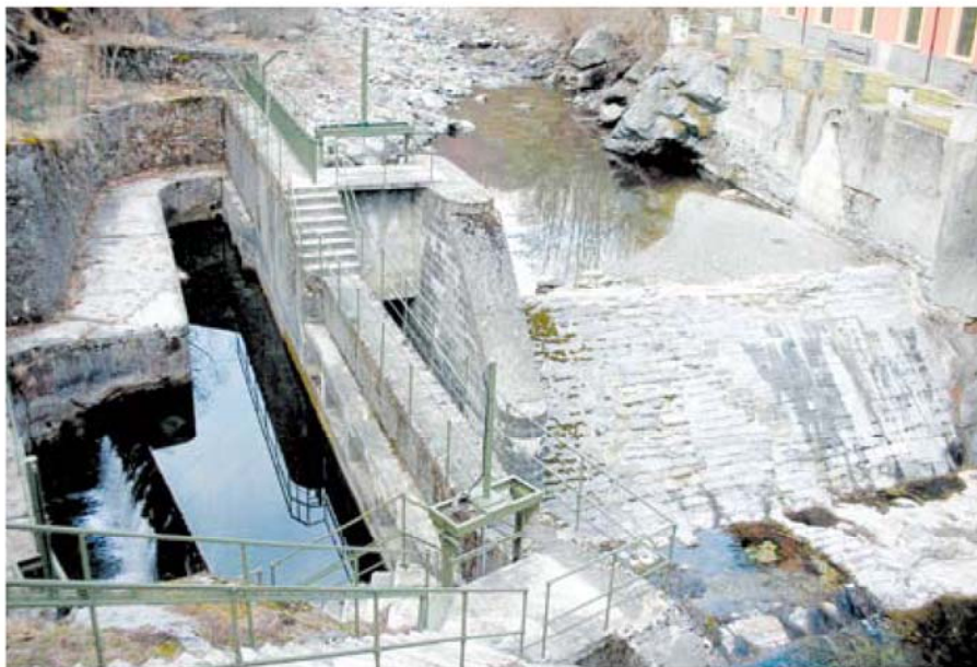
Opera di presa con in evidenza il canale dissabbiatore
