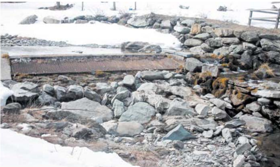
Traversa a trappola vista da valle
