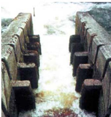
Passaggio tecnico a rallentamento
