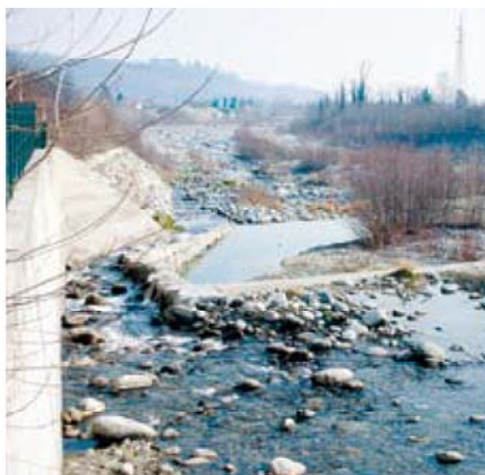
Rilascio in corrispondenza dell'opera di sbarramento: setto ribassato direttamente connesso a scala di risalita per ittiofauna
