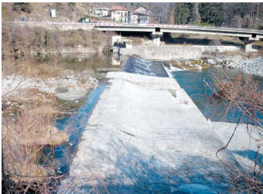
Traversa fissa in muratura
