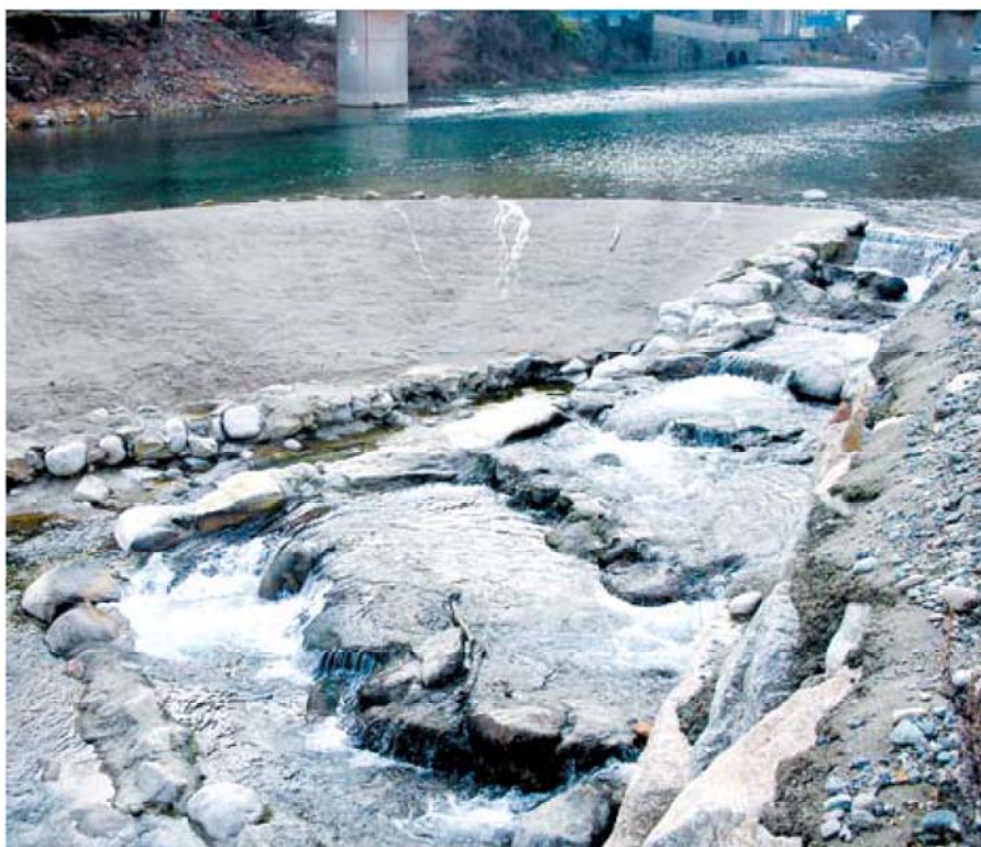
Rampa in pietrame
