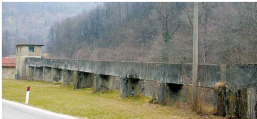
Esempio di ponte-canale
