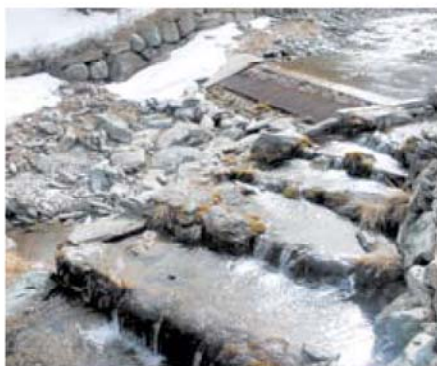
Rampa in pietrame a lato di una traversa a trappola
