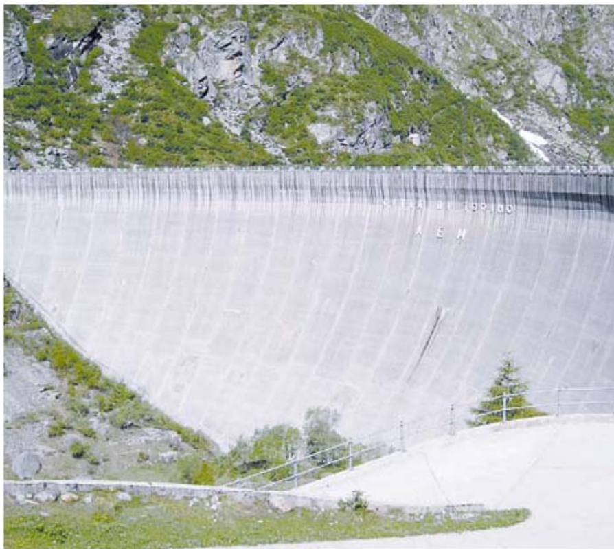
Vista da valle dello sbarramento della diga di Pian Telesio – Locana
