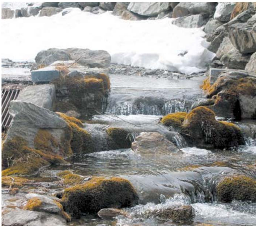
Rilascio da stramazzo direttamente connesso a rampa di risalita in pietraie
