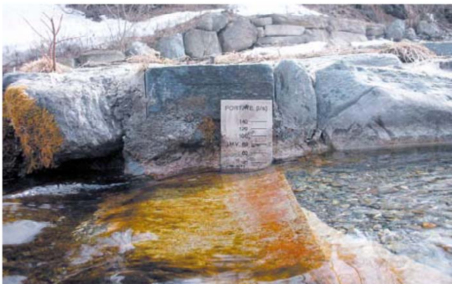
Sezione di rilascio a stramazzo con in evidenza l'asta graduata di controllo
