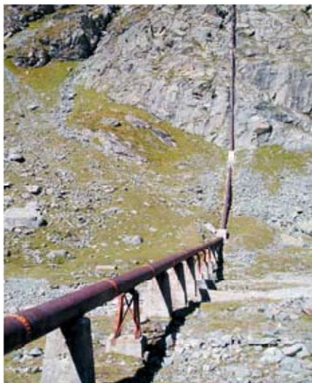
Esempio di condotta forzata
