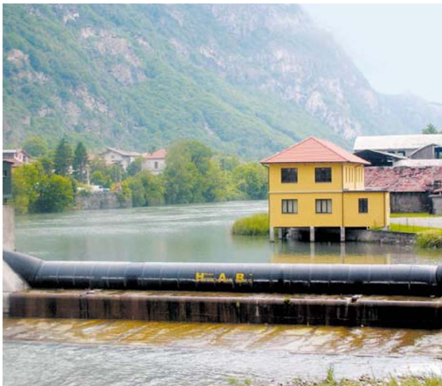
Opera di sbarramento caratterizzata da particolare traversa a gommone
