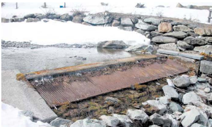
Traversa a trappola con griglia a piano alveo
