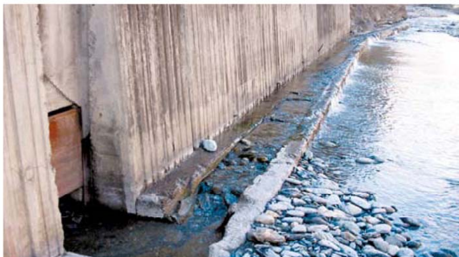
Canalizzazione in muratura dell'opera di derivazione con bocca di presa dotata di paratoia metallica
