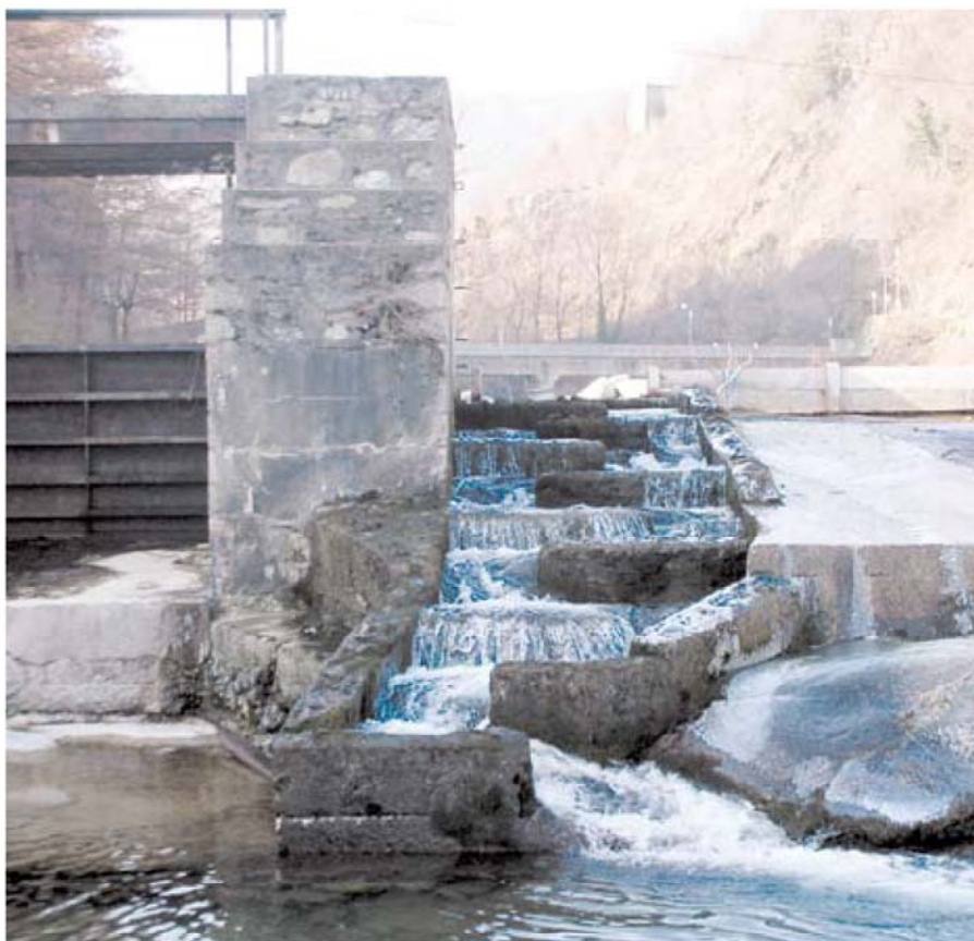
Passaggio a bacini successivi visto da valle
