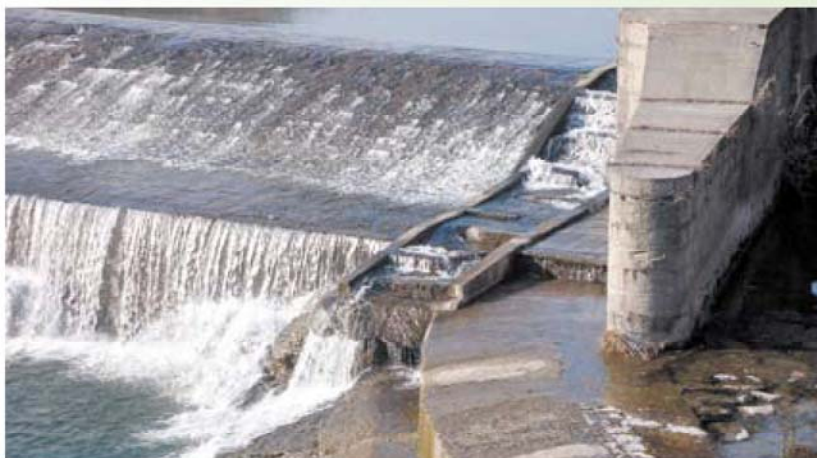
Passaggio a bacini successivi scalzato ed in parte asportato nella porzione terminale
