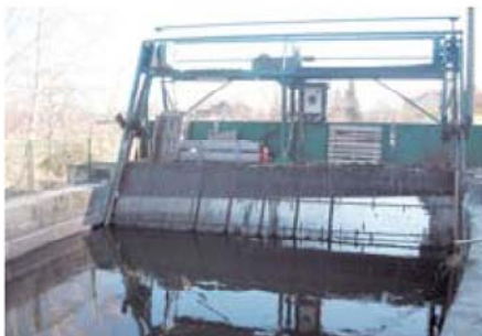
Canale derivatore con griglia e apposito sgrigliatore
