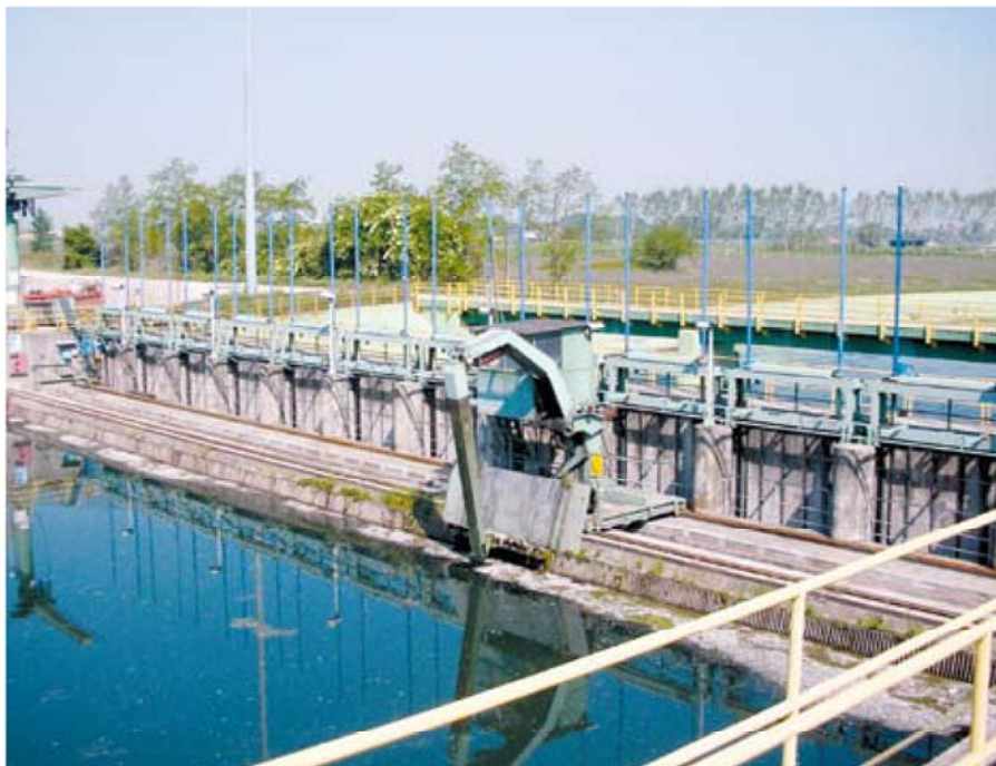
Bocca di presa multipla con griglia e sgrigliatore automatico su carrello mobile
