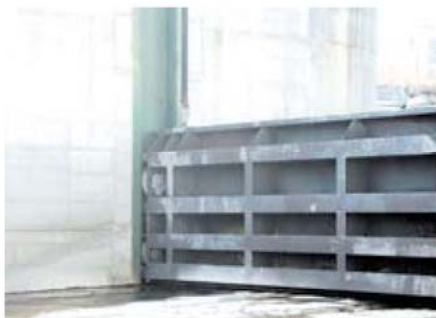
Particolare di paratoia piana vista da valle
