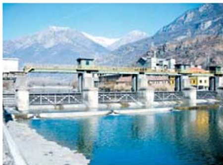
Traversa mobile con paratoie piane
