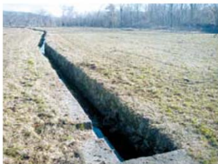
Canale derivatore irriguo rivestito in muratura e massi
