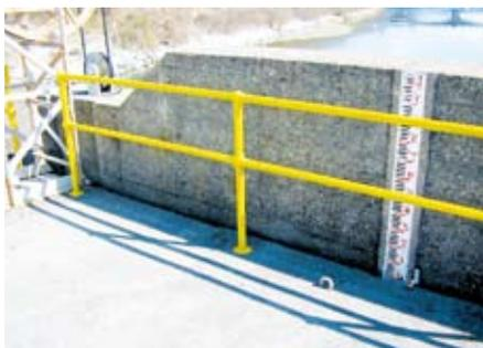
Contrappeso dotato di asta graduata utile alla regolazione dell'apertura della paratoia
