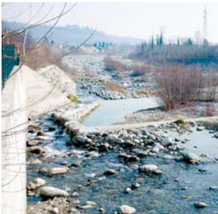
Rilascio in corrispondenza dell'opera di sbarramento: sotto ribassato direttamente connesso a scala di risalita per ittiofauna
