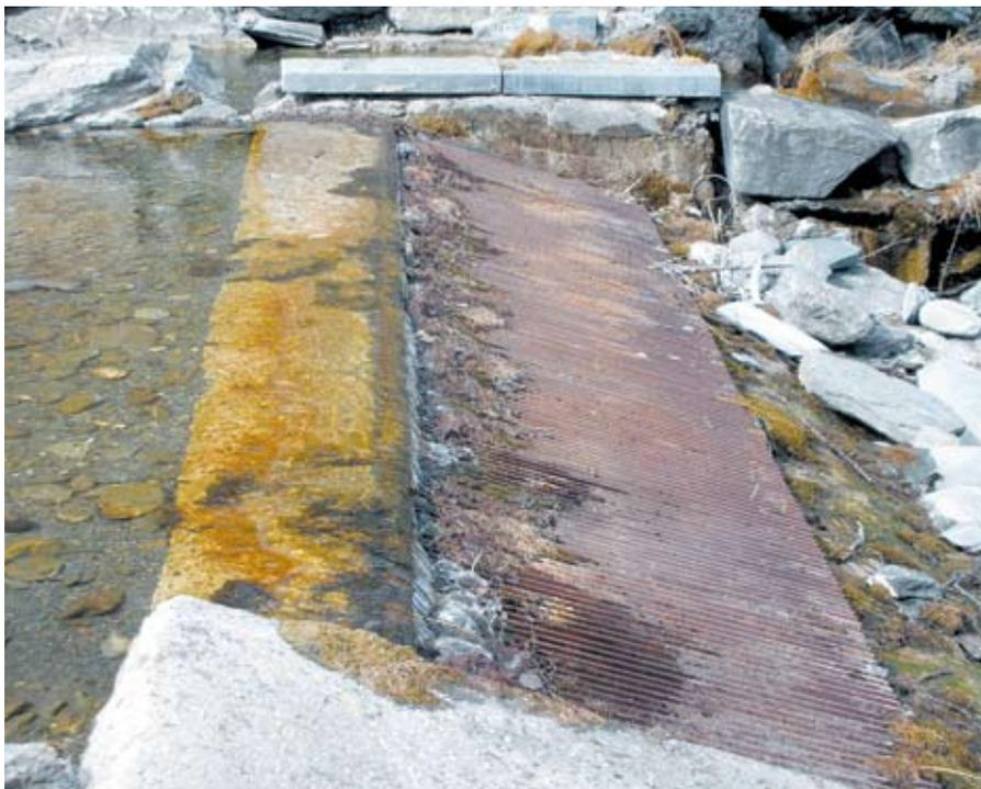
Traversa a trappola con griglia di presa a piano alveo
