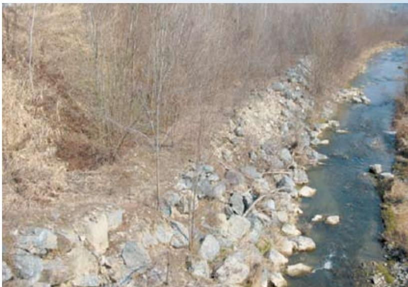
Argine rivestito con paramento in massi d'alveo eroso, da ripristinare con adeguata manutenzione
