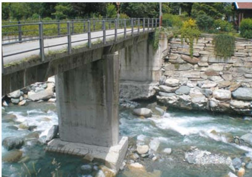
Erosione sotto le fondazioni della spalla sinistra
