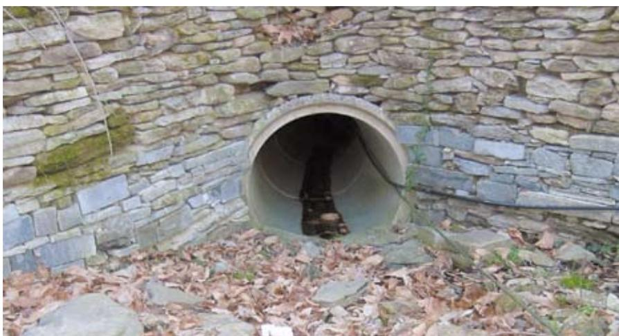
Canalizzazione a sezione chiusa realizzata con tubazione
