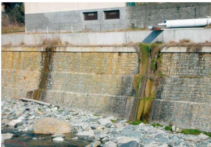
In primo piano manufatto di scarico di acque reflue e in secondo piano traccia di immissione di acque meteoriche
