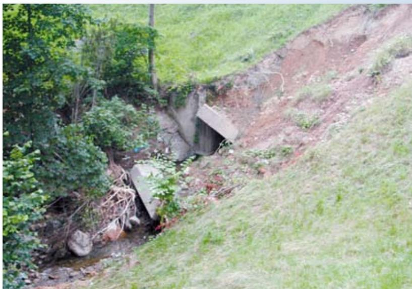
Sbocco di un attraversamento in dissesto strutturale
