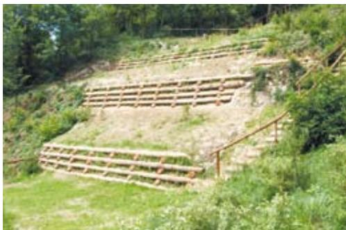
Palificata a doppia parete con funzione di riprofilatura e ricarica del versante
