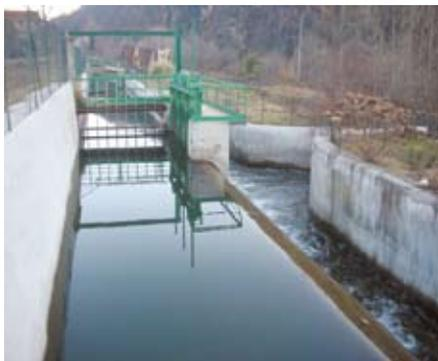
Rilascio da sfioratore di regolazione delle portate massime derivate posto lungo il sistema di canalizzazione dell'opera di presa
