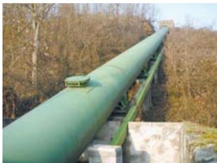
Condotta di derivazione in pressione a servizio di una stazione di pompaggio
