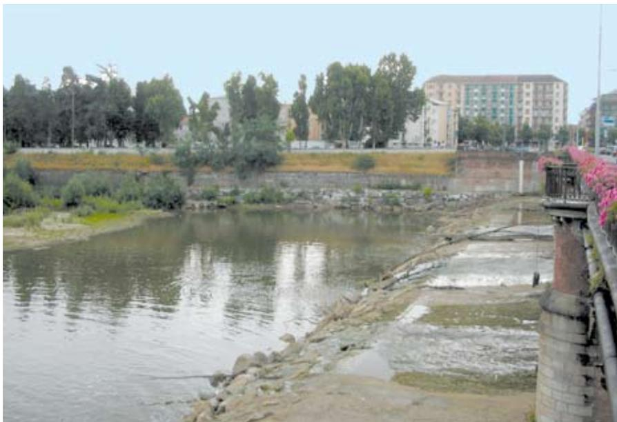
Soglia a valle di un ponte per impedire l'erosione delle pile
