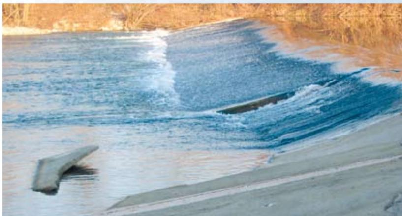
Traversa in dissesto per erosione del rivestimento esterno
