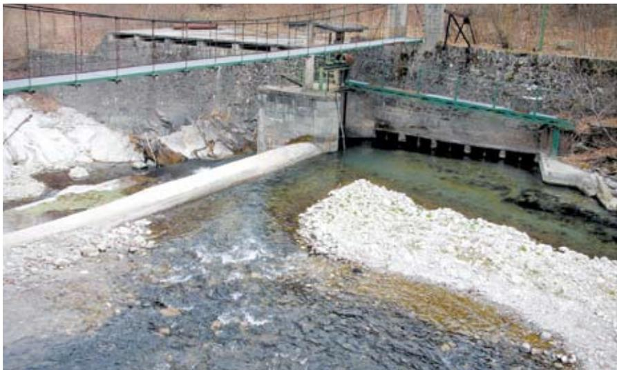
Traversa fissa con paratoia sghiaiatrice e bocca di presa multipla: si noti l'accumulo di detriti a monte dell'opera di sbarramento
