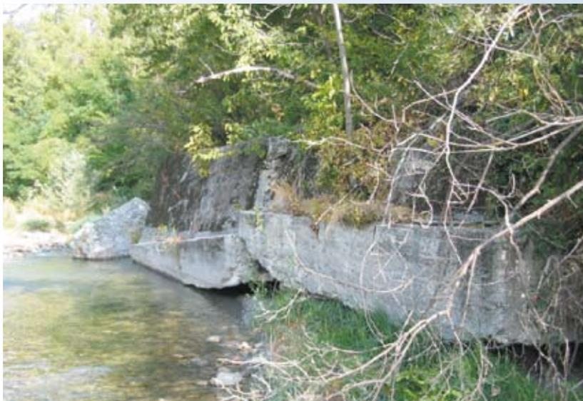
Muro in dissesto strutturale per erosione, quindi inefficiente
