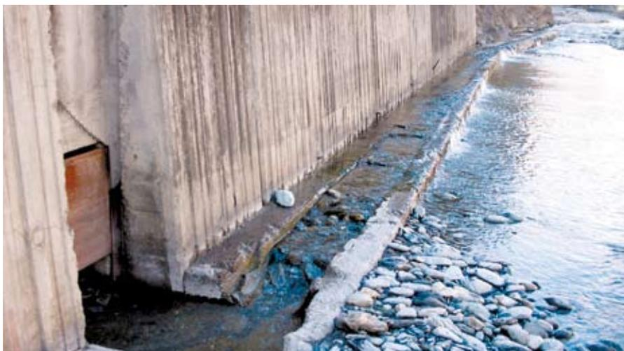
Canalizzazione in muratura dell'opera di derivazione con bocca di presa dotata di paratoia metallica
