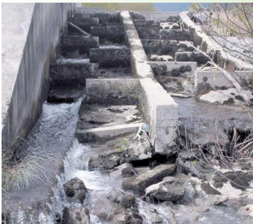
Passaggio a bacini successivi costituito da doppia rampa in parte asciutta e con marcati segni di dissesto strutturale
