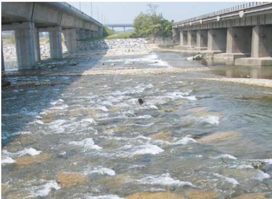
Canalizzazione solo fondo alveo tra due ponti, per evitare fenomeni erosivi e per facilitare il transito del materiale solido trasportato dall'acqua
