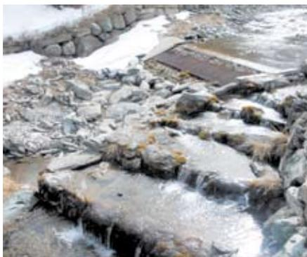
Rampa in pietrame a lato di una traversa a trappola
