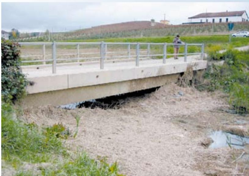
Ponte completamente interrato che necessita di svuotamento
