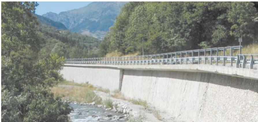
Difesa spondale realizzata con muro in cemento armato rivestito, con scogliera a protezione delle fondazioni
