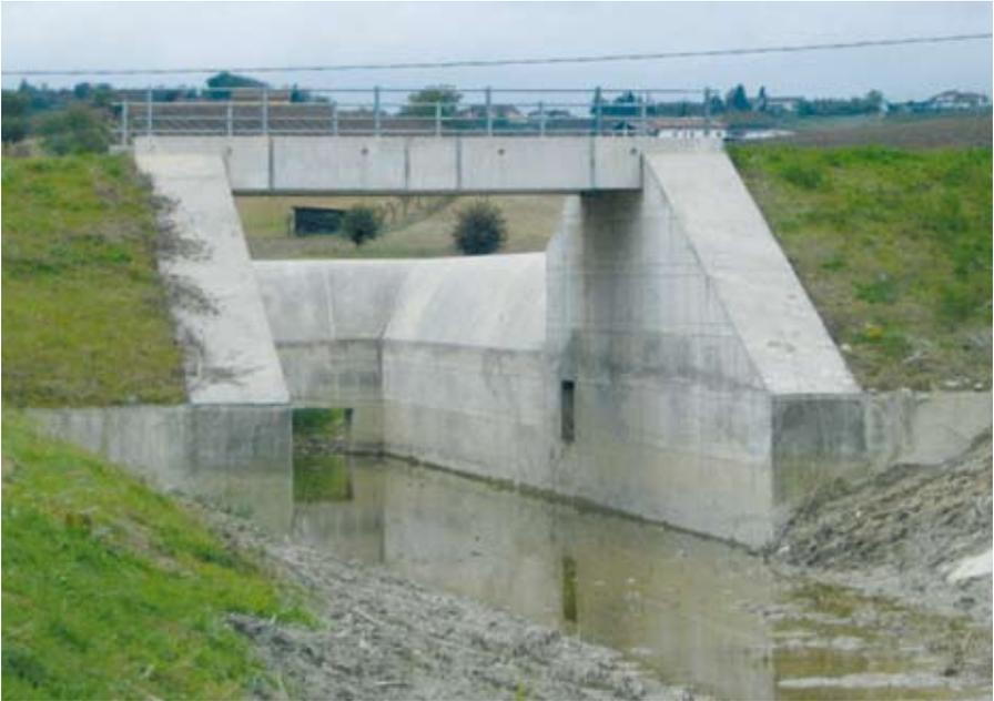
Manufatto di scarico di una vasca di laminazione con luce di fondo a battente
