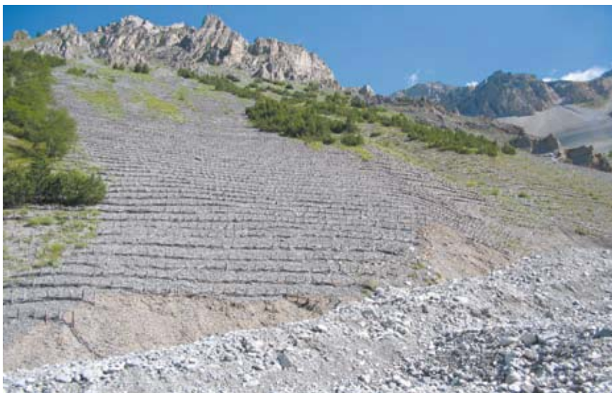
Tentativo di rimboscimento con uso di tecniche di ingegneria naturalistica
