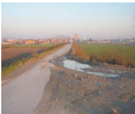
Argine di contenimento dei livelli di piena in pianura
