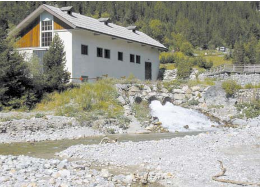
Restituzione a valle di una centrale idroelettrica
