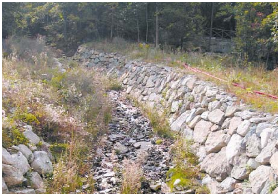
Difese spondali lungo un piccolo corso d'acqua
