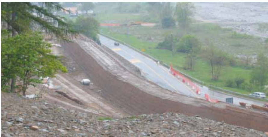
Sistemazione di versante soggetto a crolli con vallo paramassi in terra rinforzata
