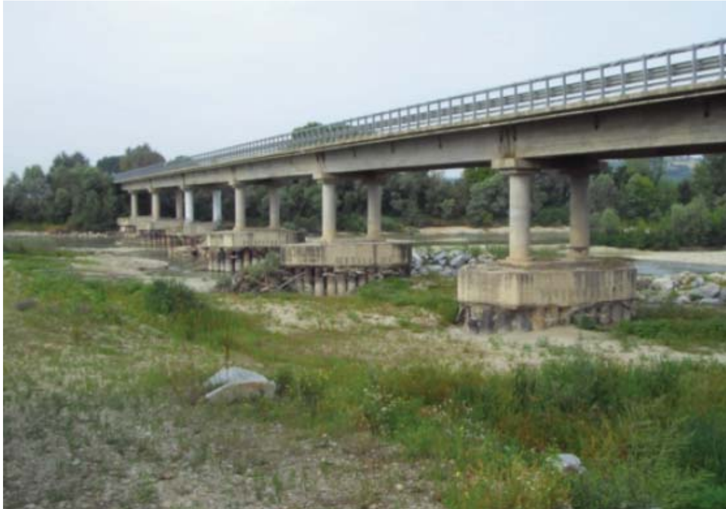
Piloni in erosione e ponti problematici
