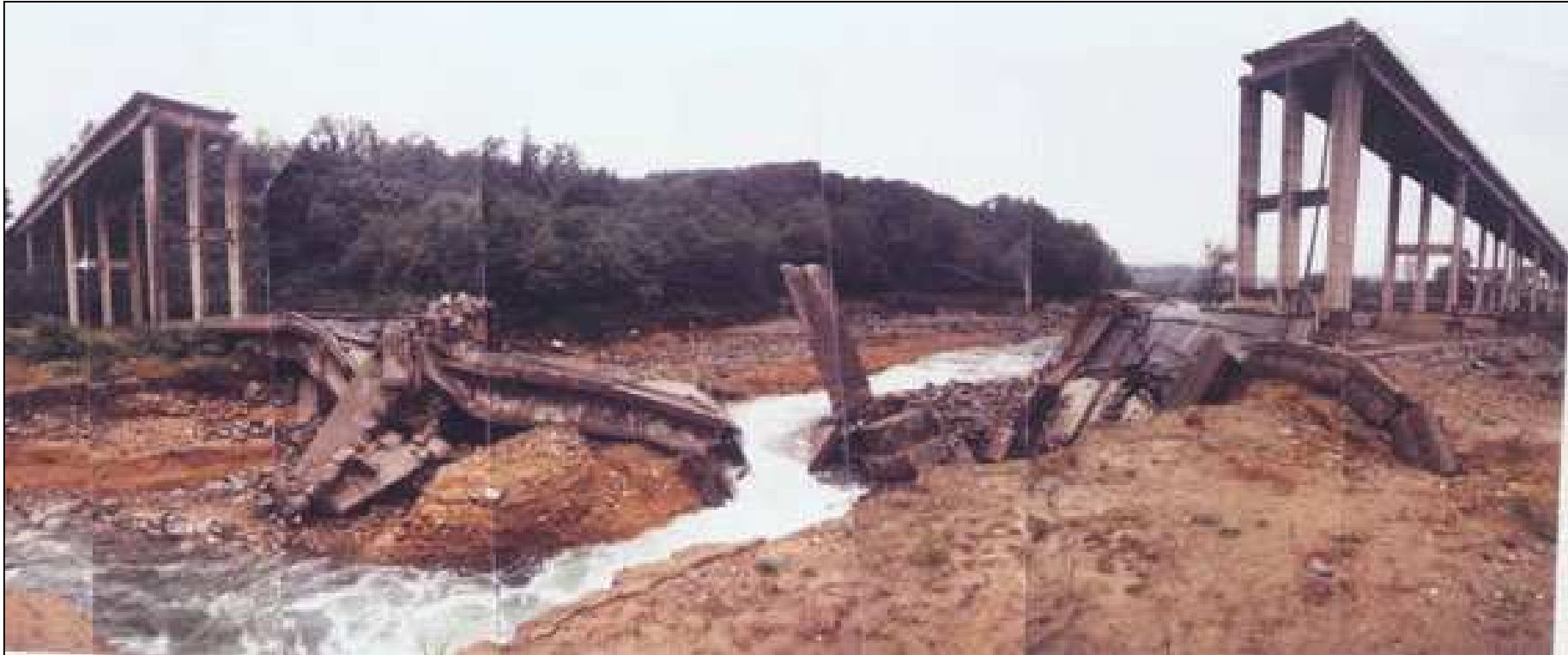
TORRENTE CERVO – alluvione settembre 1993, crollo del viadotto a Biella per erosione di fondo e scalzamento delle pile (Fonte: Ing. Geol. C. Silvestro – Regione Piemonte)
