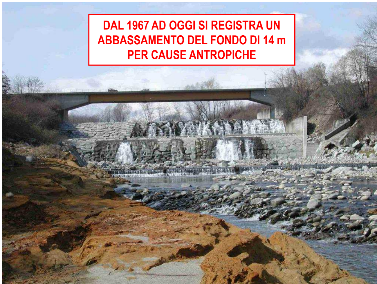
TORRENTE CERVO – opere di consolidamento del ponte ex SP Vigliano e Candelo (Fonte: Ing. Geol. C.Silvestro – Regione Piemonte)
