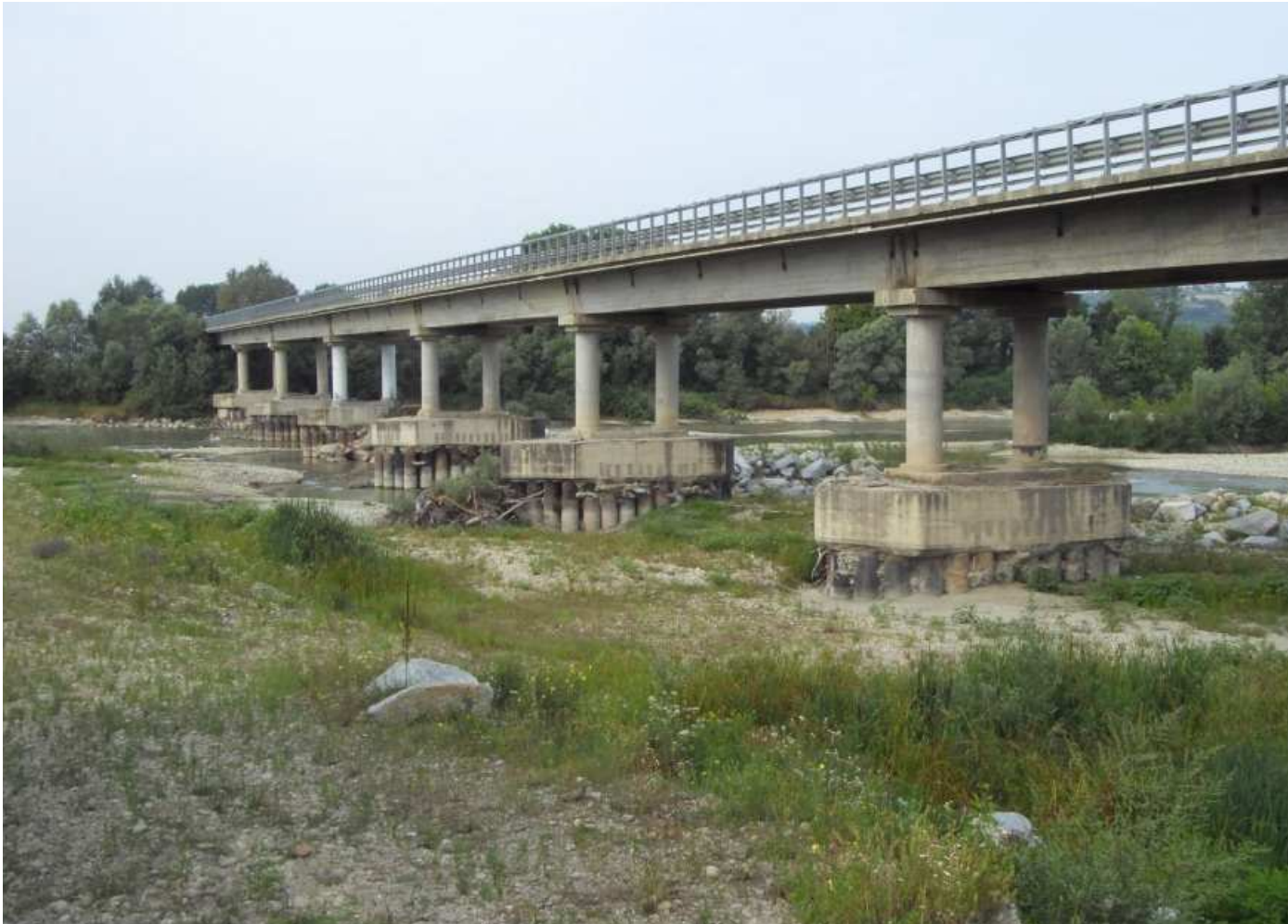
Ponte sul FIUME TANARO nel Comune di Govone (Fonte: Ing. Geol. C.Silvestro – Regione Piemonte)
