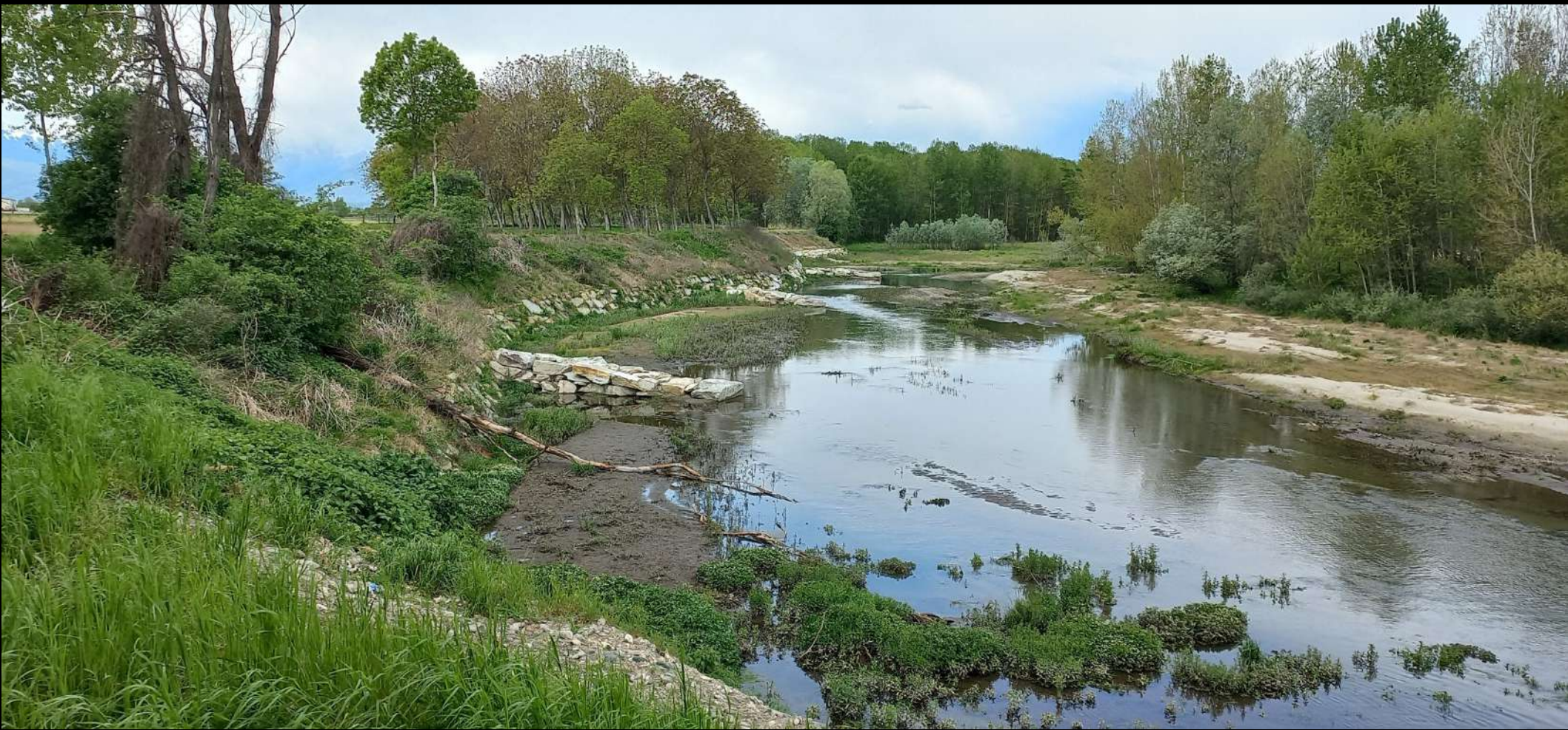
Vista verso monte della sponda destra con le nuove opere in loc. Ruata.
