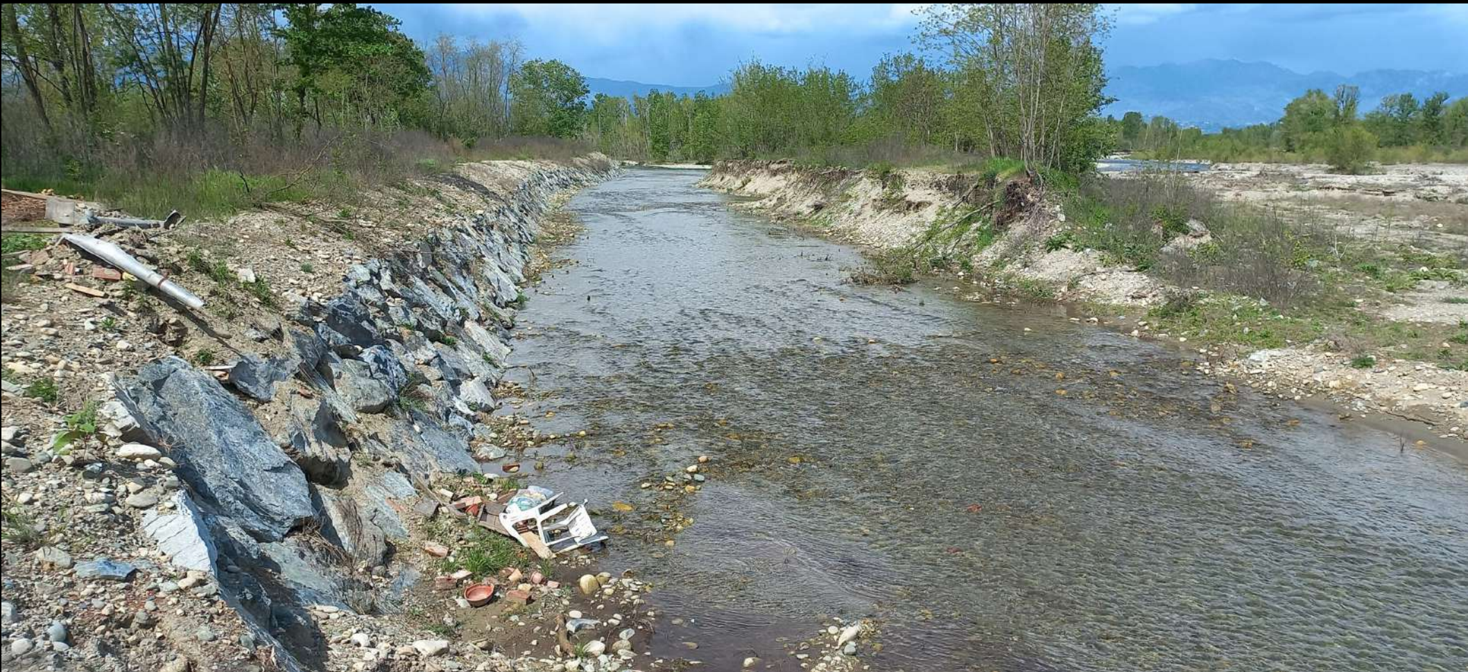
Vista da valle verso monte del nuovo canale aperto sulla sponda destra del Pellice alla confluenza
