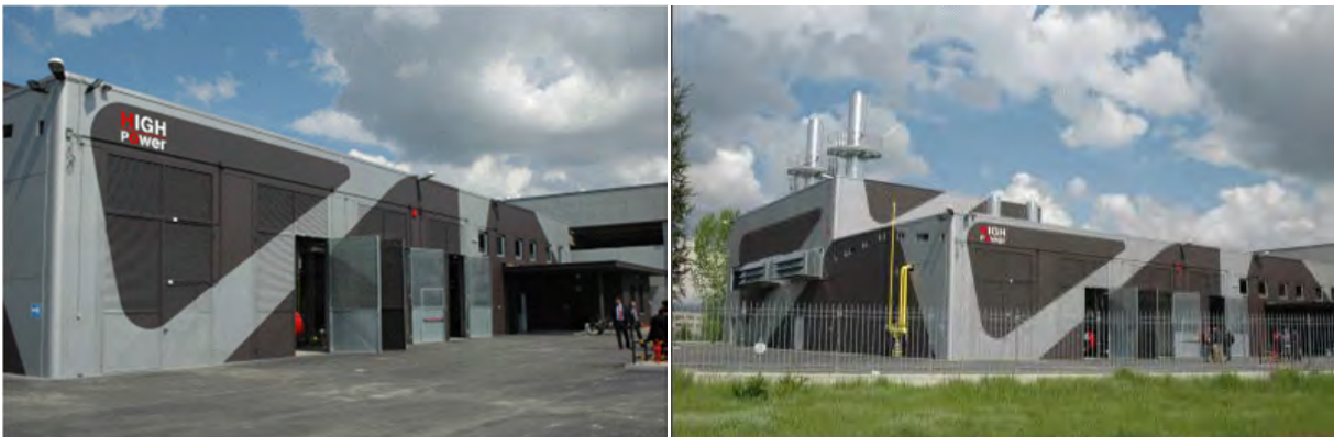
Figura 60 - La centrale cogenerativa nell'area industriale di Fontaneto (Chieri)
