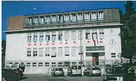
TINTEGGIATURA INFERRIATE ESTERNE CON SMALTO EPOSSIDICO SU COLORITURA ESISTENTE A DUE RIPRESE - COLORE N. 95 SECONDO PIANO COLORE DELL'ENTE.
