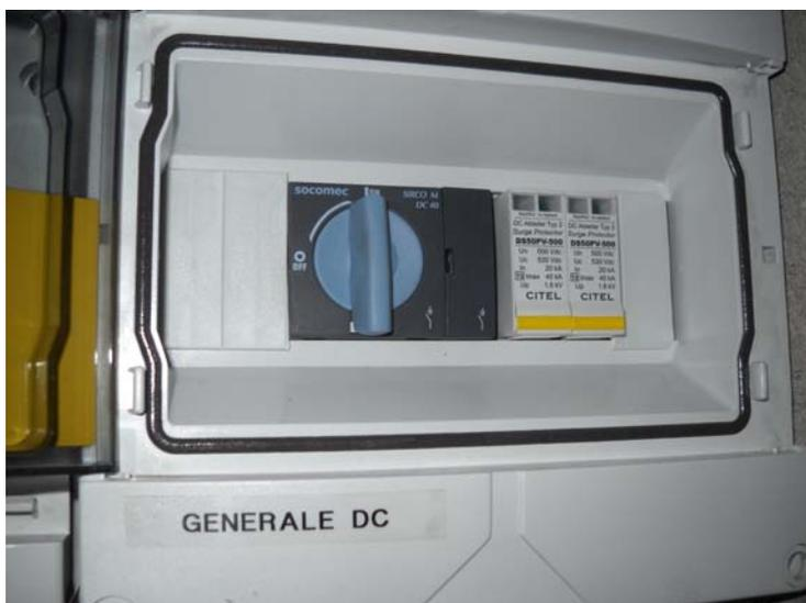
Figura 16 – Quadro sul lato DC con interruttore di manovra (blu) e scaricatori di sovratensione (bianco/gialli)
