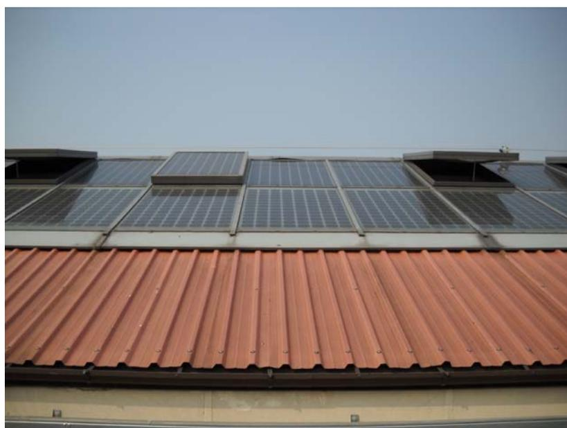
Figura 22 – Il tetto in lamiera grecata con il lucernario fotovoltaico del Politecnico di Torino
