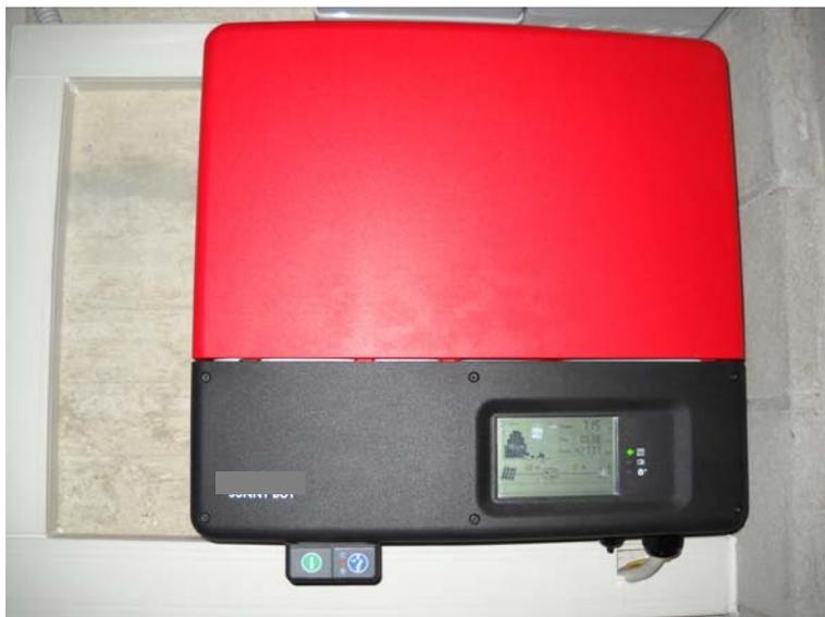
Figura 18 – L’inverter senza trasformatore da 3000 W
