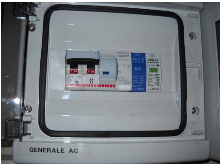
Figura 17 – Quadro sul lato AC con interruttore magneto-termico-differenziale (bianco/nero/rosso) e scaricatori di sovratensione (bianco/blu)
