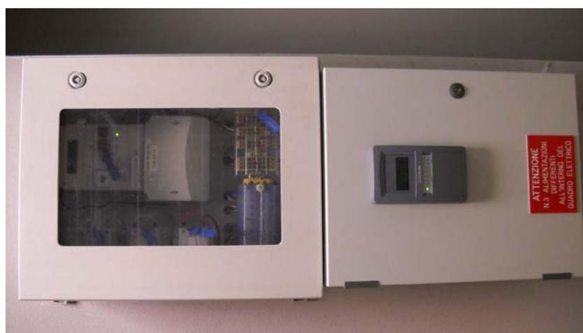
Figura 26 – Vista del contatore dell'energia prodotta (sx) e della protezione di interfaccia con la rete (dx)
