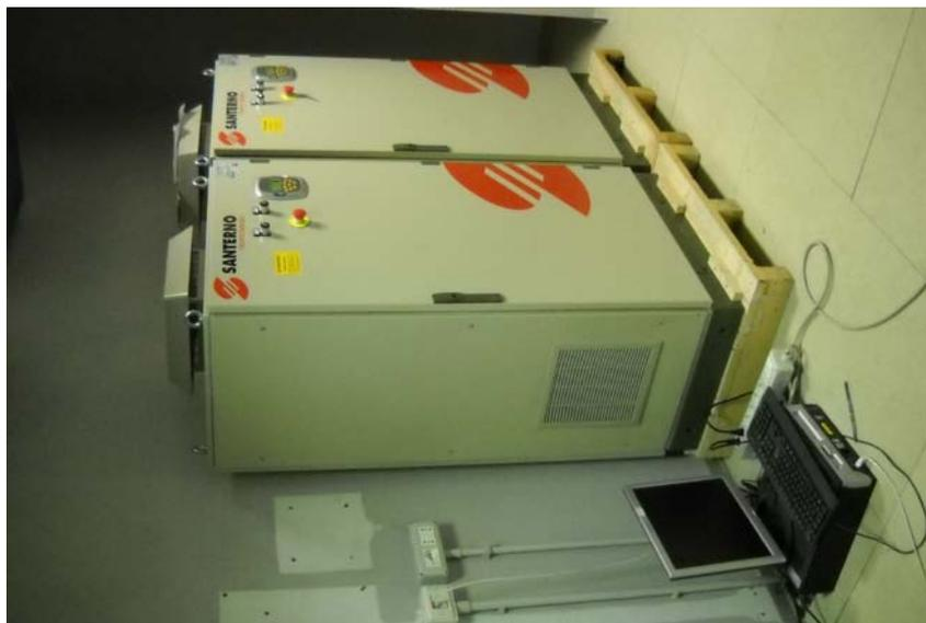
Figura 25 – La disposizione dei 2 inverter nel vano tecnico con il PC per il monitoraggio
