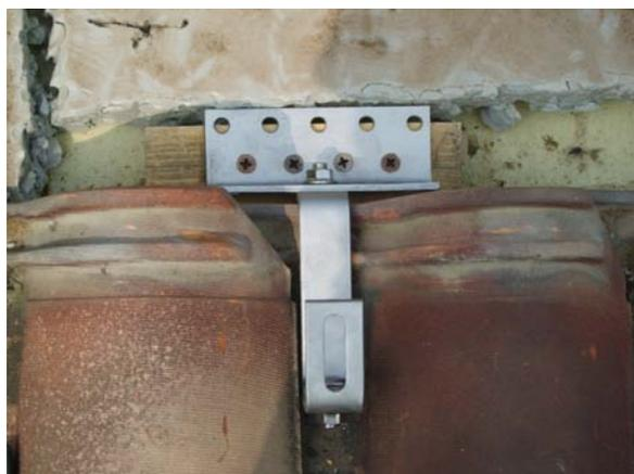
Figura 11 – Particolare di una staffa di ancoraggio ai listelli del tetto (vista frontale a sx e vista dall'alto a dx)
