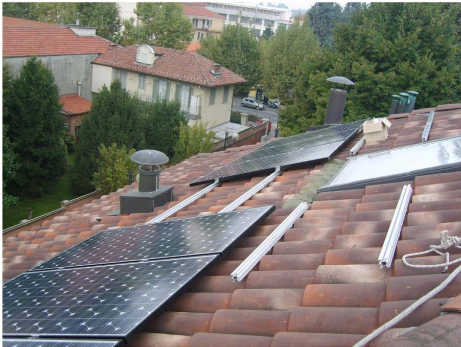
Figura 13 – Vista dei binari della struttura di fissaggio con alcuni dei moduli fotovoltaici
