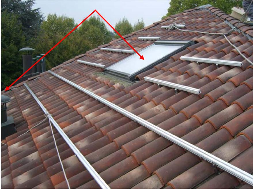
Figura 12 – Vista dei binari della struttura di fissaggio dei moduli fotovoltaici
