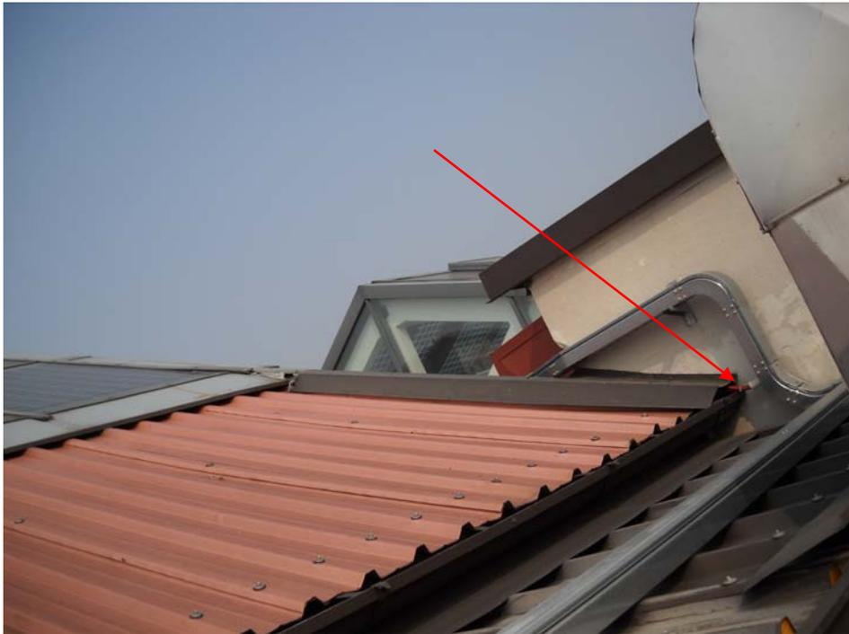
Figura 23 – Particolare del passaggio dei cavi nella canalina metallica per il lucernario fotovoltaico
