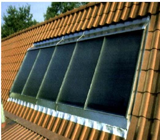
La progettazione integrata della copertura e dell'impianto garantisce una migliore realizzazione dell'opera. Infatti la fase di installazione sarà effettuata in fase di realizzazione della copertura, riducendo il lavoro necessario alla posa dell'impianto e garantendo un'ottima integrazione dello stesso all'interno della copertura.
