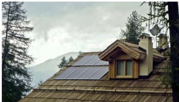
La totale integrazione permette di ridurre al minimo l'impatto visivo. Si riporta inoltre un particolare in cui è possibile notare il punto di raccordo del collettore con il circuito del fluido termovettore.
