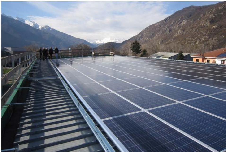
Figura 19 – I moduli FV dopo la posa sul tetto della palestra (per gentile concessione del Comune di Condove)
