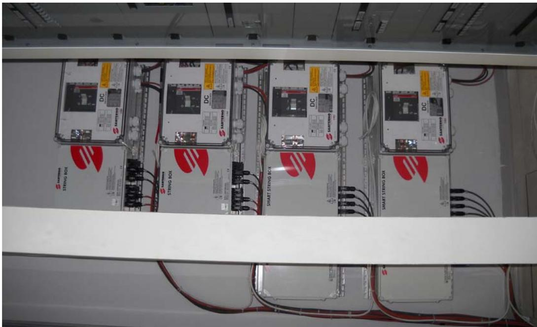
Figura 24 – I quadri di parallelo stringhe nel vano tecnico che ospita gli inverter
