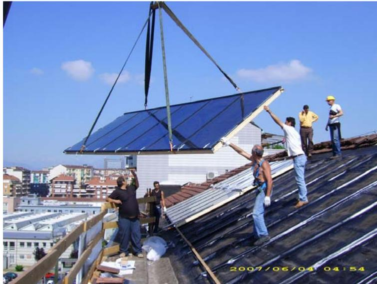
La circolazione del fluido termovettore avviene secondo i principi del Low-flow (15 l/mq h), il circolatore solare è alimentato direttamente da un impianto fotovoltaico dedicato; è presente un sistema di monitoraggio delle prestazioni; i dati istantanei di funzionamento sono visualizzati agli abitanti del collegio tramite un display posto all'ingresso.
