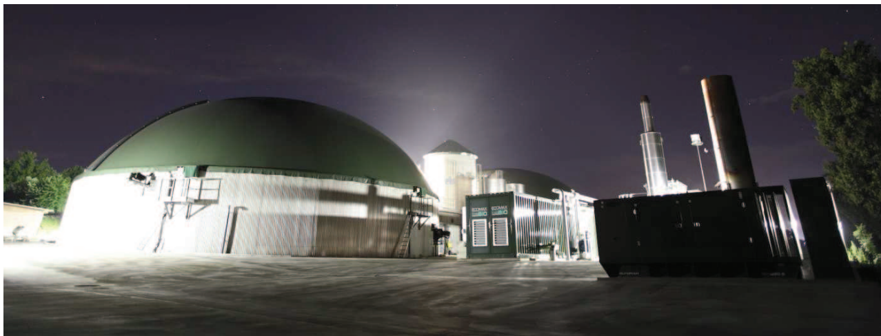
Impianto biogas dell'azienda agricola "La Bellotta" di Venaria
