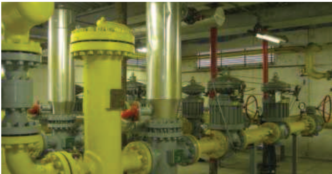
Impianto di distribuzione del gas naturale in provincia di Torino
