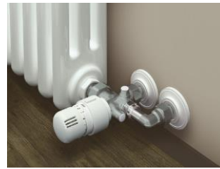
Valvola termostatica per distribuzione monotubo, con sensore a dilatazione di liquido.
