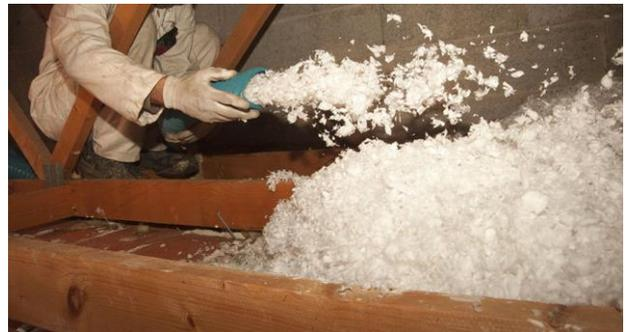
Isolamento termico sottotetto tramite insufflaggio
