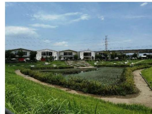
Bacino di ritenzione e infiltrazione, con sistema di fitodepurazione. Tokyo. Foto: E. Gottero
