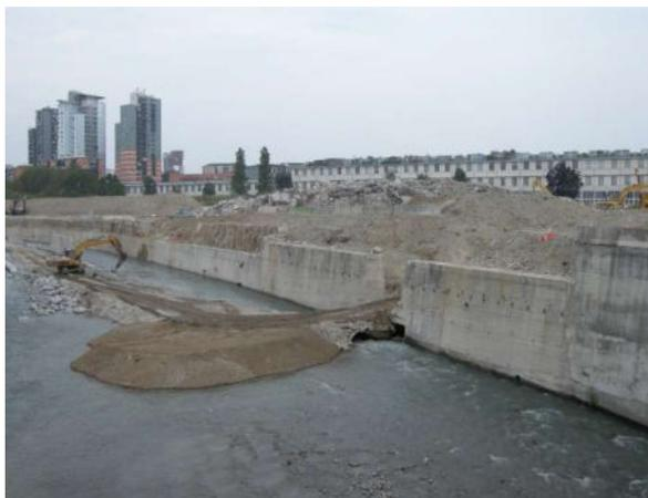
Demolizione della soletta del tunnel sul fiume Dora. Torino. Foto: C. Cassatella
