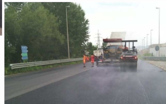
Stesa della miscela bituminosa gap-graded (Via Brescia – Tratto sperimentale 2)
