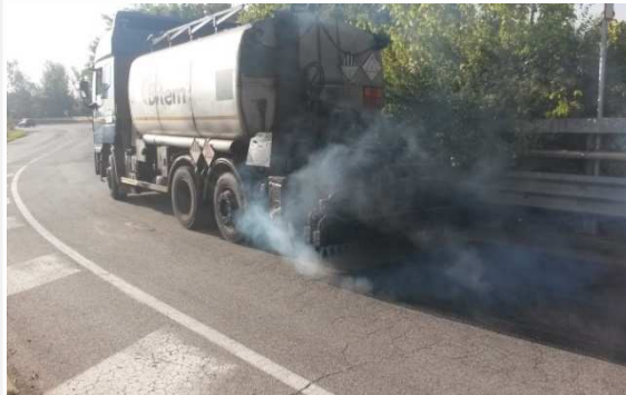
Stesa del SAMI in asphalt rubber (via Brescia – Tratto sperimentale 1)
