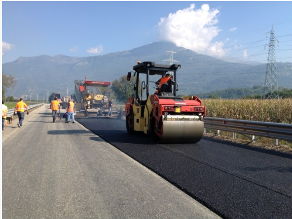
Stesa della miscela gap-graded sulla SP 503 (Baio Dora)
