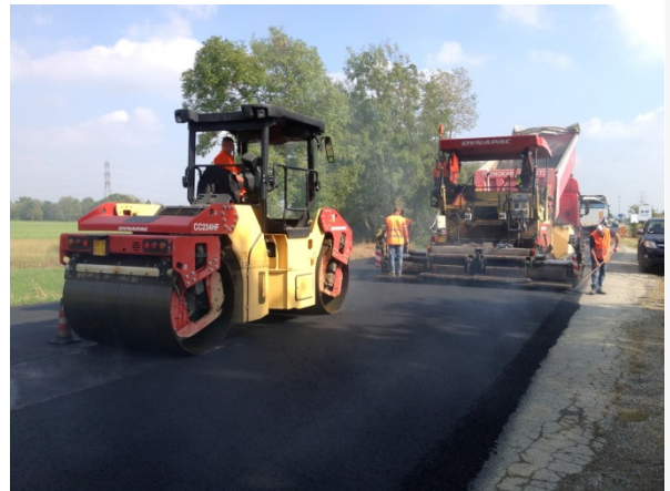
Stesa della miscela dense-graded sulla SP 53 (Caluso)
