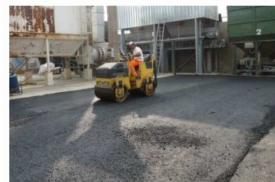
Stesa e compattazione delle miscele
