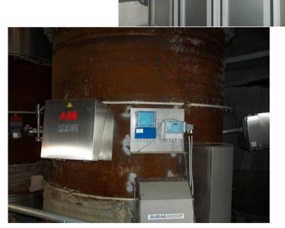
E' previsto il controllo in continuo, con prelievi periodici, di diossine e furani, che accumulati in fiale - verranno inviati a laboratori specializzati per le analisi.
