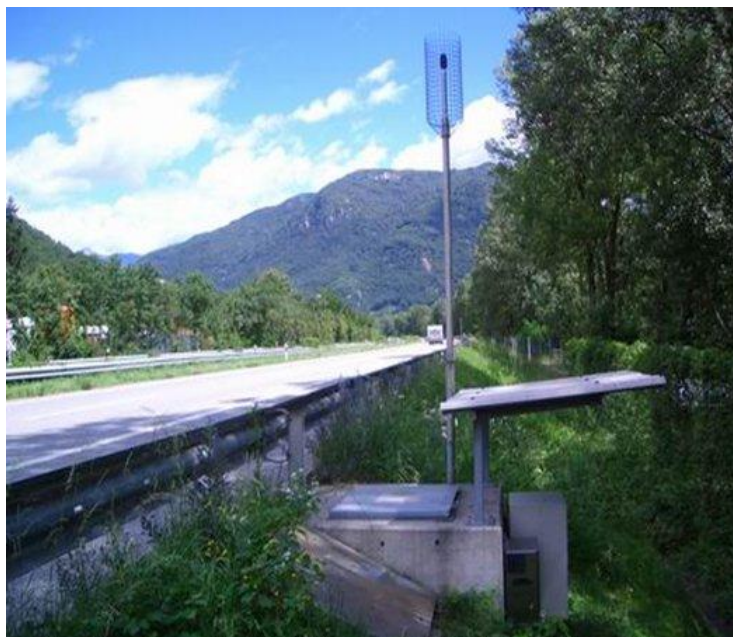
Figura 52: Sito di misura di Camignolo.
