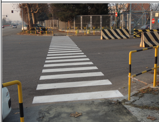
Figura 5. Lungo Stura Lazio 51 - tolto la barriera architettonica (marciapiede abbassato) e rinnovato attraversamento pedoni
