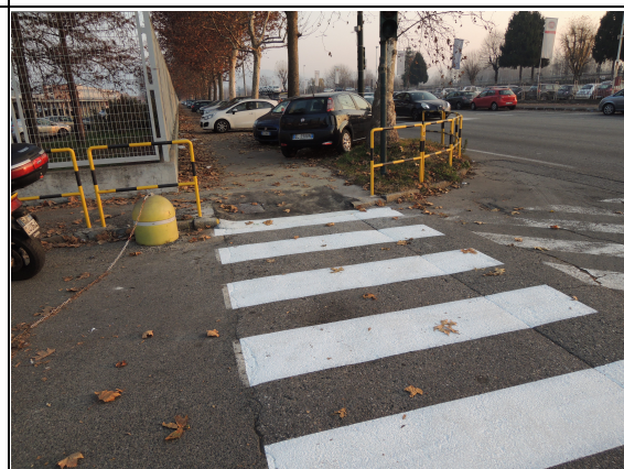
Figura 8. Lungo Stura Lazio 15/19 abbassata la barriera architettonica
