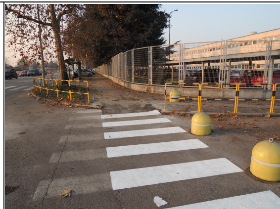
Figura 6. Lungo Stura Lazio 49 abbassata la barriera architettonica
