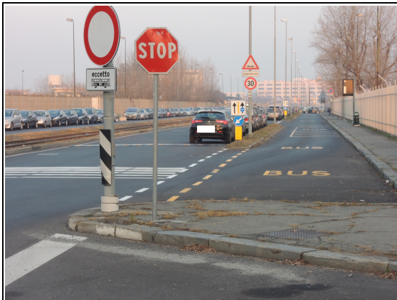
Figura 4. Strada Cascinette riasfaltata e migliorata fermata autobus GTT
