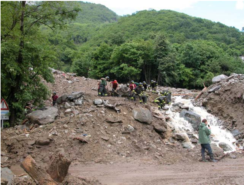
Foto 2.25 e 2.26 - Comune di Villar Pellice. Vista verso monte del debris flow che ha interessato la frazione di Garin. Lo spessore del materiale detritico accumulato è stimabile in diversi metri, come si può vedere rispetto alla strada. La sezione dell'attraversamento sulla SP 161 (vista da valle ) è visibilmente scarsa.
