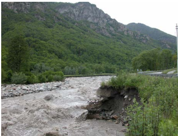
Foto 2.5 e 2.6 - Erosione spondale in sx orografica del T. Chisone tra Perosa Argentina e Roure. Le immagini riportano due punti in cui il T. Chisone si avvicina pericolosamente alla sede stradale della SS 23.
