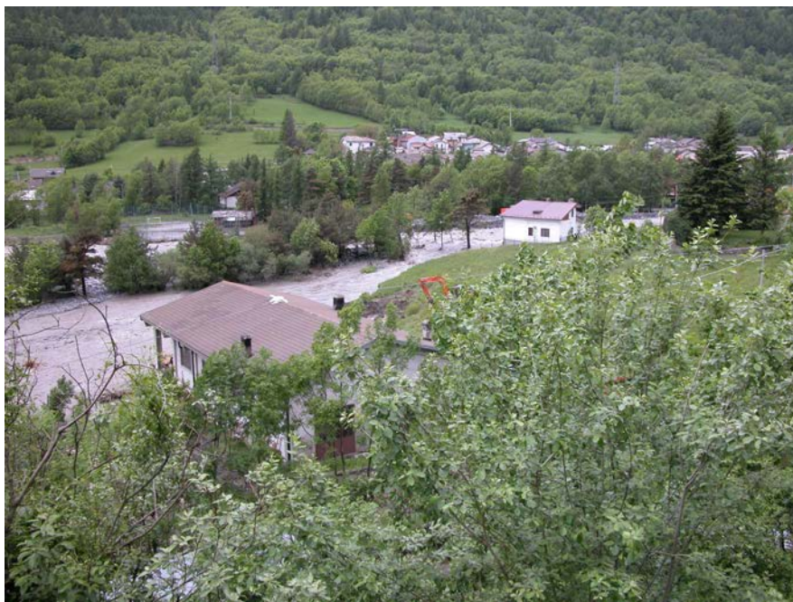
Foto 2.9 - Il Chisone ha esondato in destra orografica in località Depot, Comune di Fenestrelle. Alcuni ponti sono sottodimensionati rispetto alle portate di piena, gli attraversamenti delle strade a volte sono sottodimensionati o sono stati intasati.
