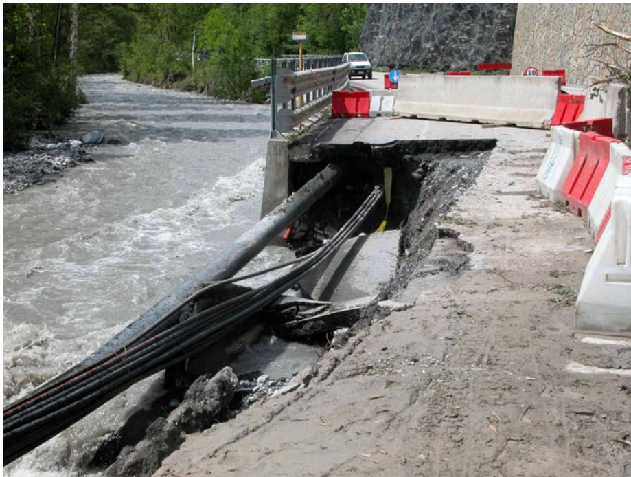
Foto 2.31 – Erosione di sponda lungo la S.S. 24 a Bardonecchia rimasta interrotta a causa della concomitante colata di materiale detritico sulla strada .
