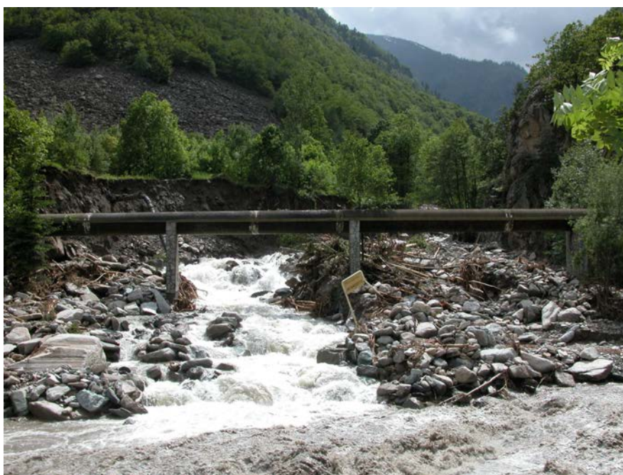
Foto 2.10 - Comune di Roreto Chisone: accentuata erosione sulla sponda destra idrografica del Rio Borsetto alla confluenza col Torrente Chisone.
