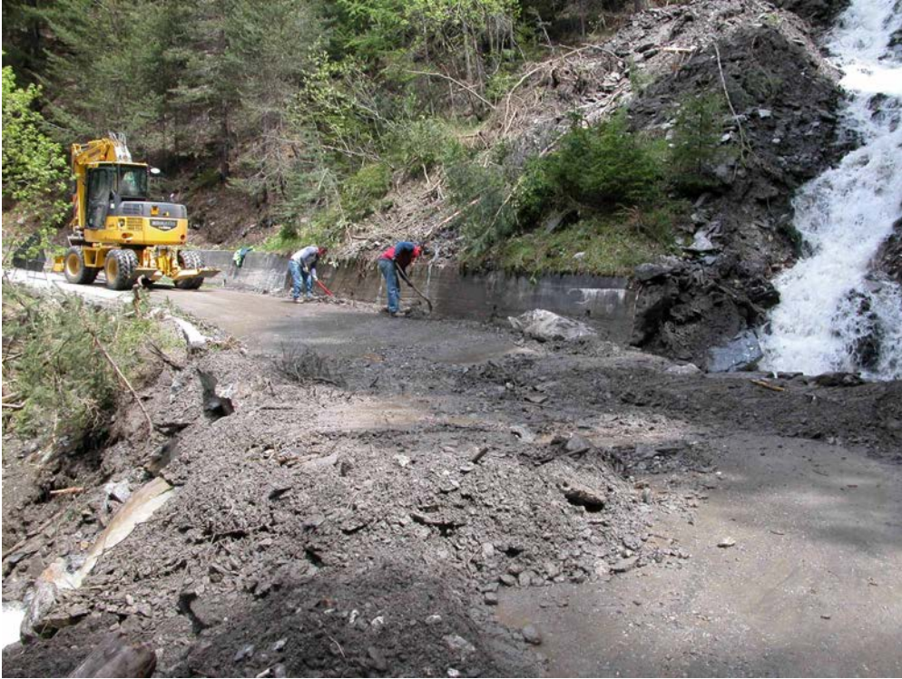
Foto 2.30 – Colata e consistente afflusso di acqua sulla S.P.235 per Rochemolles .
