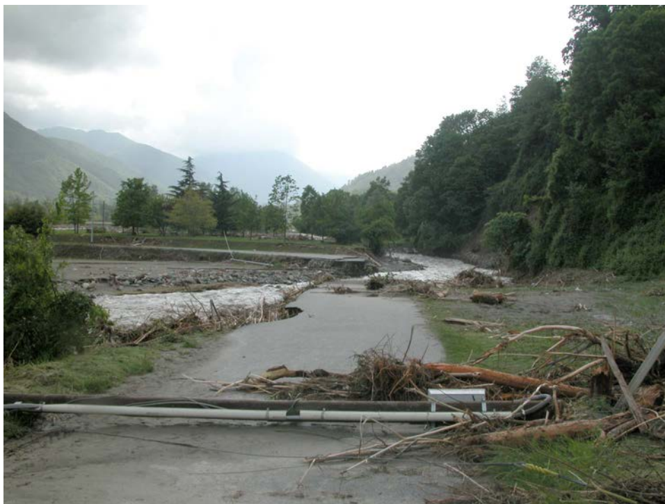
Foto 2.17 - Comune di Torre Pellice. Vista verso monte dalla strada per Inverso Rolandi del T. Pellice il 30/05/08. Il torrente ha sormontato e distrutto l'attraversamento della strada comunale lasciando isolata la Frazione Rolandi.
