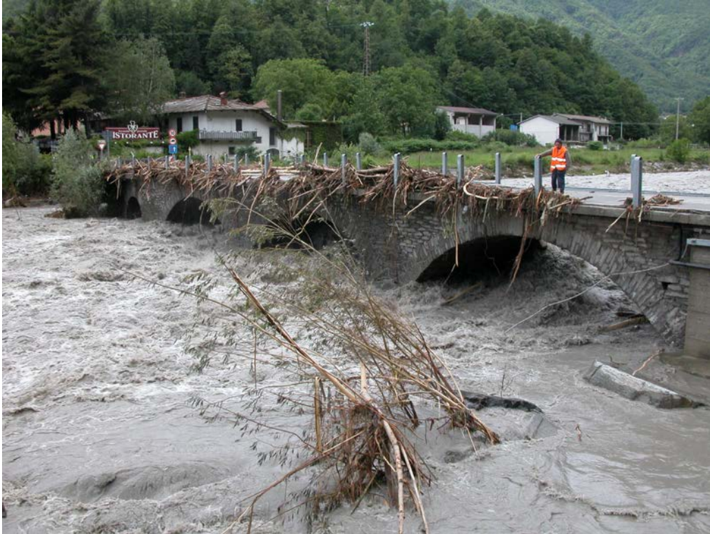
Foto 2.11 - Ponte Palestro nel Comune di Porte sommerso dalla piena. Luce del ponte insufficiente; allagata SS 23 a valle del ponte in sponda sx.
