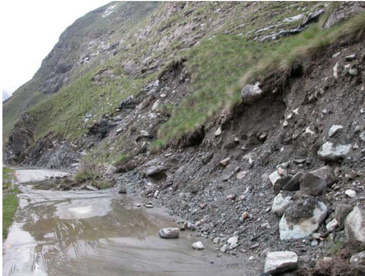
Foto 2.44 e 2.45 – Comune di Usseglio; nei pressi del Lago di Malciaussia la saturazione della coltre eluvio-colluviale ha innescato una serie di fenomeni gravitativi superficiali, con coinvolgimento della sede stradale della S.P. 32 in più punti.
