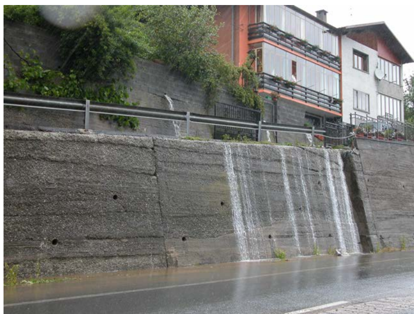
Foto 2.18 - tra Torre Pellice e Villar Pellice. (29/05/08). L'acqua proveniente dal versante, a tratti incanalata in incisioni e a tratti come ruscellamento diffuso, si riversa sulla strada dai barbacani dei muri di sostegno e al di sopra dei muri stessi.
