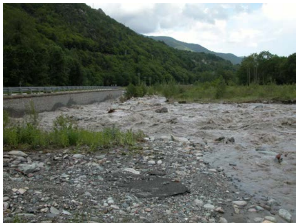
Foto 2.5 e 2.6 - Erosione spondale in sx orografica del T. Chisone tra Perosa Argentina e Roure. Le immagini riportano due punti in cui il T. Chisone si avvicina pericolosamente alla sede stradale della SS 23.
