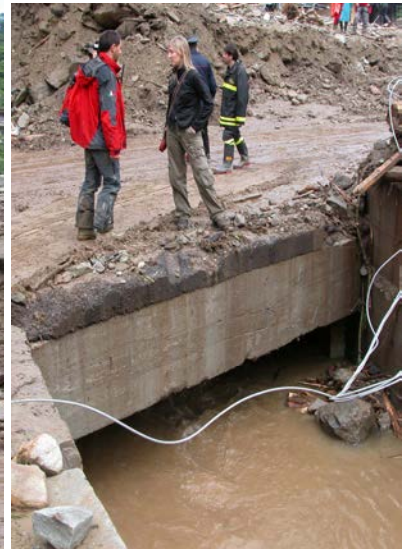
Foto 2.25 e 2.26 - Comune di Villar Pellice. Vista verso monte del debris flow che ha interessato la frazione di Garin. Lo spessore del materiale detritico accumulato è stimabile in diversi metri, come si può vedere rispetto alla strada. La sezione dell'attraversamento sulla SP 161 (vista da valle ) è visibilmente scarsa.
