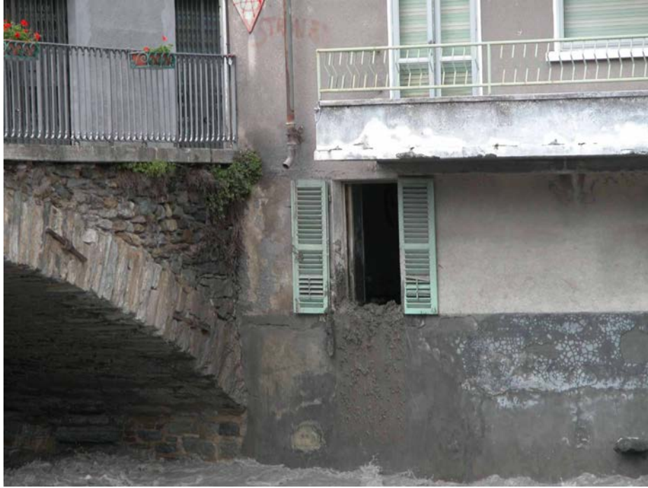
Foto 2.28 - Esondazione della Dora Riparia a Bussoleno, particolare del livello raggiunto dall'acqua in corrispondenza del Ponte vecchio.
