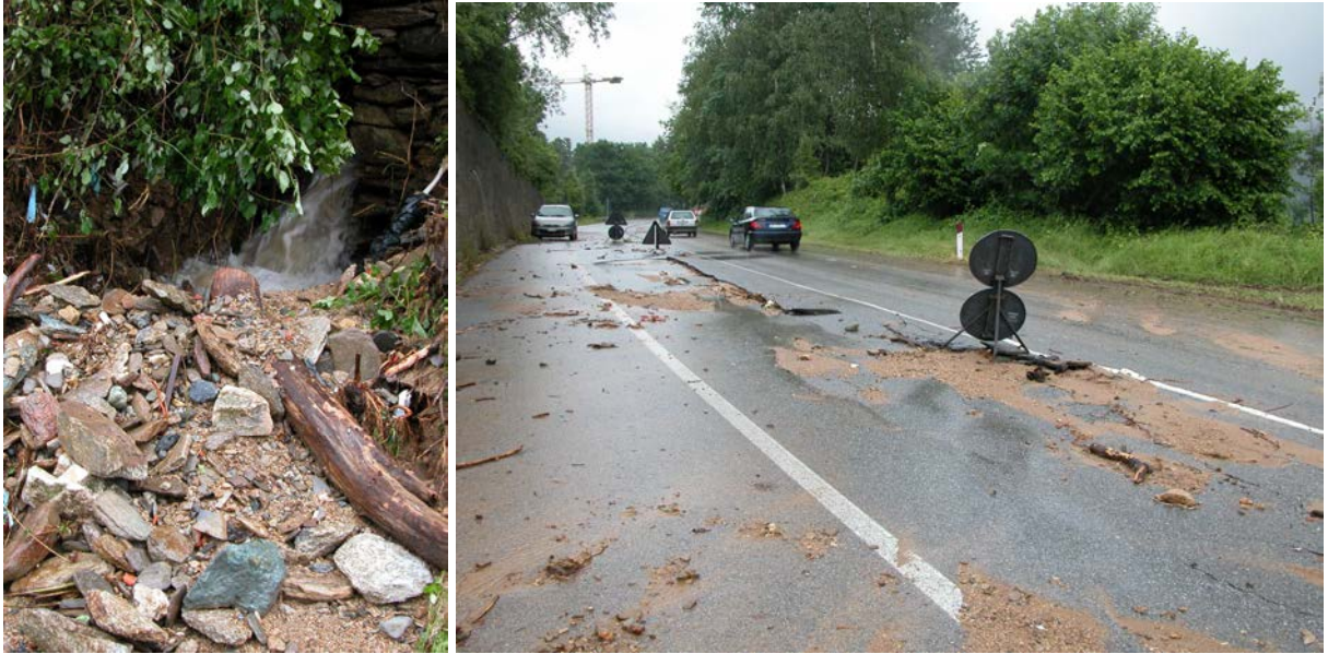
Foto 2.19 - Comune di Torre Pellice. - Frazione Molara. Il sedime stradale è stato danneggiato dall'infiltrazione dell'acqua proveniente da un rio tributario intubato sotto la strada.
