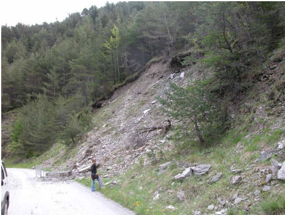
Foto 2.29 – Colate superficiali lungo la S.P.235 per Rochemolles .
