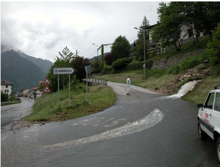
Foto 2.12 e 2.13 - SS 23 bivio per Mentoulles, Comune di Fenestrelle. In seguito all'ostruzione dell'attraversamento sottostrada, un rio anonimo, tributario sinistro del T. Chisone, ha provocato l'allagamento della strada.
