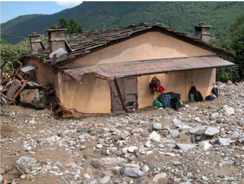
Foto 2.23 e 2.24 - Comune di Villar Pellice. Vista verso valle del debris flow che ha interessato la frazione di Garin distruggendo un'abitazione in cui risiedevano alcune persone e danneggiando pesantemente (23) le abitazioni circostanti.
