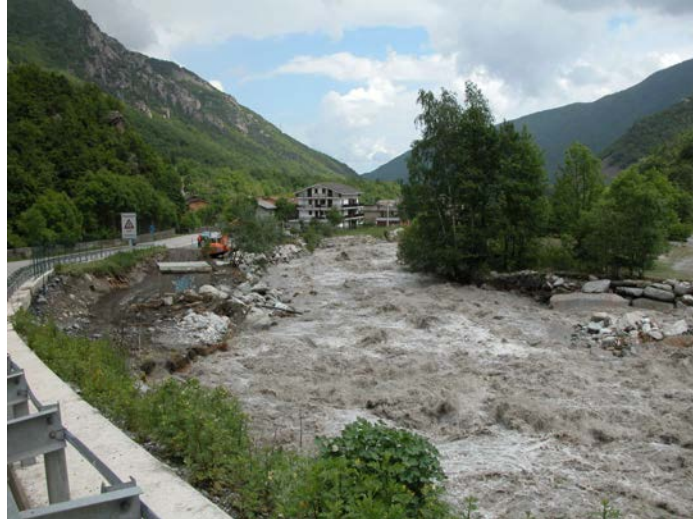
Foto 2.7 - Erosione spondale lungo la SS 23 a monte di Loc. Balma, Comune di Roure. L'erosione in sponda sx è causata dal debris flow sull'affluente dx che ha spinto il Chisone verso sx.
