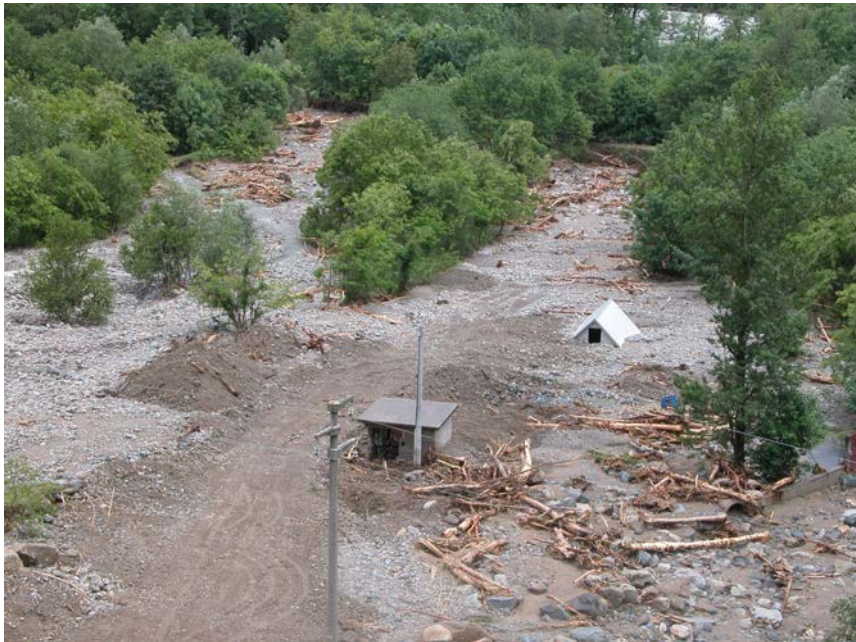
Foto 2.20, 2.21 e 2.22 - Comune di Villar Pellice. Vista verso monte (20) e verso valle (21-22) del debris flow che ha interessato il rio che attraversa l'abitato a est (Rio Rostad). La massa di detrito ha vistosamente eroso le sponde a monte del ponte sulla SP 161, sormontato il ponte e invaso l'area a valle interessando piccoli edifici.
