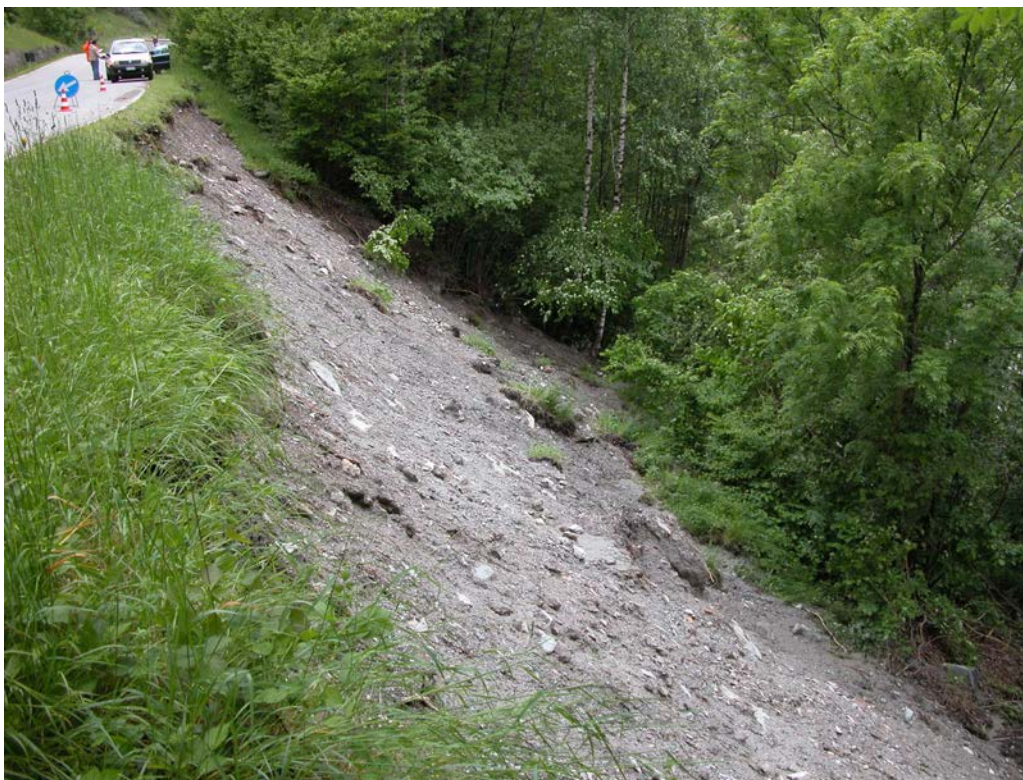
Foto 2.2 - Franamento del versante a valle della SS 23 tra Mentoulles e Depot, Comune di Fenestrelle.
