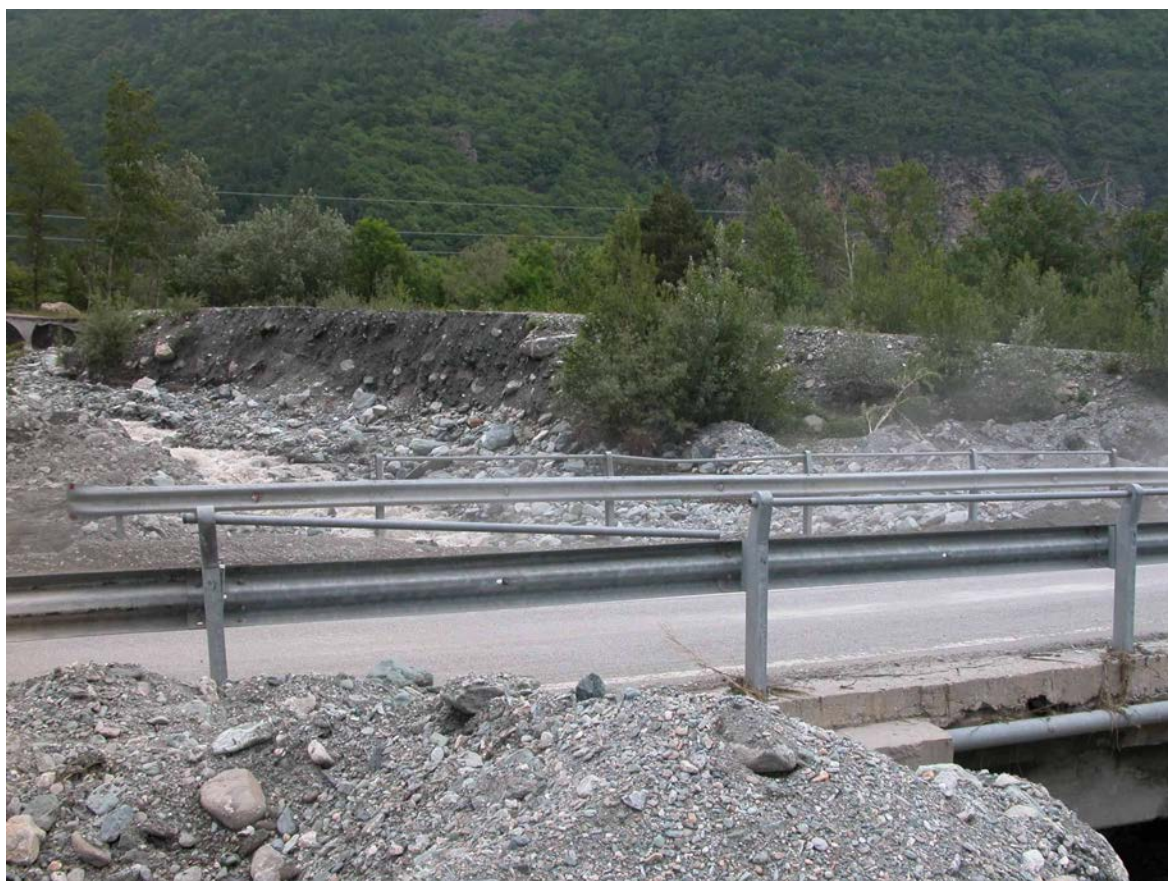
Foto 2.39 – Attraversamento sulla S.P. 210, fenomeno di ostruzione del ponte con superamento dello stesso e importante mobilitazione di materiale in alveo (Rio Crosiglione).
