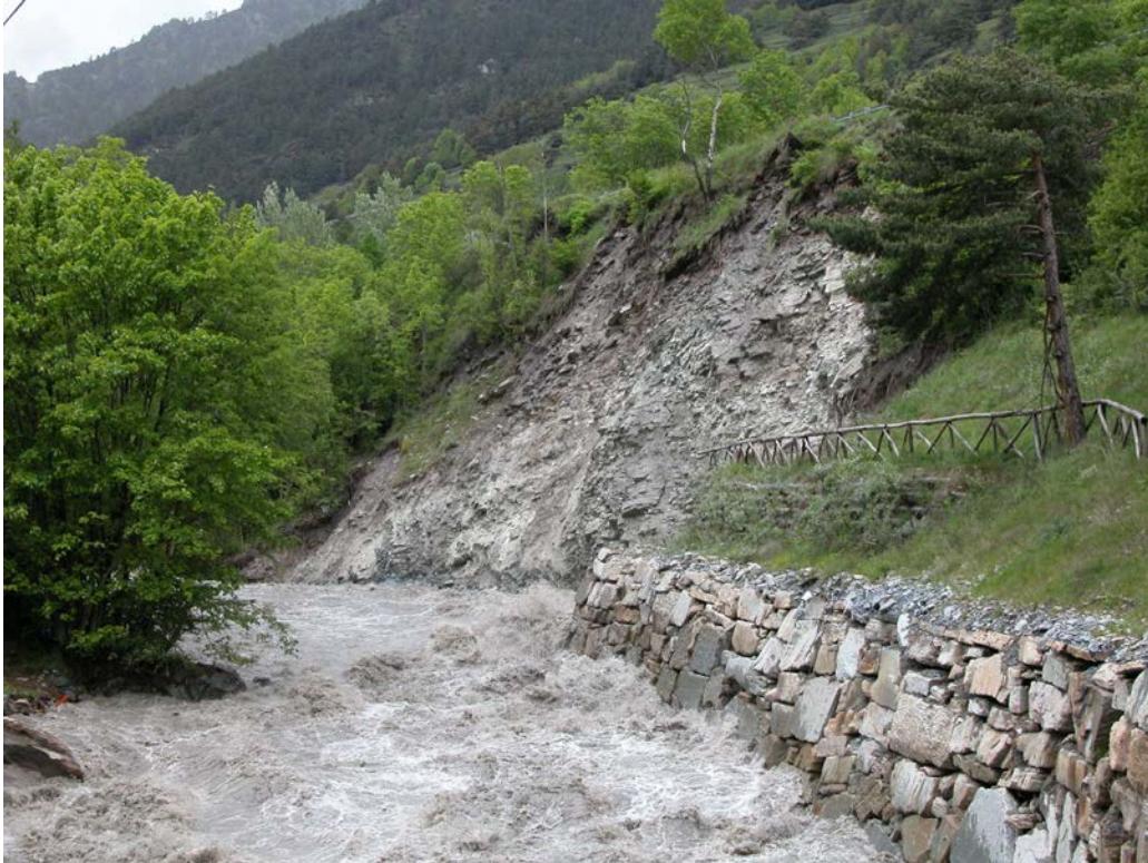
Foto 2.4 - Erosione spondale in sinistra orografica tra Grange e Mentoulles, Comune di Fenestrelle. Lo scalzamento della scogliera ha provocato il franamento del versante a valle della SS 23.
