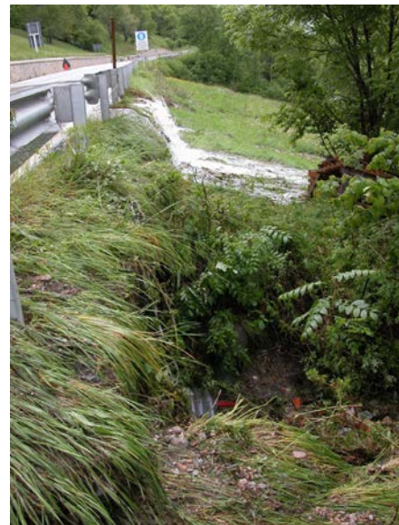
Foto 2.12 e 2.13 - SS 23 bivio per Mentoulles, Comune di Fenestrelle. In seguito all'ostruzione dell'attraversamento sottostrada, un rio anonimo, tributario sinistro del T. Chisone, ha provocato l'allagamento della strada.
