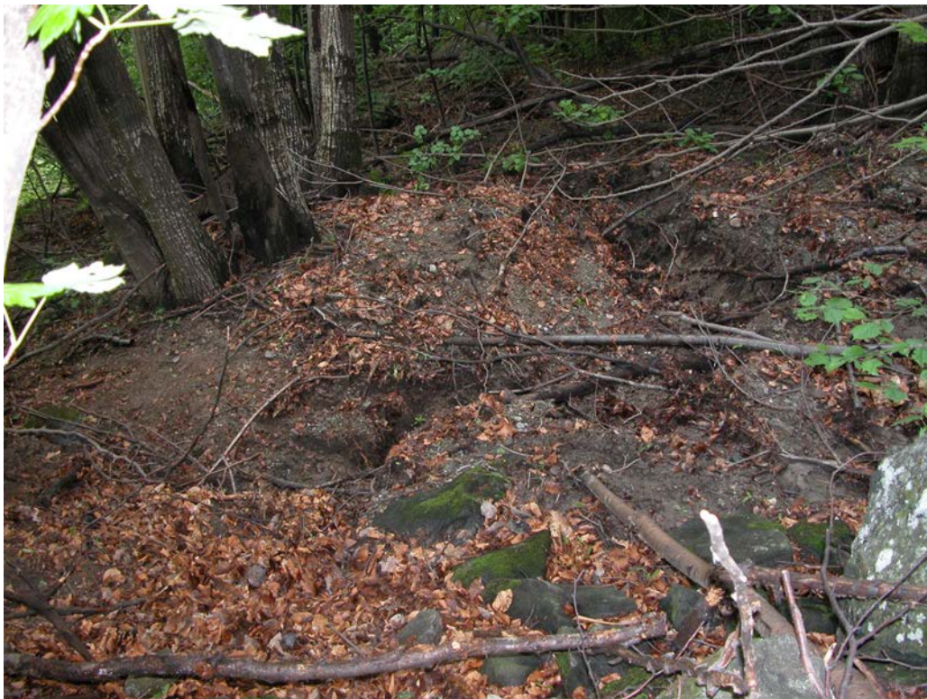
Foto 2.34 e 2.35 – San Giorio di Susa (Rio Angosci) - Fenomeno franoso caratterizzato da mobilitazione del substrato roccioso fortemente alterato e fratturato e della copertura detritico colluviale; nelle foto sono visibili i trench presenti nella zona sommitale.
