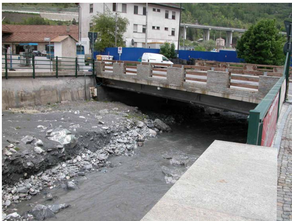
Foto 2.33 – Concentrico di Bardonecchia. Fenomeno di mobilitazione di materiale solido da parte del Rio Frejus..
