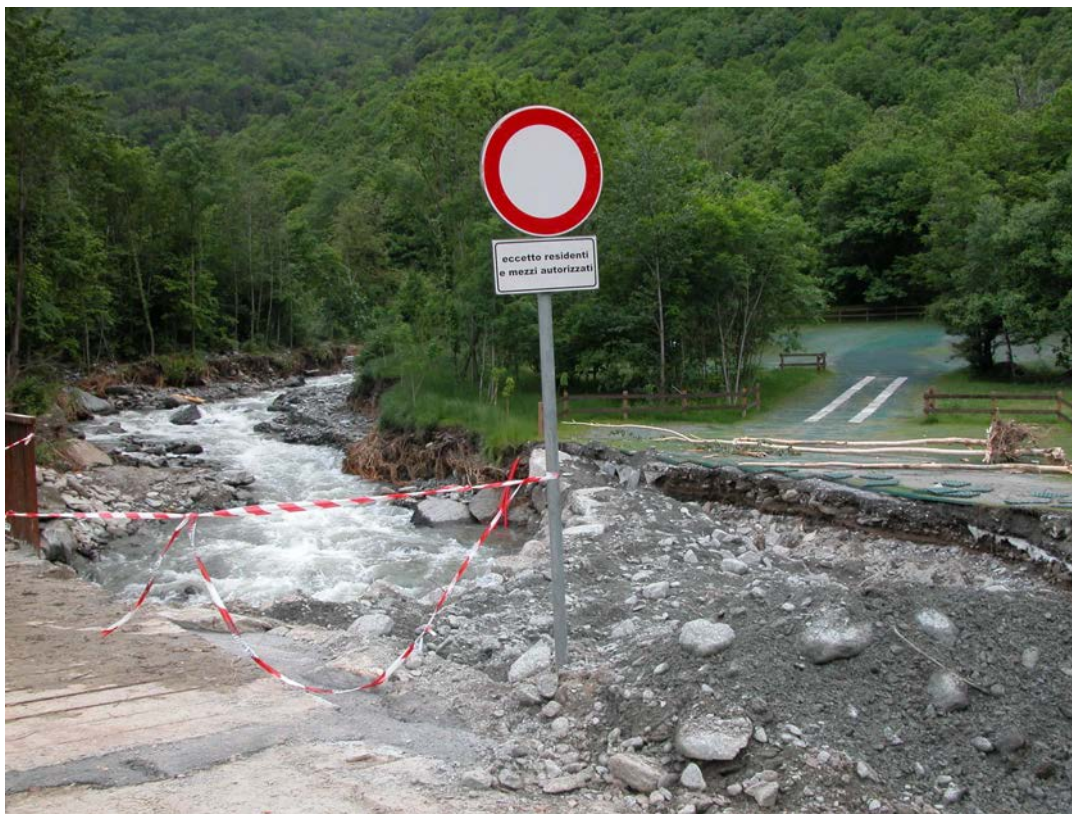
Foto 2.40 – Attraversamento sul Rio Bar (Novalesa). È visibile il consistente trasporto solido e l'erosione della sponda sinistra.
