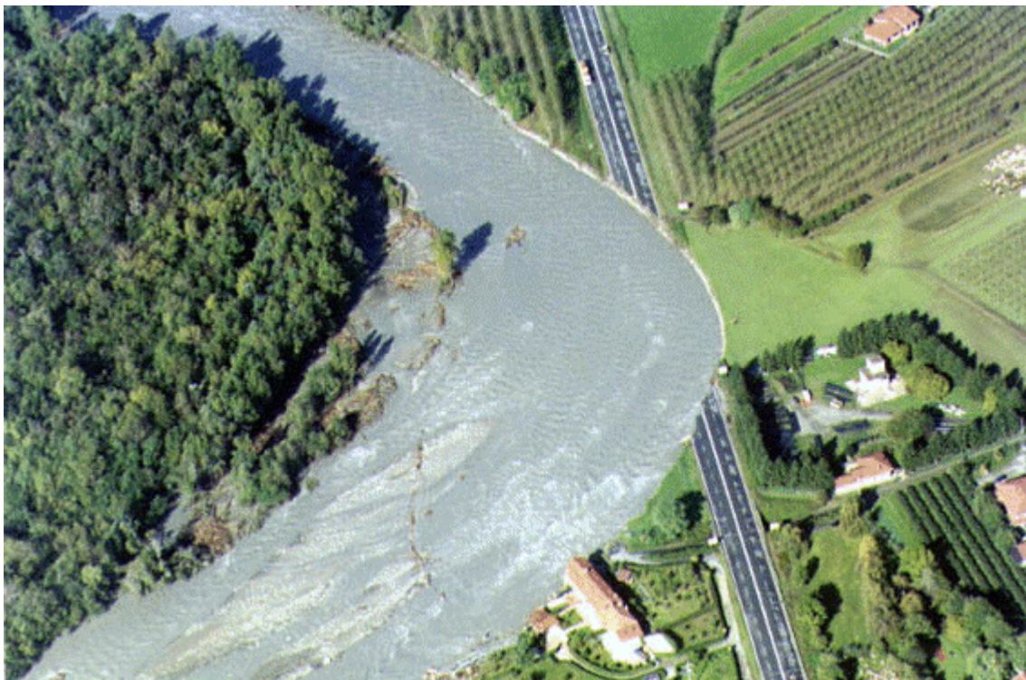
S.S. 23 – Tangenziale di Pinerolo
