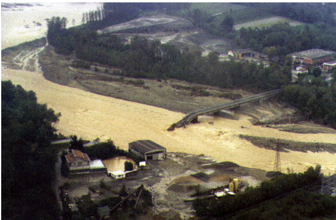
S.P. 18 – Ponte T. Stura di Lanzo
