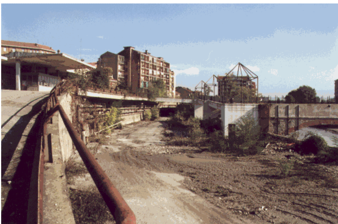
Sponda sinistra del Fiume Dora Riparia con l'imbocco del tunnel ferroviario in disuso.
