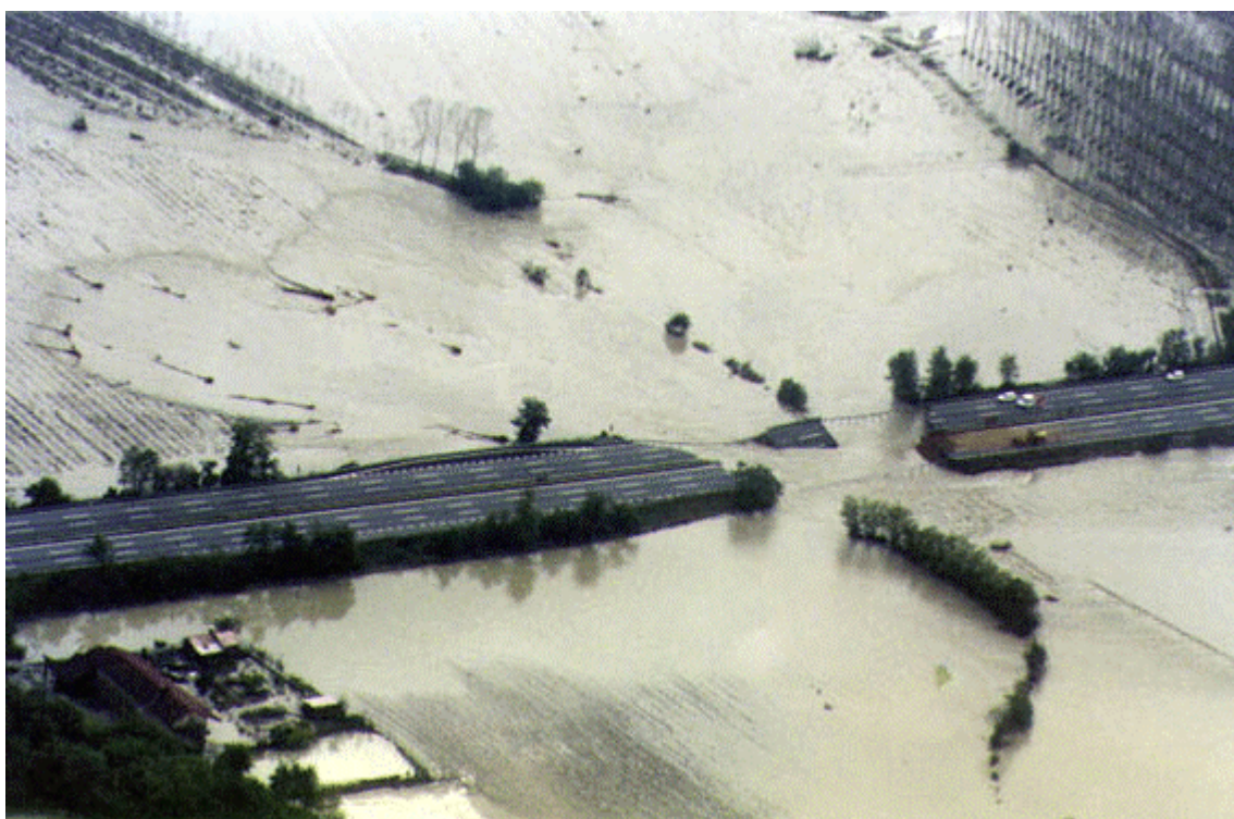
Autostrada Torino-Milano c/o ponte Dora Baltea
