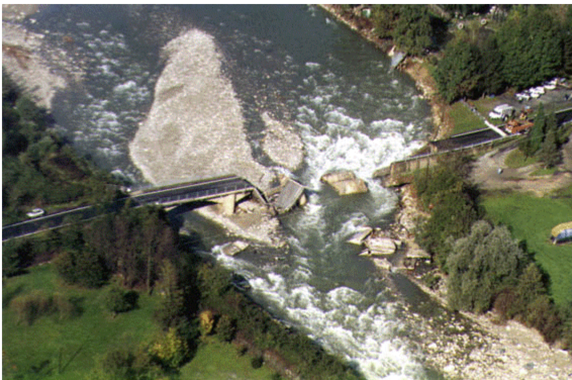
S.P. 193 – Giaveno, ponte sul Sangone
