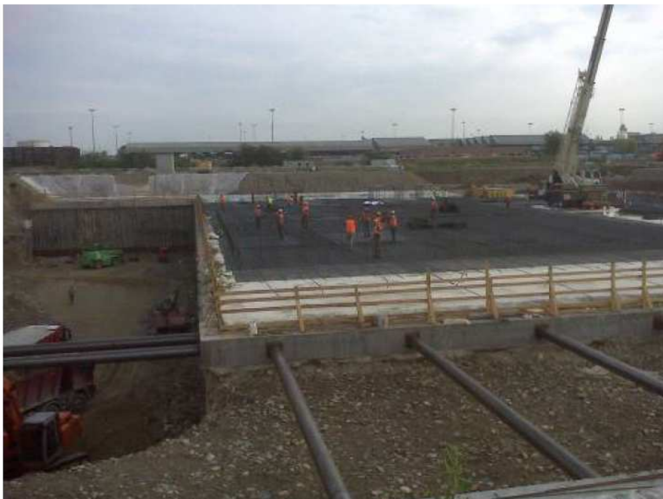
Foto 5 Armatura platea edificio principale zona caldaie
