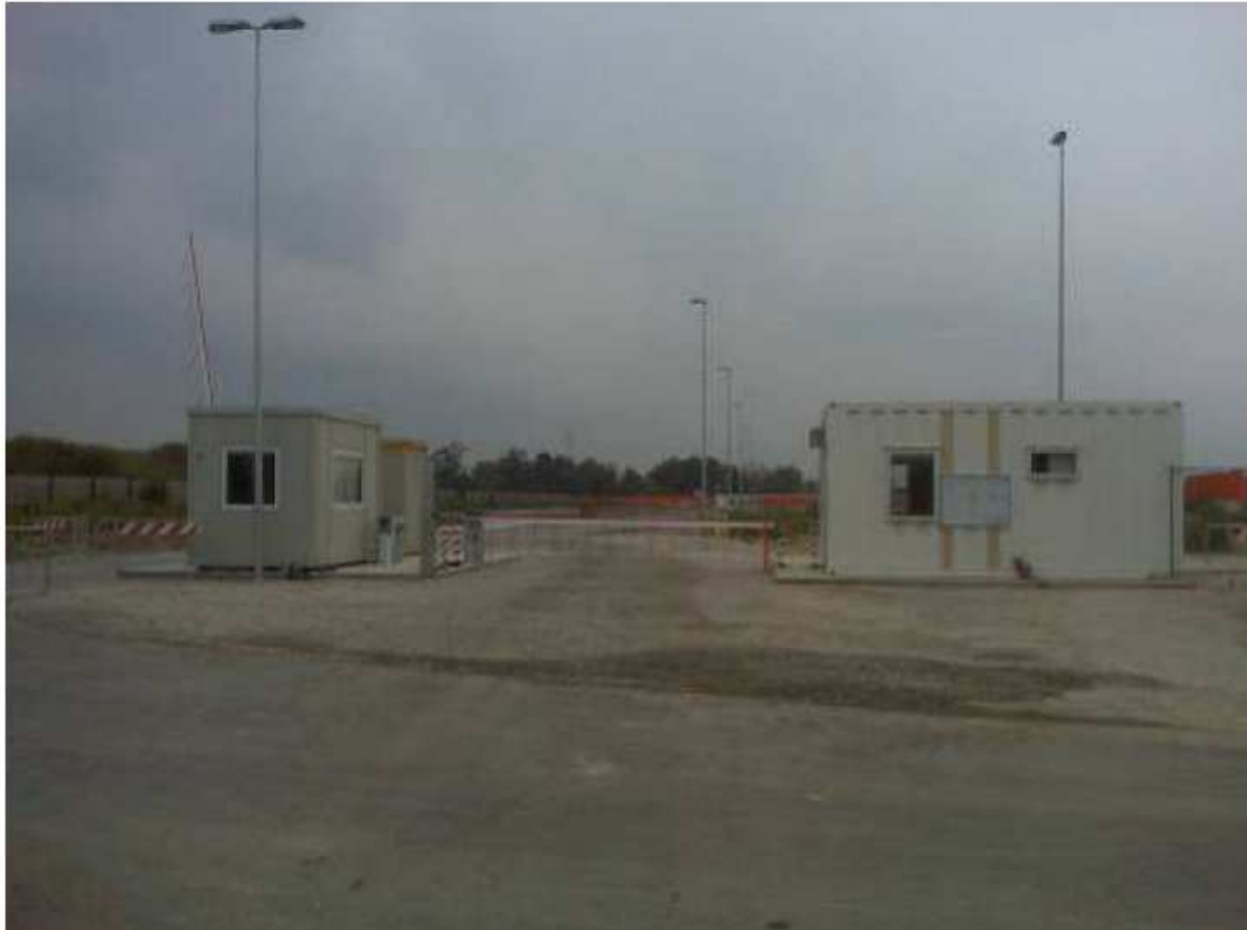
Foto 11 Ultimazione realizzazione controllo accessi
