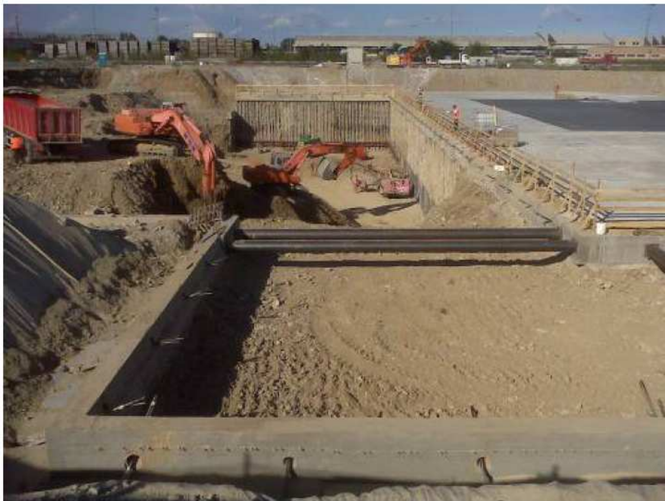
Foto 1 Scavo fossa RSU
