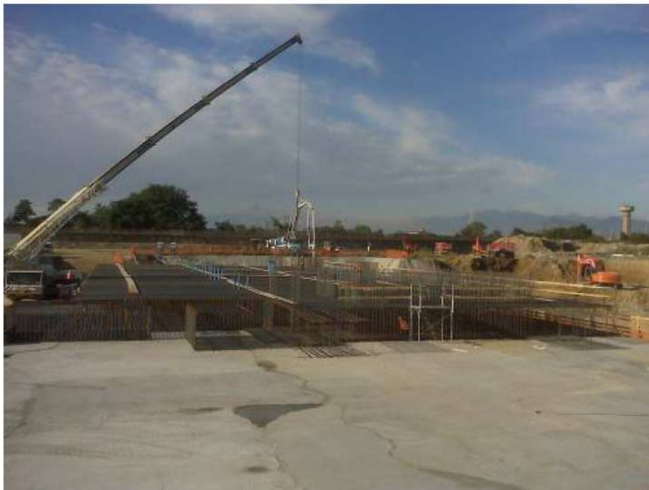
Foto 9 Messa in opera degli ancoraggi macchine
