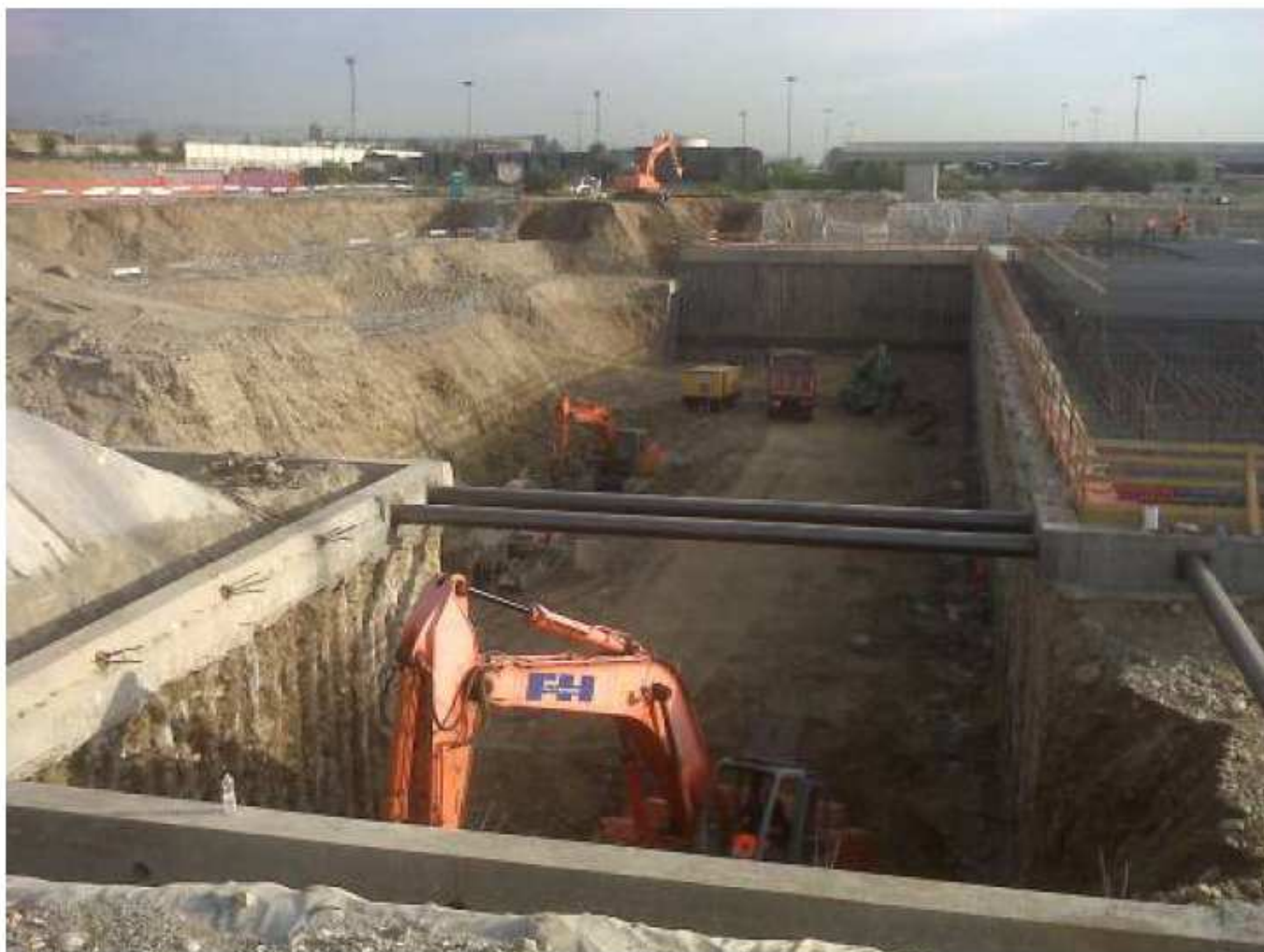
Foto 2 Scavo fossa RSU
