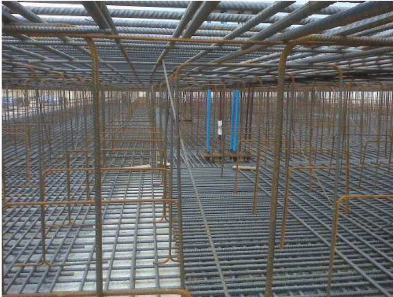
Foto10 Messa in opera degli ancoraggi macchine
