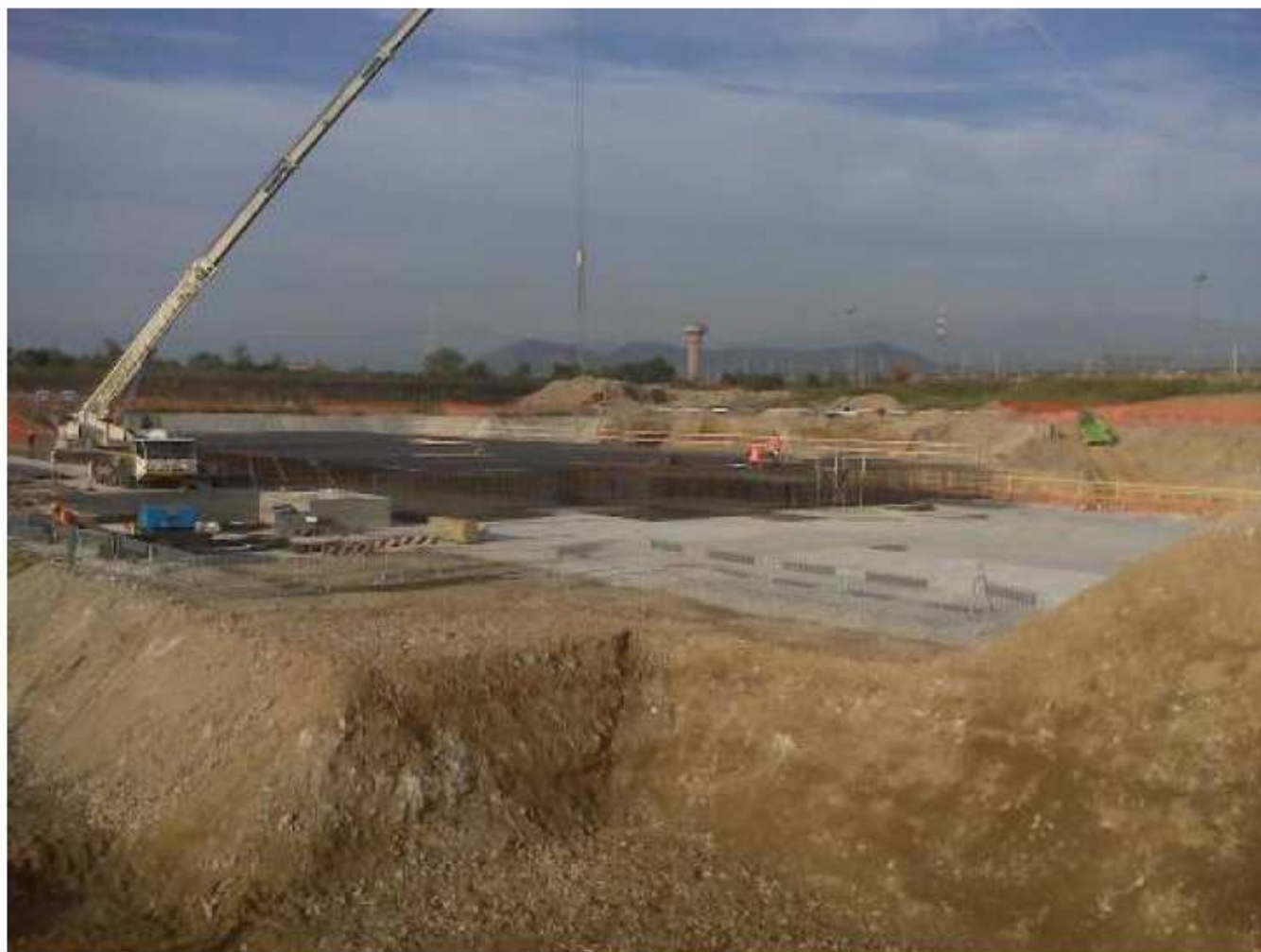
Foto 6 Armatura platea edificio principale zona caldaie
