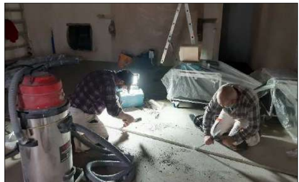
Alloggiamento cavi, resinatura, tracciatura e pittura della rosa dei venti
