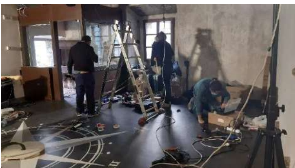
Ancoraggio della struttura circolare portante a soffitto, aggancio dei vari dispositivi (proiettori, altoparlanti, fari spot ecc.), installazione e taratura della consolle centrale.
