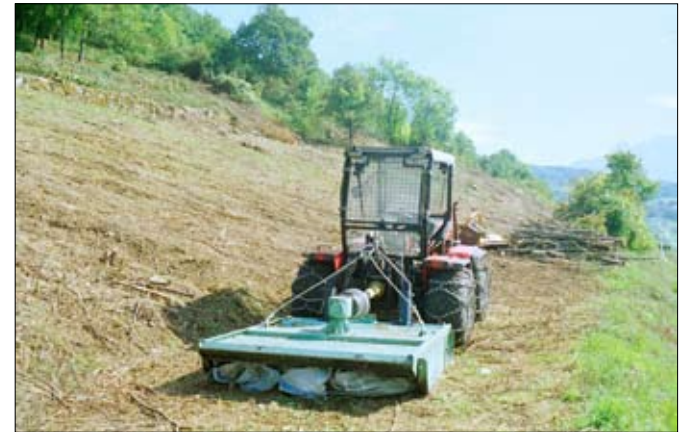
Pulizia del versante, settembre 1999, Jongieux (Savoia).
