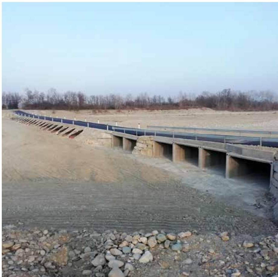
A causa dei fenomeni alluvionali che hanno caratterizzato la pianura torinese negli anni successivi, in particolare nel 2008, 2015 e 2018, la struttura ha subito danneggiamenti che ne hanno ridotto la capacità idraulica rispetto alle previsio-
