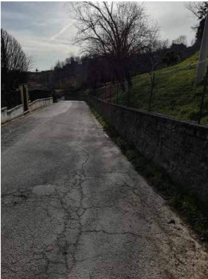
L'ultimo intervento in progetto riguardava un interno di via Massera nei pressi dei confini comunali con San Secondo di Pinerolo e consisteva nella messa in sicurezza della pavimentazione stradale ammalorata, con la scarifica dello strato di usura e il successivo rifacimento del tappetino.
