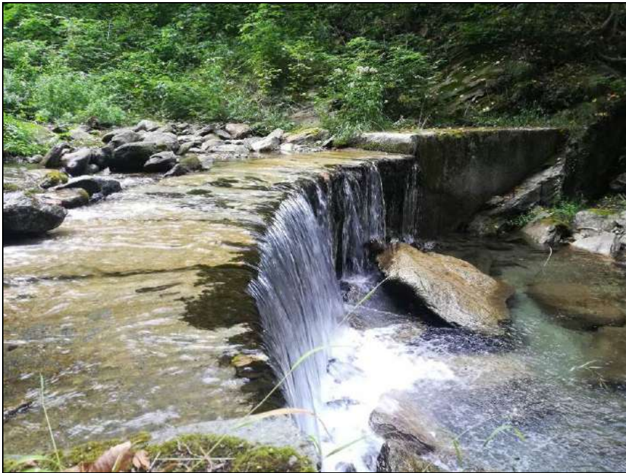
Figura 21.3 – Opera trasversale esistente presso cui si prevede la captazione
