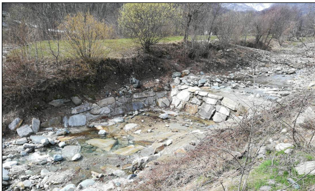
Figura 16 – Soglia presente immediatamente a monte del canale di restituzione
