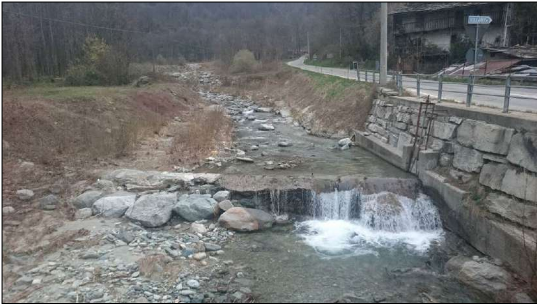
Figura 31.1 – Soglia a valle dell'opera di presa in progetto (esempio di opera esistente nel tratto sotteso)
