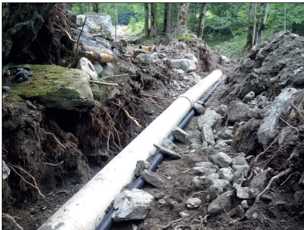
Foto 3 – Posa della condotta in scavo aperto prima del definitivo reinterro. Presenza di ciottoli decimetrici immersi in abbondante matrice sabbioso limosa
