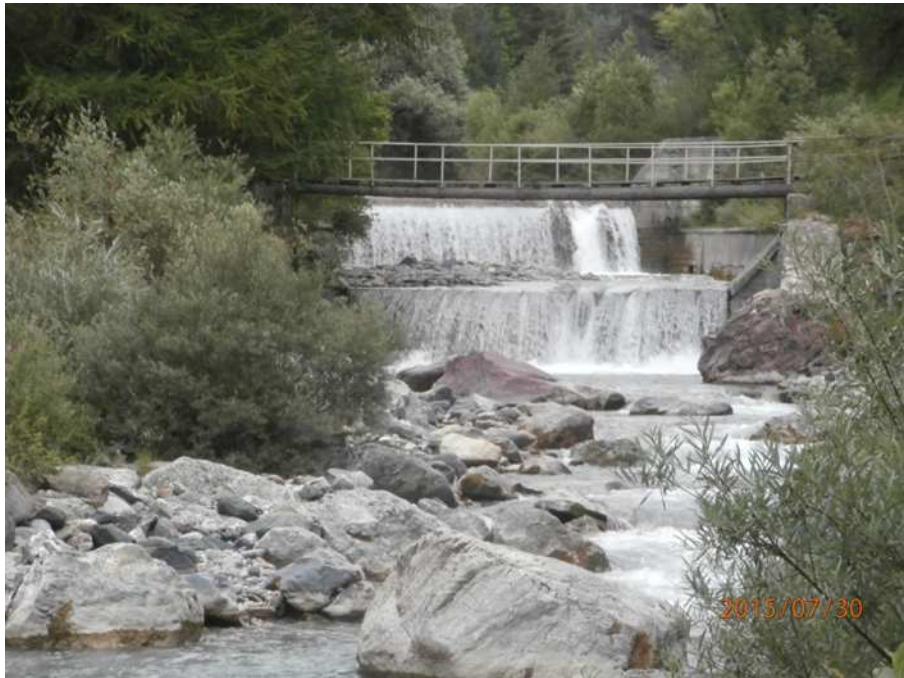
Foto 3: briglie esistenti viste da valle (l'impianto in progetto deriva l'acqua a monte della prima briglia e rilascia dopo la briglia di valle)
