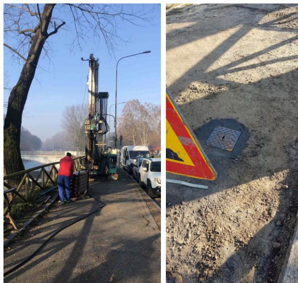
Figura 1 – Esecuzione della perforazione sede del piezometro e chiusino di protezione.
