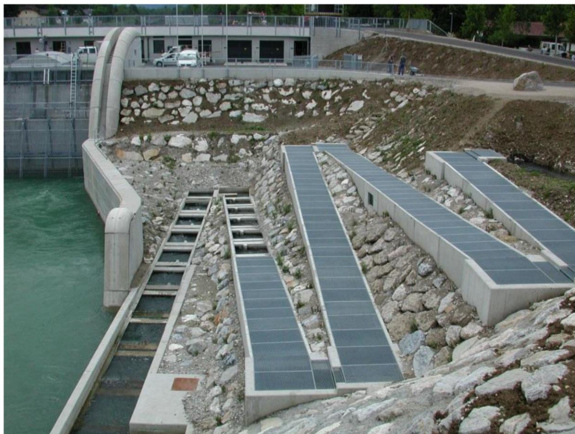
Figura 59. Grigliato su passaggio per pesci (da Rucker e Wittmann, 2005)
