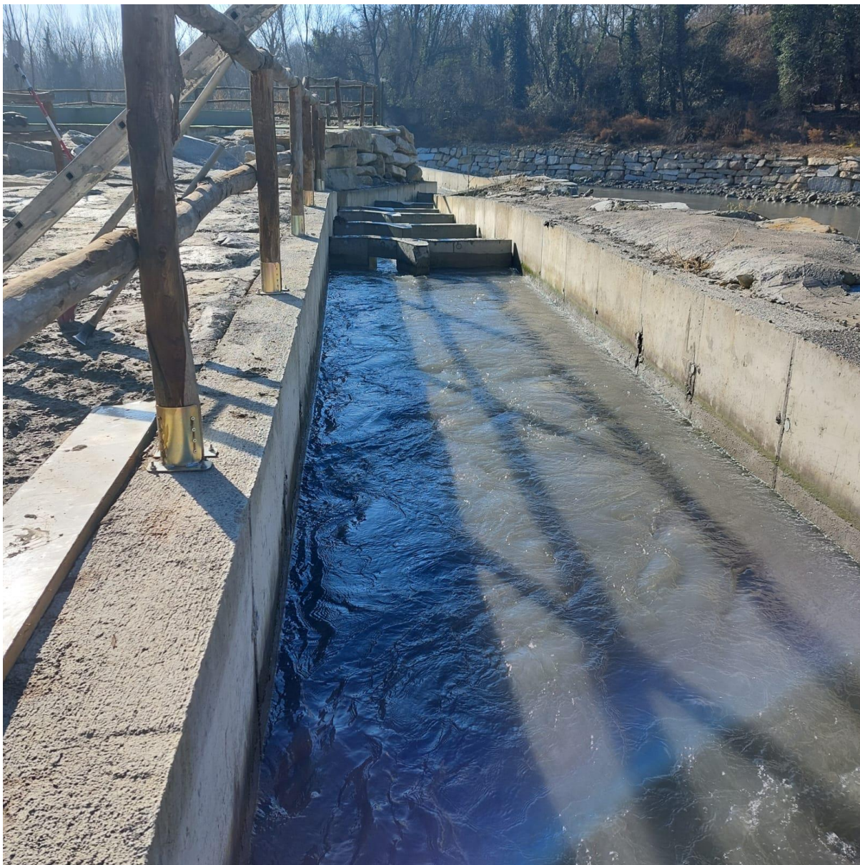
Fotografia 1: Dalla fotografia si vedono le fenditure verticali a comportamento libero
