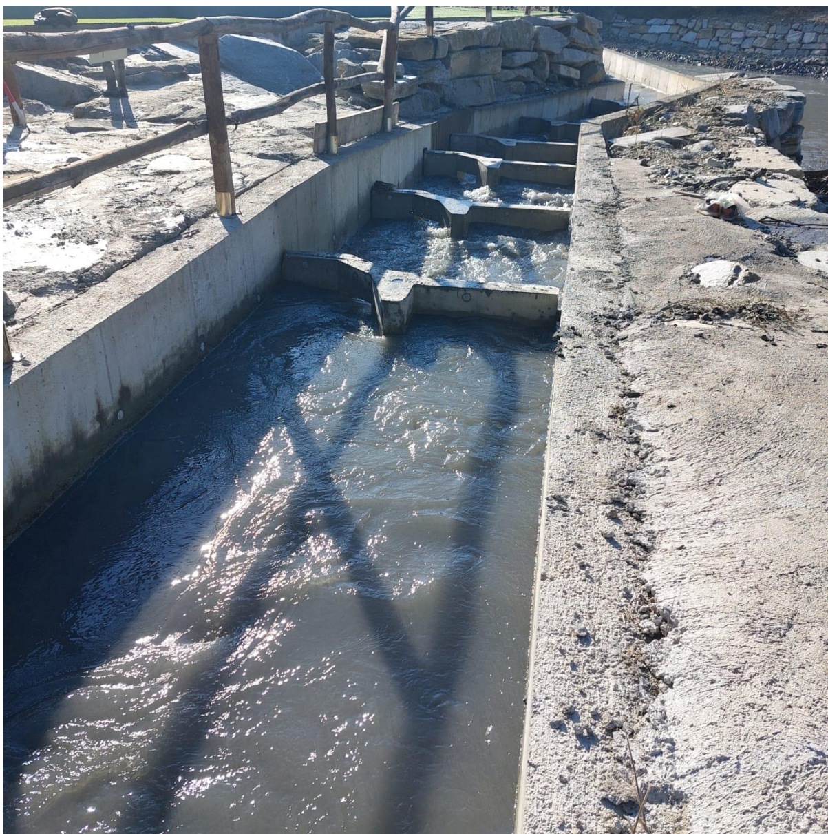
Fotografia 2: Anche in questa fotografia si vedono le fenditure verticali a comportamento libero
