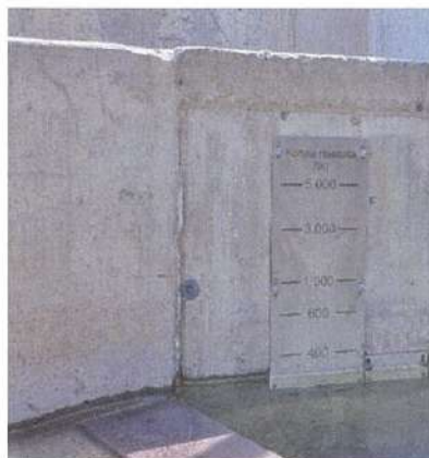
Figura 25 - Dispositivi di rilascio del DMV (sinistra), particolare su sta idrometrica con a fianco piastra indicatrice del livello Q_{DMV} (centra) e cartello modalità di rilascio (destra)
