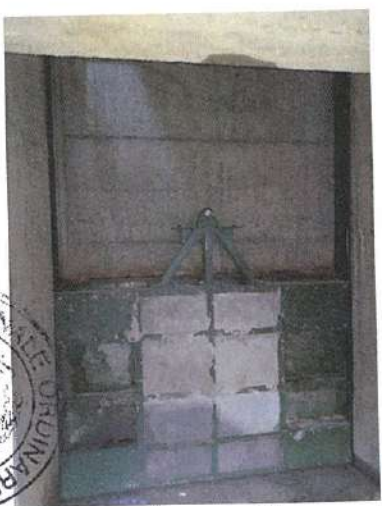
Figura 7 - Paratoia chiusura condotta e paratoia dissabbiatrice
