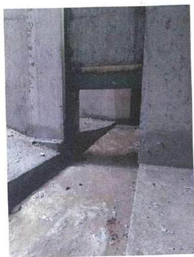
Figura 7 - Paratoia chiusura condotta e paratoia dissabbiatrice
