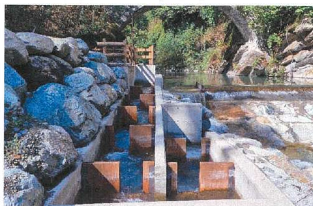
Figura 2 - Passaggio tecnico per l'ittiofauna
