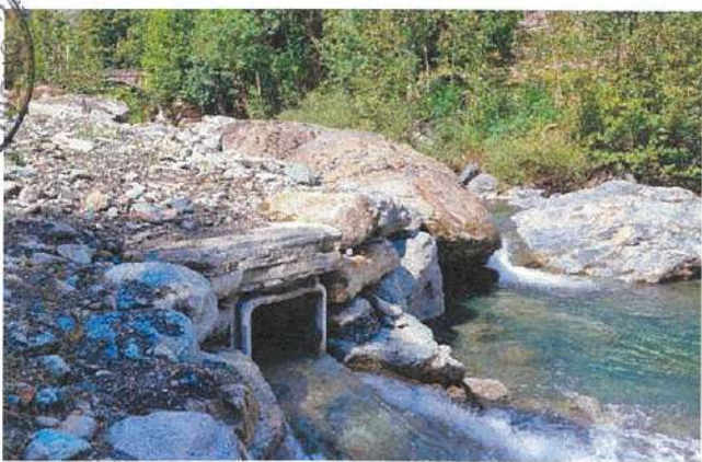
Figura 3 - Scarico in alveo canale sghiaiatore
