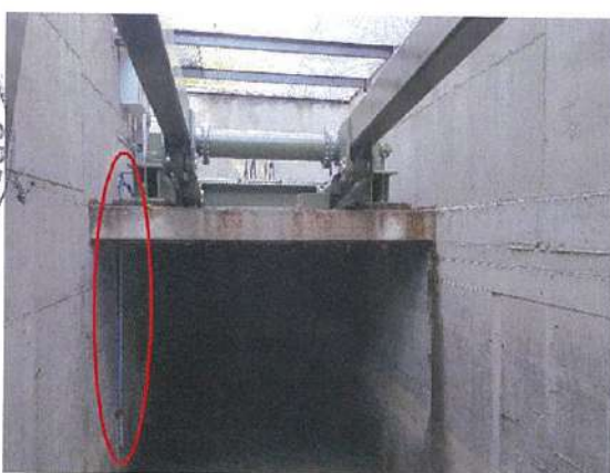
Figura 24 - Misuratore di livello su vasca di carico
