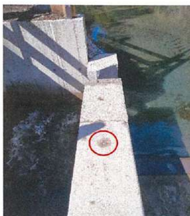
Figura 28 - Caposaldo altimetrico presso l'opera di presa e caposaldo altimetrico presso lo scarico della centrale
