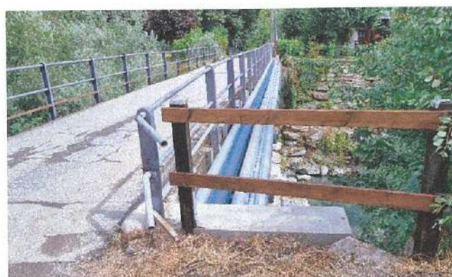
Figura 33 - Opere di connessione staffature su ponte Pellice
