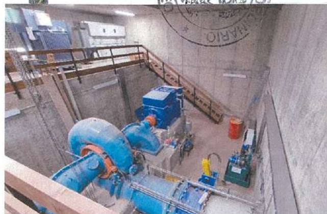
Figura 16 - Centrale idroelettrica foto interna
