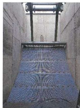
Figura 6 - Vasca di carico e sgrigliatore
