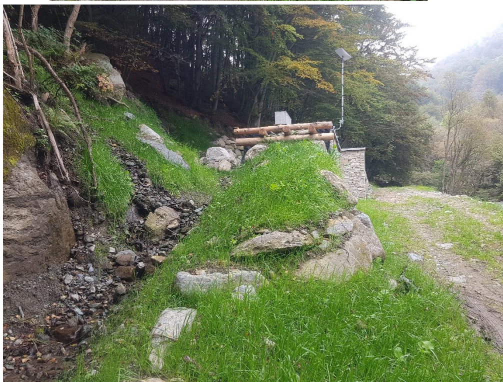
Foto 5 e 6: sistemazioni finali pista e camera di carico con inerbimenti eseguiti
