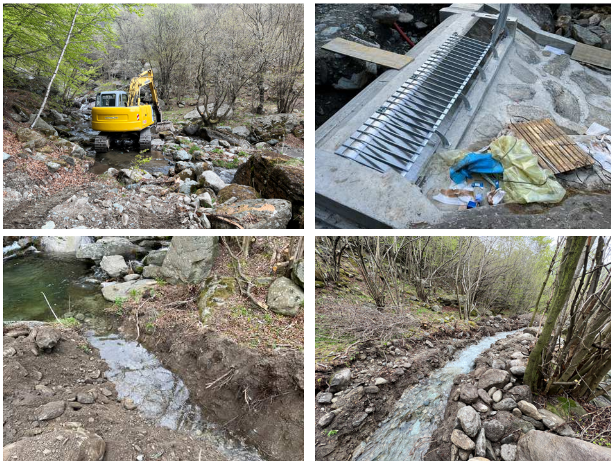
Fig. 4.3 Realizzazione dell'opera di presa e particolare del canale temporaneo di by-pass.
