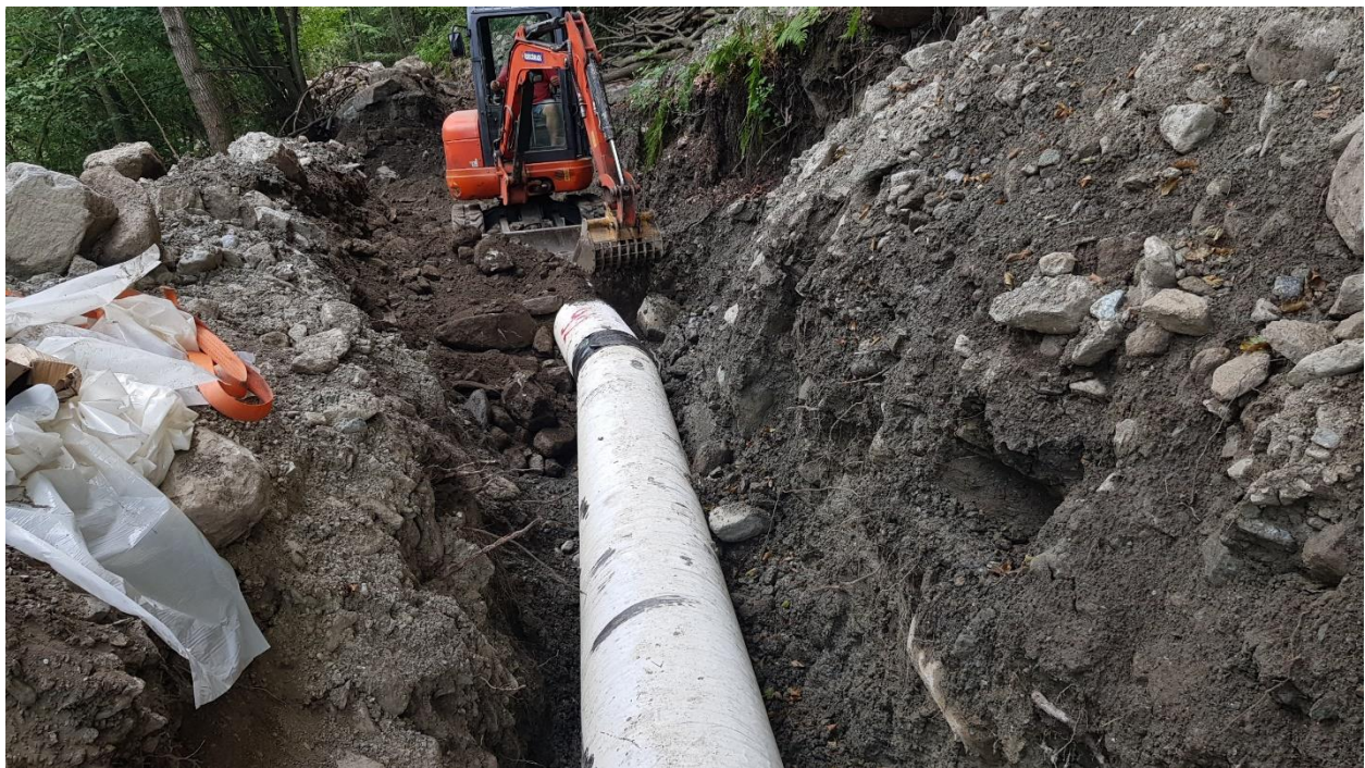
Foto 1: fasi esecutive durante la posa della condotta. Il mezzo impiegato e la trincea di posa della condotta sono al minimo possibile per l'esecuzione di tale lavorazione (si noti la larghezza della trincea di posa confrontata con la dimensione della condotta di diametro 500 mm)
